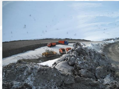
Figura 2.- Construcción de vías de la mina Oleniy Ruchey – Rusia
