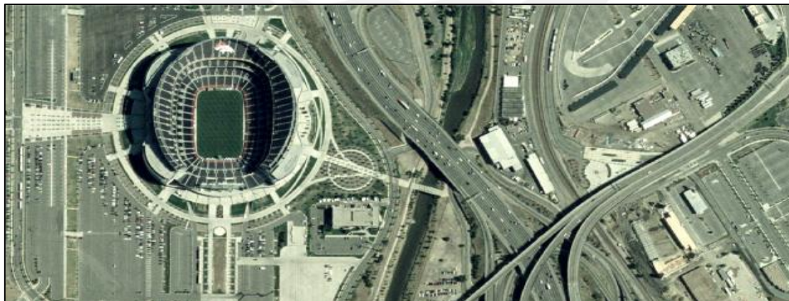
Figura 1.2: Vista aérea de zona urbana desde un UAV [5].
