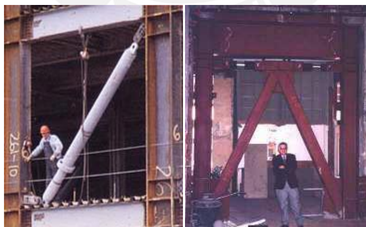
Figura 2.12: Disipadores viscosos en edificios ( www.taylordevices.com/seismic-rehabilitation.html .)
