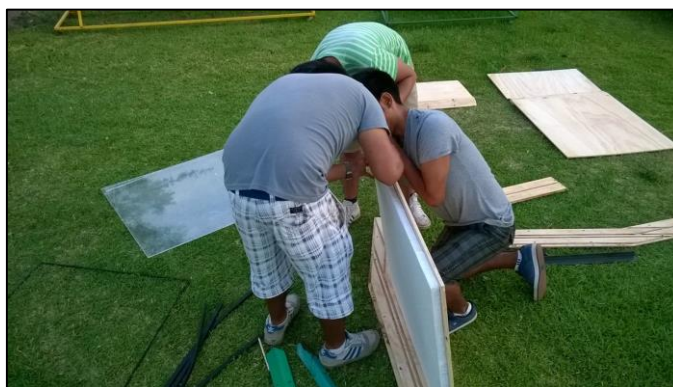
Figura A.1 – Construcción del prototipo.
