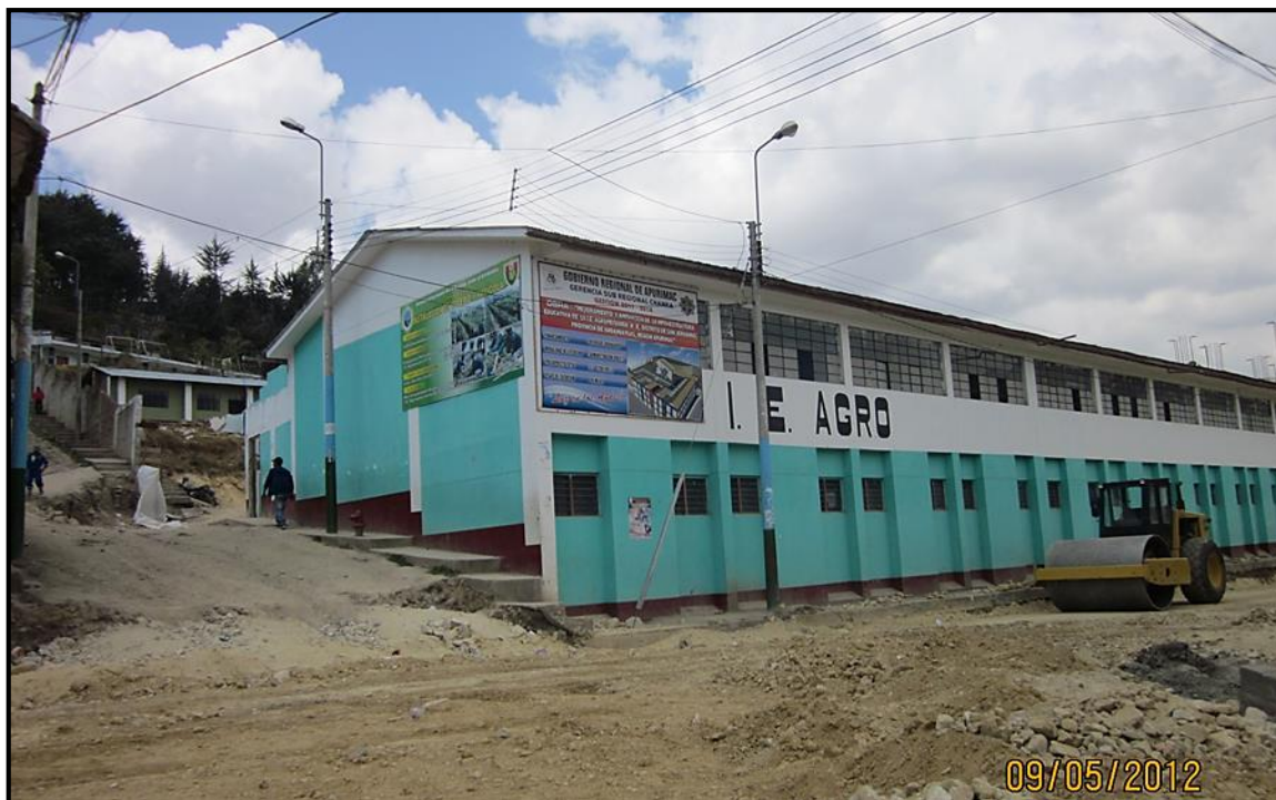
Fachada del Colegio durante el periodo de obras de restauración
