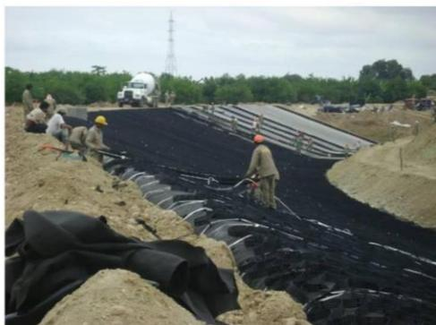
Figura 8. Anclaje e inicio del vaciado de concreto.
