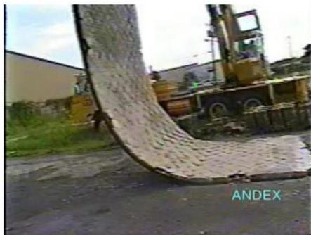
**Figura 1. Flexibilidad del Sistema de Confinamiento Geocelular con Concreto**
