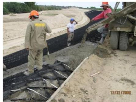
**Figura 2. Vaceado in situ de concreto en las Geoceldas**
