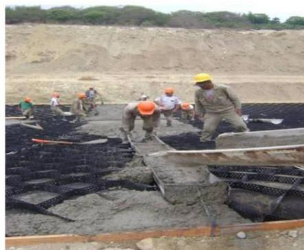
Figura 9. Vaciado de Concreto
