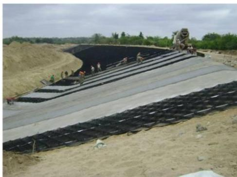
Figura 10. Vaciado del Concreto
