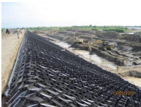
Figura 7. Sistema de Confinamiento Geocelular instalado en el Dique
