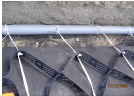
Figura No. 4 En Funcionamiento del Atra Clip
