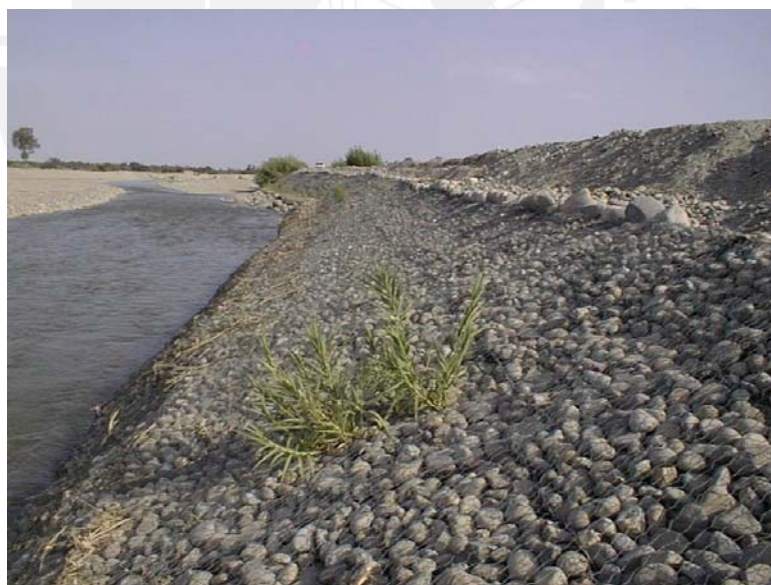
Figura 2-6: Revestimiento de cauce del río Ica mediante colchones de gaviones (TDM, 2015).
