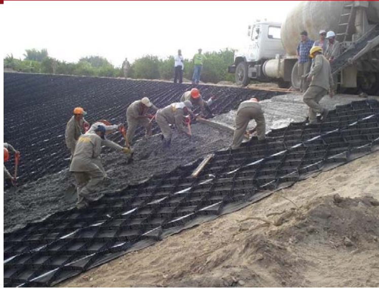
Figura 2-22: Relleno de concreto (TDM, 2015).
