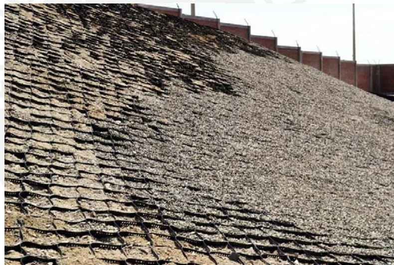
Figura 2-21: Relleno de agregados (TDM, 2015).
