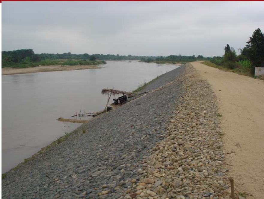
Figura 2-7: Revestimiento de cauce del río Zarumilla mediante colchones de gaviones (TDM, 2015).
