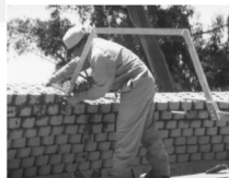
14-9 Colocación de los adobes con la guía rotatoria, La Paz, Bolivia 2000
