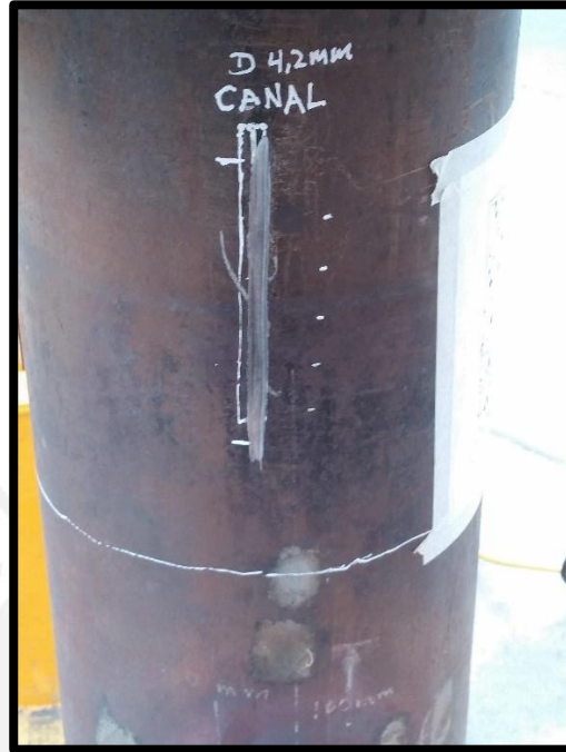
Figura 3.13 - Daño real 2 – CANAL
