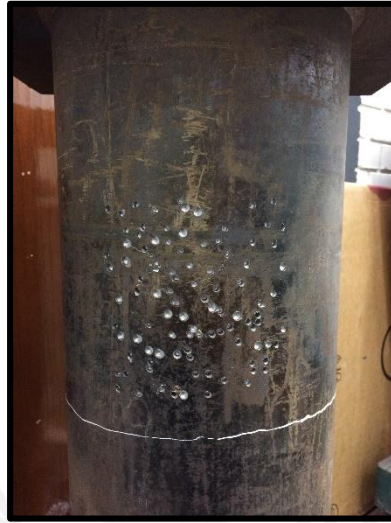
Fig.3.5 Probeta con picaduras, área dañada de 15 cm × 15 cm
