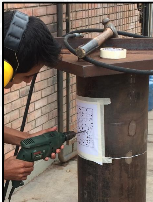
Fig.3.3 Taladrado de picaduras en la superficie de la tubería
