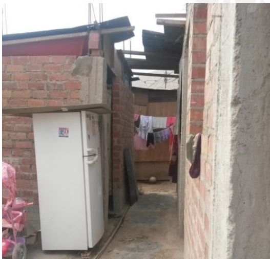
Refrigerador y entrada a dormitorios
