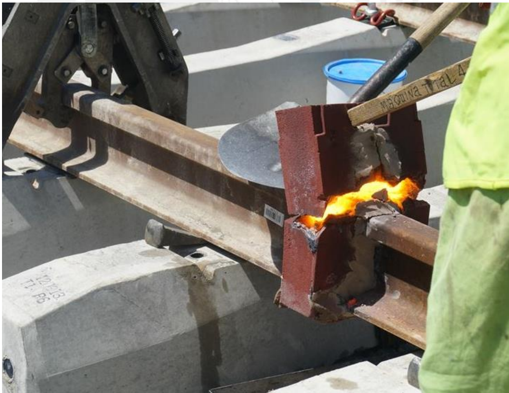
Soldadura aluminio térmica, Valladolid – España
