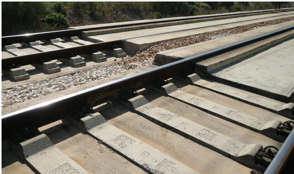
Transición vía en placa Dywidag a Edilon
