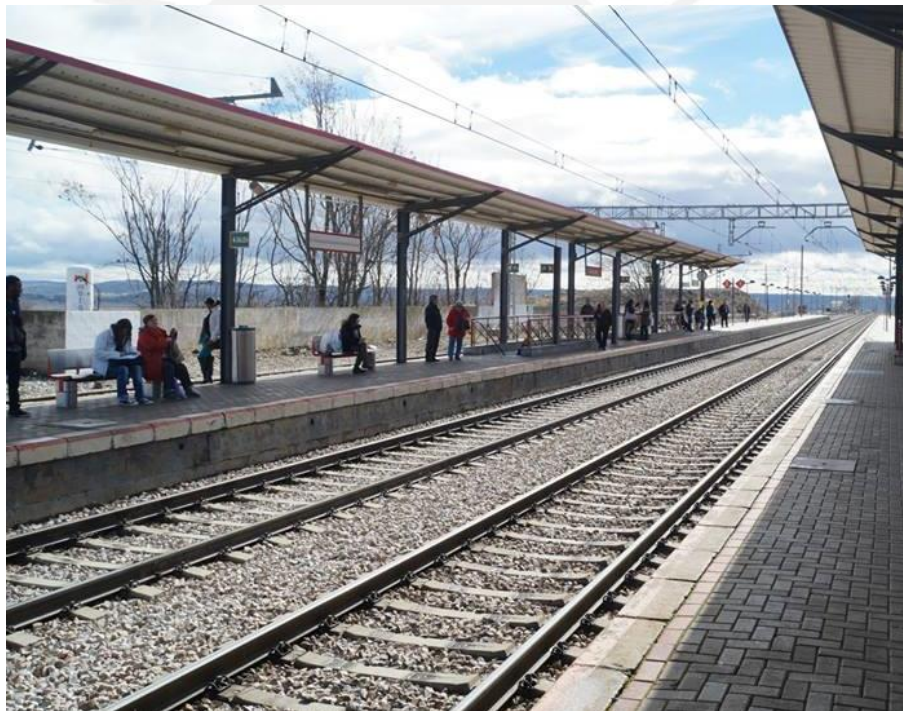
Vía en balasto operativa, estación de Ciempozuelos - Madrid
