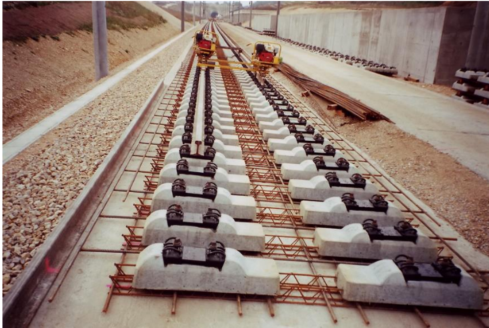
Vía en placa Rheda 2000 antes de vaciado
