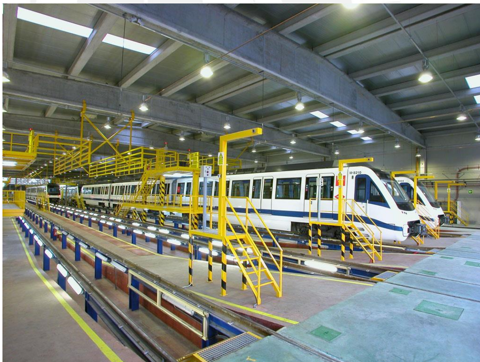
Nave de mantenimiento de Metro de Madrid
