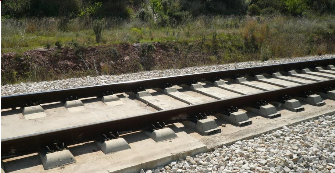
Transición vía en placa Rheda 2000 a Dywidag
