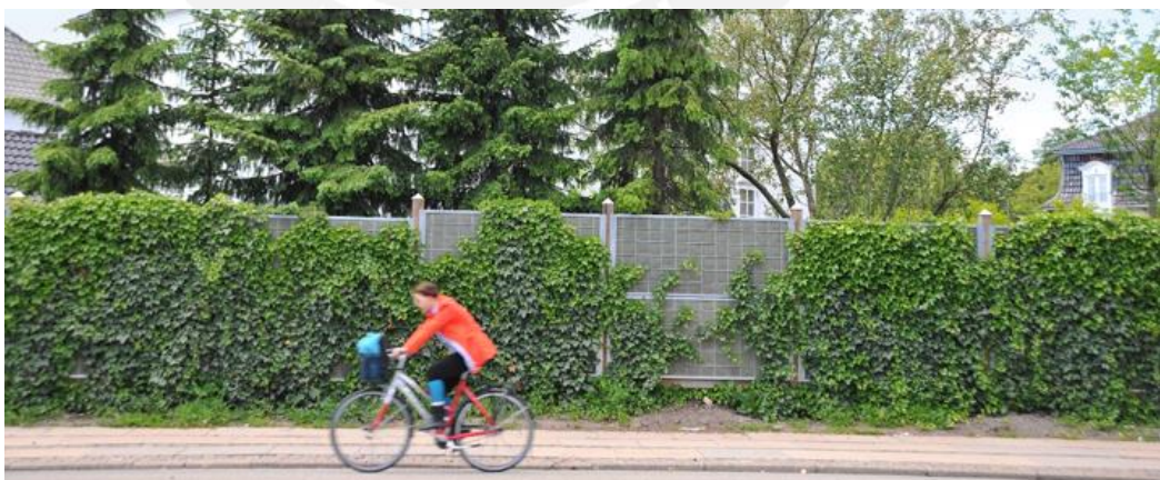
Figura 3.2 Pantalla acústica metálica revegetada
