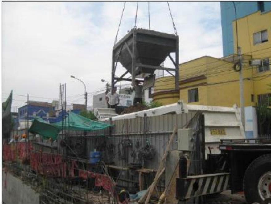
**Comentario:** Como se observa en las imágenes anteriores, el recojo del material se realiza mediante una cuba o recipiente metálico, el cual cumple la función de transportar el material desde la zona de excavación hasta los volquetes.
