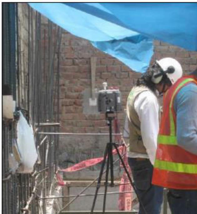
**Comentario:** Por razones de seguridad y de una mejor obtención de datos, el equipo de medición se ubicó a la altura superficial de la obra, es decir, directamente encima de los trabajos de excavación. El periodo de tiempo que tomo las mediciones fue de aproximadamente una hora.
