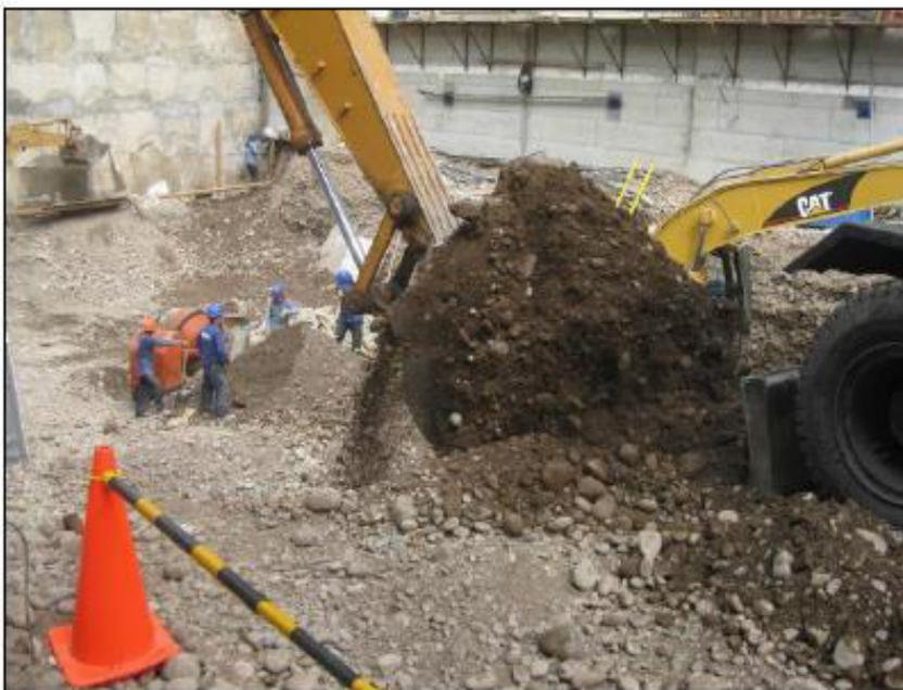
**Comentario:** Para este proyecto, al igual que el anterior, las excavaciones se realizaron mediante el uso de palas mecánicas, la diferencia es que, debido a la baja profundidad de las excavaciones, el depósito del material se realizó directamente a los camiones volquetes y no fue necesario el uso de cubas o recipientes metálicos.
