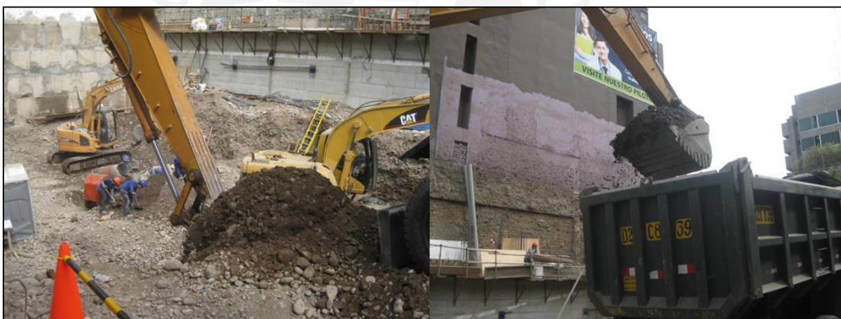
Figura 27 – Excavación y depósito del material al camión volquete.
