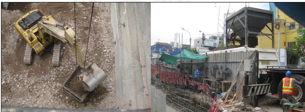
Figura 32 – Depósito del material al recipiente metálico y al camión volquete
