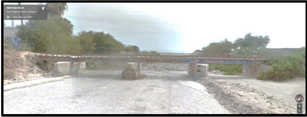
FIGURA 1.03: Puente San José - exterior, google.maps
