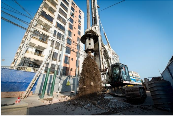
Fig. 5.5 – Perforación de pilote: Intercambio Vial a Desnivel Benavides (Odebrecht, 2014)
