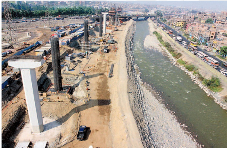
MONUMENTAL. Así se construyó la línea del tren eléctrico que transportará a las personas hasta San Juan de Lurigancho y que funcionará pronto.
