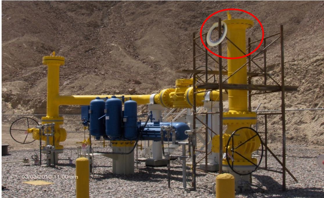
Válvula de GN de Perú LNG. Para ventear se saca la brida
