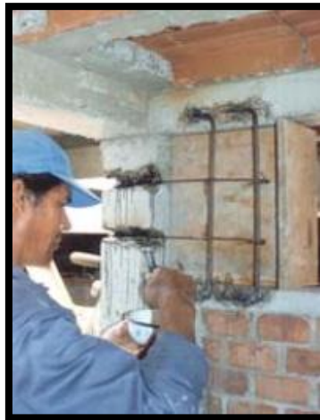
Figura 9.- Detalle del reforzamiento
