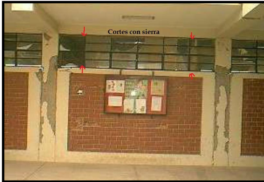
Figura 48.- Detalle del corte necesario para colocar el ensanche de columnas
