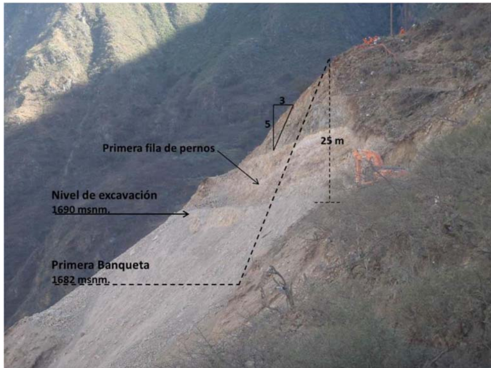
Foto 4.02. Vista en perfil de los trabajos de excavación en el punto fijo del blondin (Fuente CRM-CHCDA).
