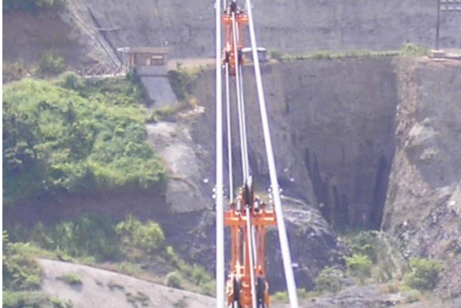
Foto 3.10. Distanciadores doble péndulo (Fuente CRM-CHCDA).
