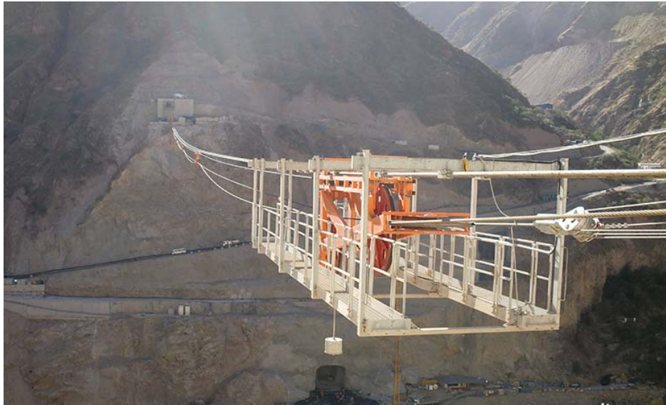
Foto 3.01. Sistema blondin (Fuente CRM-CHCDA).
