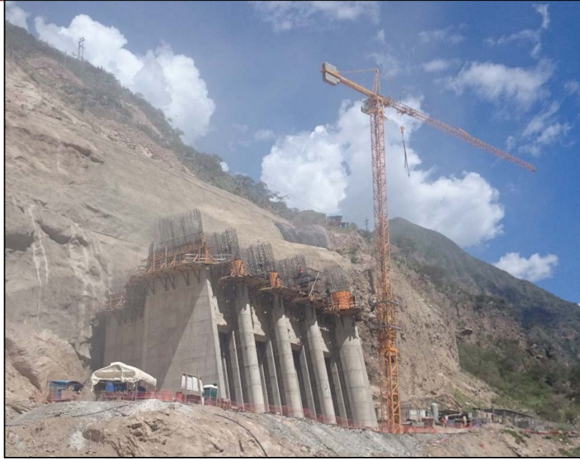
Foto 2.01. Obra de toma (Fuente propia).
