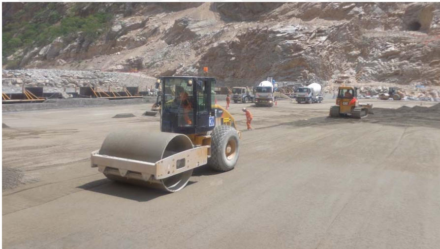
Foto 2.05. Vaciado del concreto compactado con rodillo (CCR) (Fuente propia).
