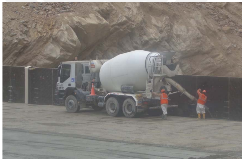
Foto 2.04. Vaciado del concreto convencional vibrado (CCV) (Fuente propia).
