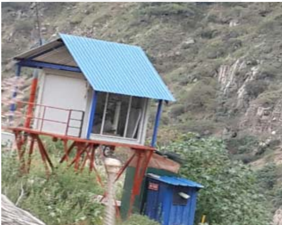
Foto 3.07. Cabina de mando (Fuente propia).
