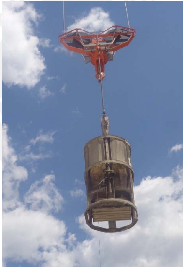
Foto 3.15. Cubeta de vaciado (Fuente propia).
