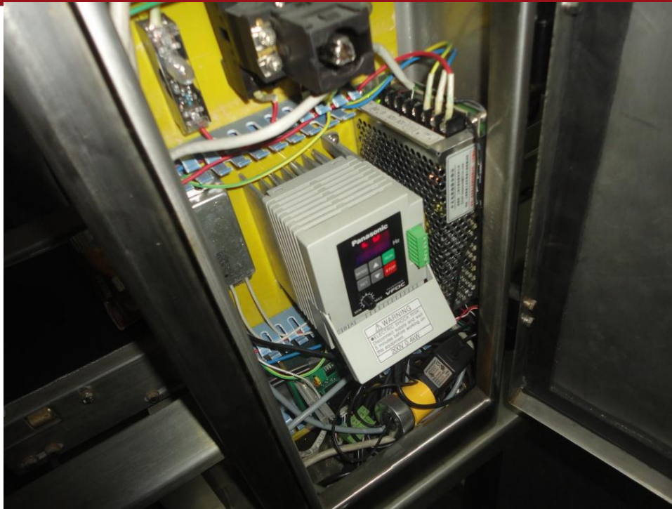
Figura 4.2: Variador de frecuencia dentro de la Balanza dinámica.
