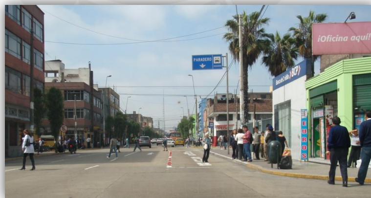
Figura 2.43: Peatones cruzando la calzada en distintas zonas por falta de cruceo peatonal.
