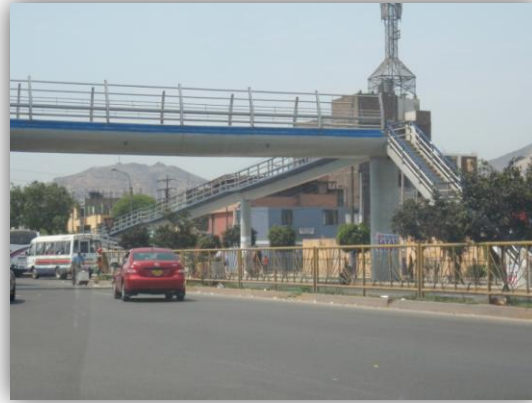
Figura 2.41: Puente peatonal con rampa para discapacitados.
