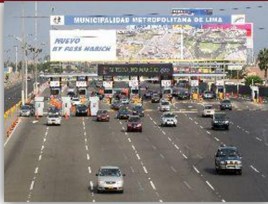
Figura 2.30: Carretera Panamericana Sur en Verano, vía de tránsito reversible.
