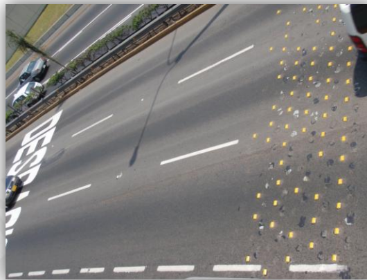
Figura 2.22: Tachas utilizadas para reducir la velocidad de los vehículos que circulan en vías expresas.
