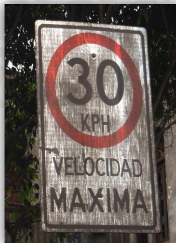
Figura 2.25: Señal vertical reguladora “Velocidad máxima” con falta de mantenimiento.
