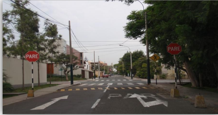
Figura 2.26: Vía con señales verticales, horizontales, cruce peatonal y reductor de velocidad.
