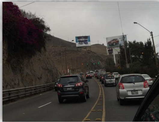
Figura 2.31: Carril reversible en la Av. Raúl Ferrero (La Molina) durante periodos pico.
