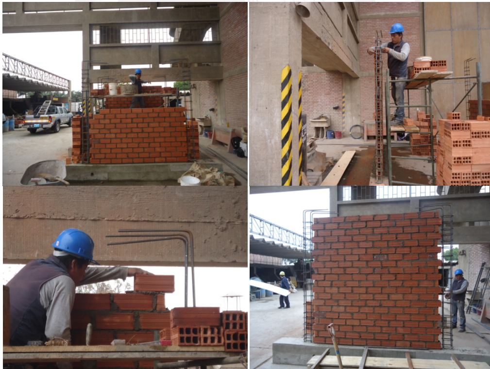
Fig. N° 32: Construcción de los muros de albañilería.
