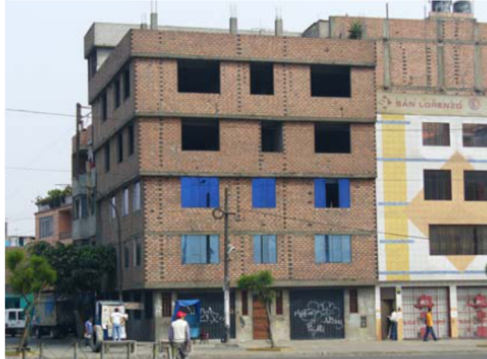
Fig. N° 2: Construcciones de 5 pisos con ladrillo pandereta. (Salinas y Lázares, 2007)
