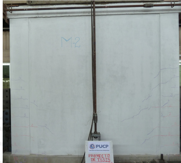
Fig. N° 53: Fisuras horizontales en las columnas y fisuras diagonales en la albañilería – Fase 03 (MR-02).
