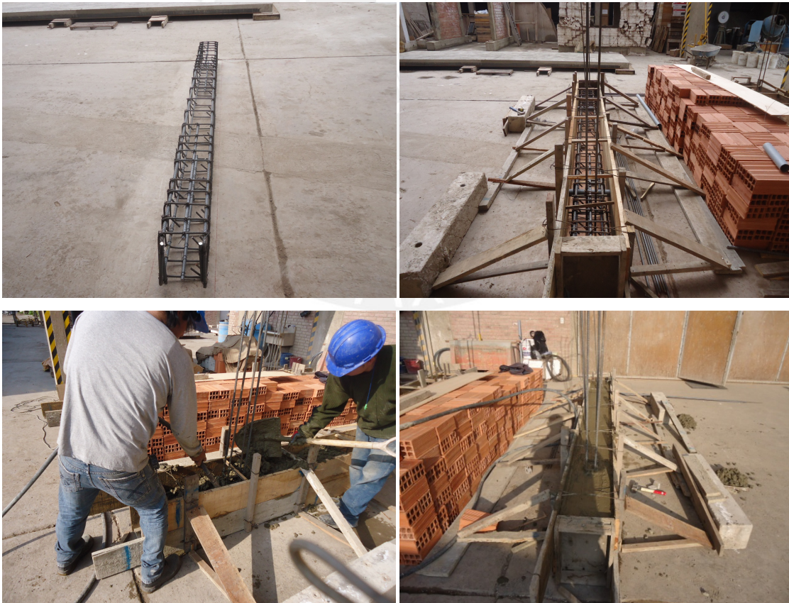
Fig. N° 31: habilitación de acero, encofrado y vaciado de la viga de cimentación.
