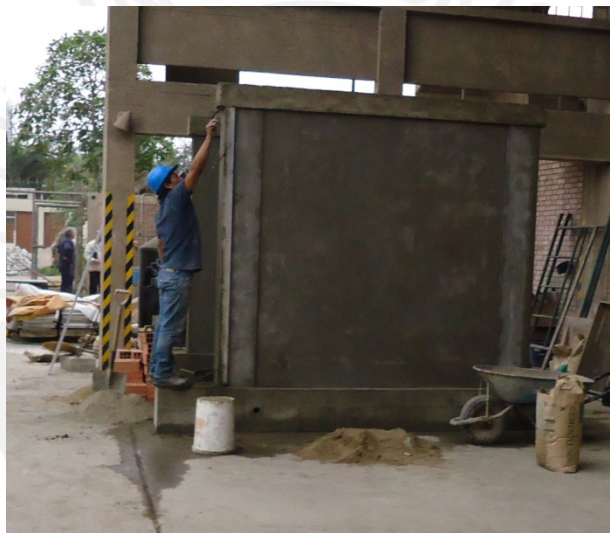
Fig. N° 38: Tarrajeo de columnas.
