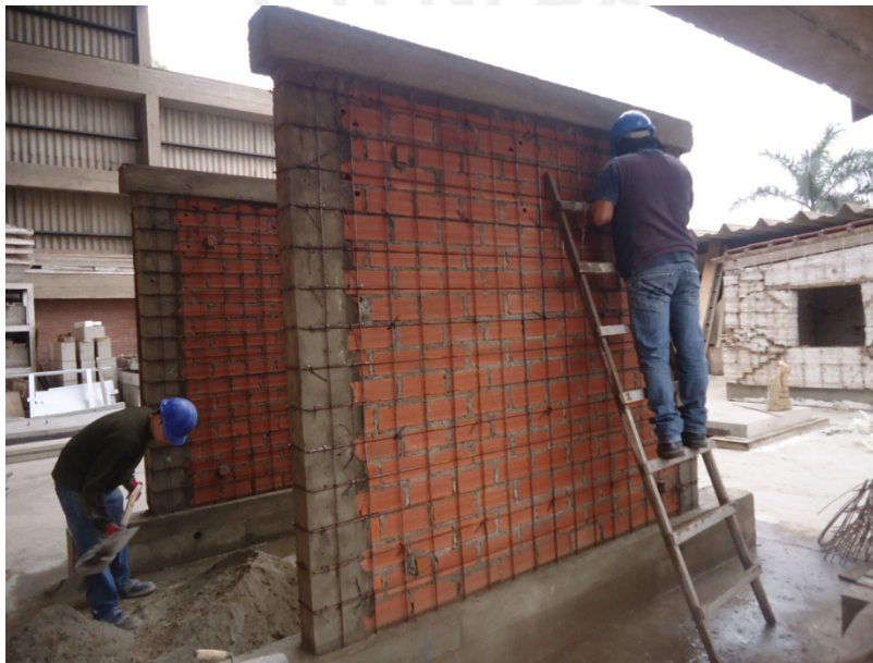
Fig. N° 35: Colocación de la malla en los muros.
