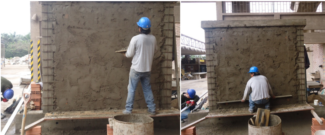
Fig. N° 37: Tarrajeo de los muros con mortero cemento-arena fina (1:4).
