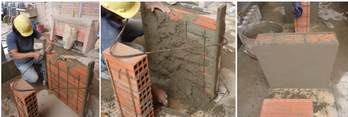
Fig. N° 21: Colocación del reforzamiento y tarrajeo de los muretes de albañilería.
