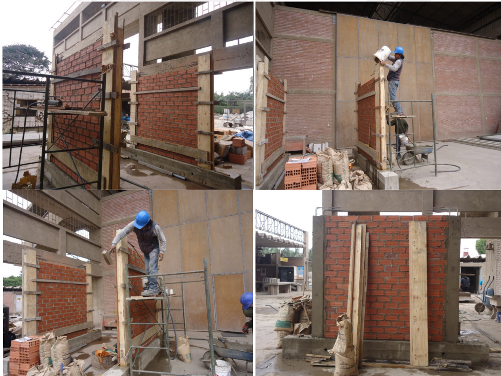
Fig. N° 33: Encofrado, vaciado y desencofrado de las columnas.
