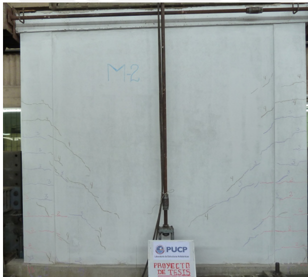
Fig. N° 54: Fisuras horizontales en las columnas y fisuras diagonales en la albañilería – Fase 04 (MR-02).
