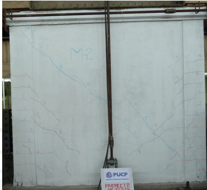
Fig. N° 55: Fisuras horizontales en las columnas y fisuras diagonales en la albañilería – Fase 05 (MR-02).
