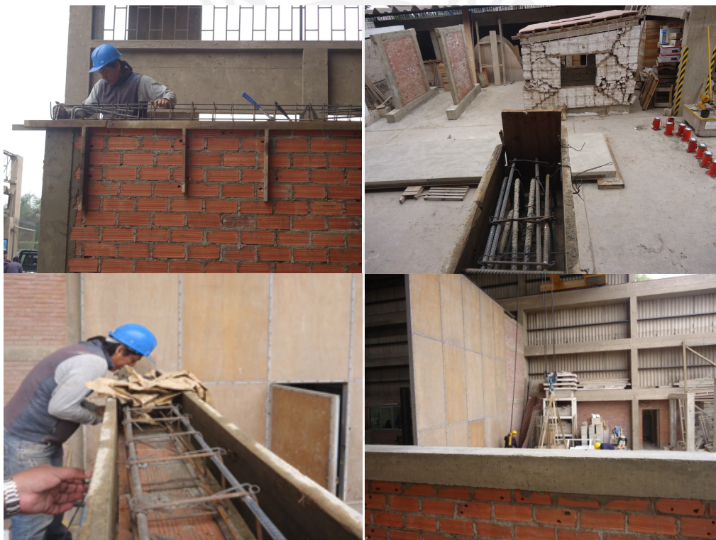
Fig. N° 34: Colocación de acero, encofrado, vaciado y desencofrado de las vigas.
