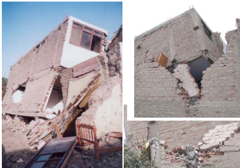
Fig. N° 3: Ladrillo pandereta en Pisco. (San Bartolomé, 2007)
