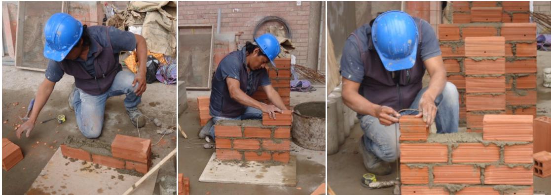
Fig. N° 20: Construcción de muretes de albañilería.
