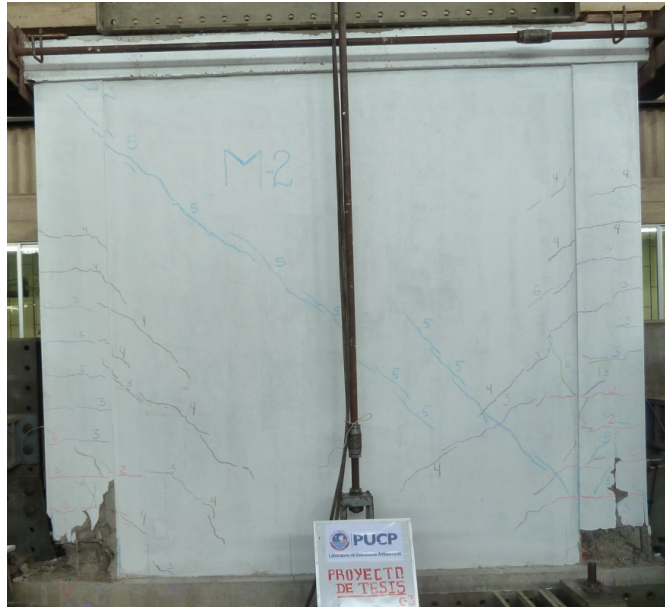
Fig. N° 57: Trituración de columnas en los talones – Fase 06 (MR-02).
