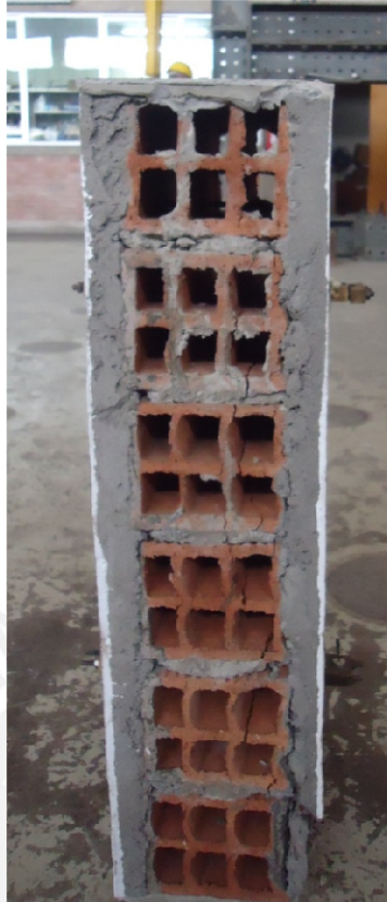
Fig. N° 14: Fisura vertical a lo largo del espécimen en la Pila N° 02.
