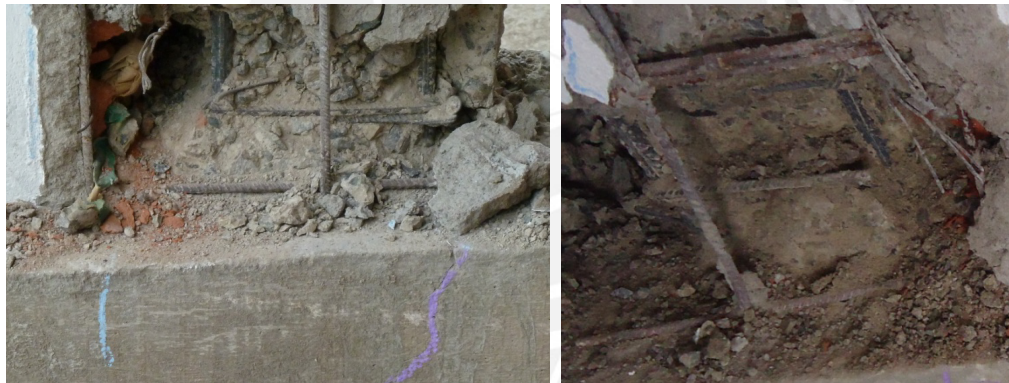
Fig. N° 49: Trituración de columnas en los talones – Fase 06 (MR-01).
