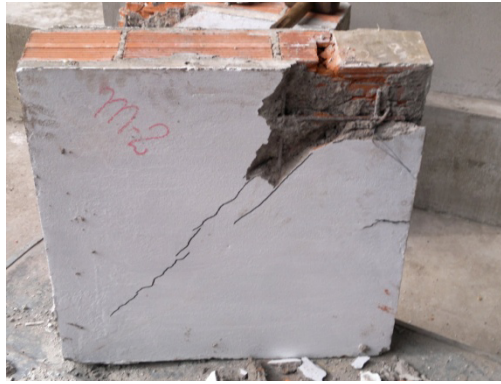
Fig. Nº 75: Falla local concentrada en el murete.
