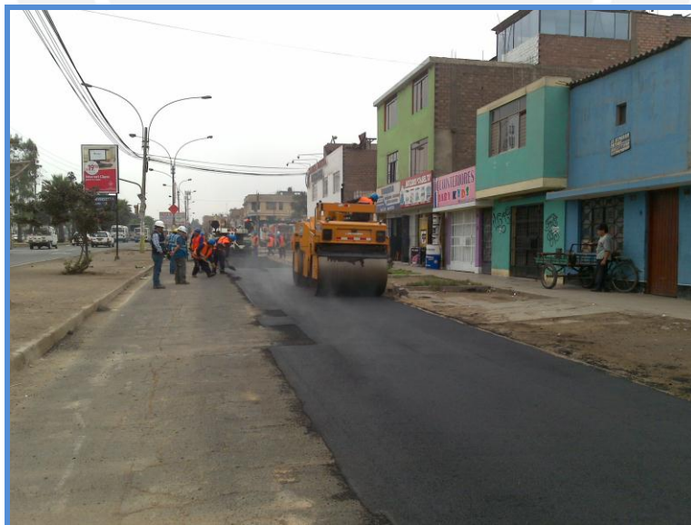
Figura 32: Reposición de asfalto en caliente
