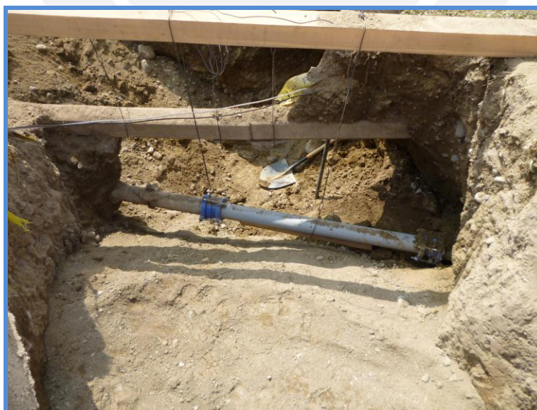
Figura 61: Reparación de tuberías existentes
