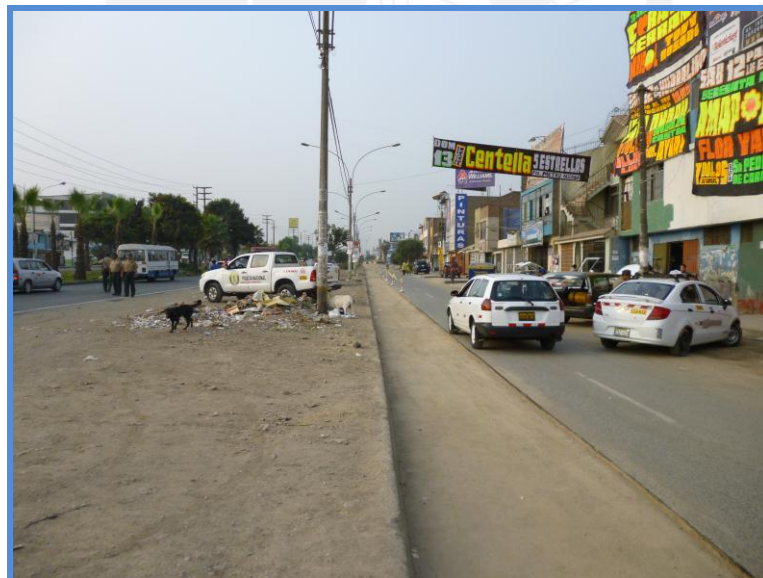
Figura 28: Base de afirmado perfilado listo para imprimación
