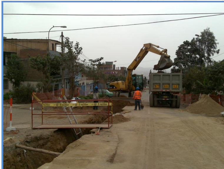
Figura 23: Disposición de material excavado DN 300
