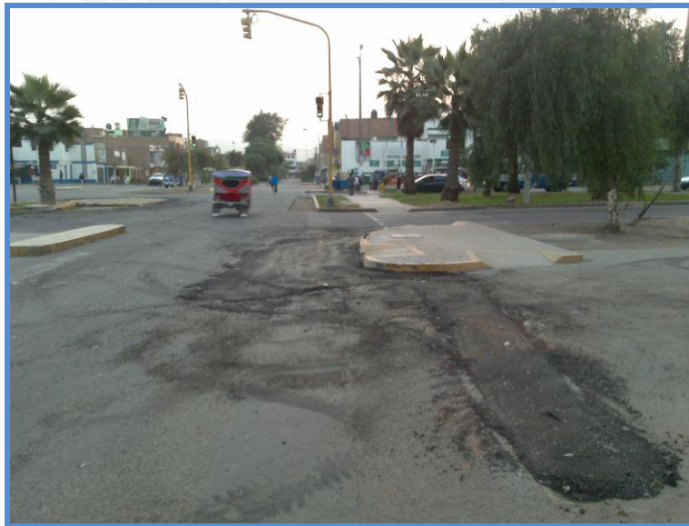
Figura 35: Reparación de vías (después)
