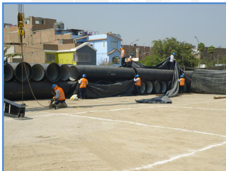
Figura 8: Cobertura de tuberías para evitar la interperie
