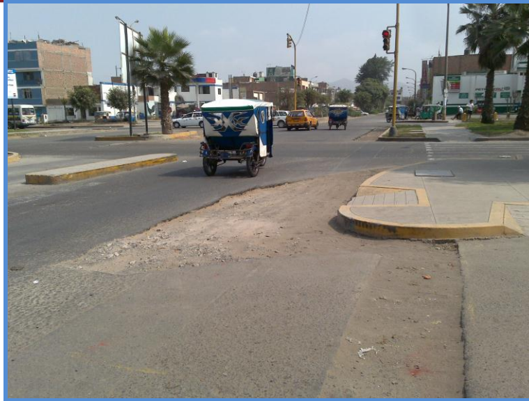
Figura 34: Reparación de vías (antes)
