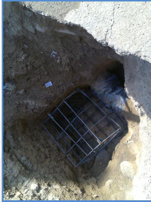
Figura 26: Anclaje de accesorio (codo)
