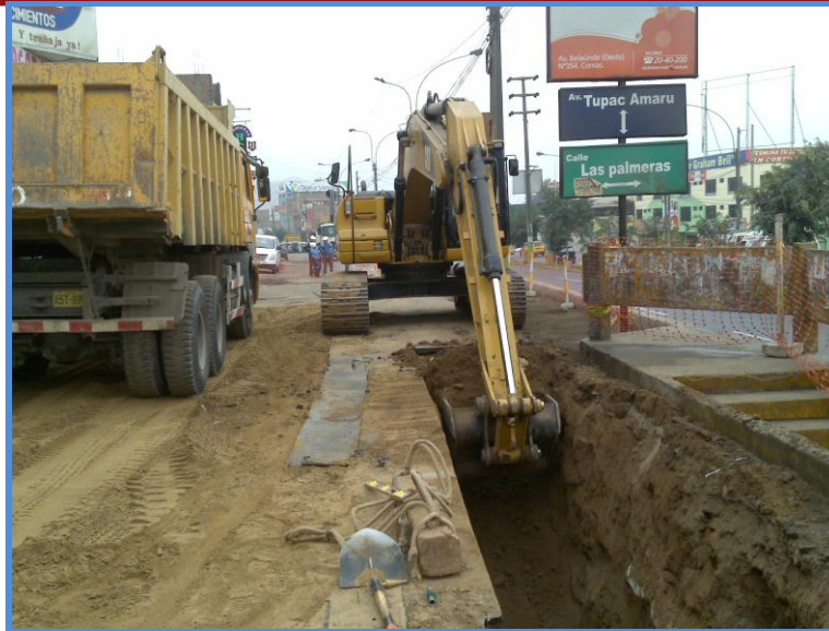
Figura 43: Excavación de zanja tamaño de cuchara
