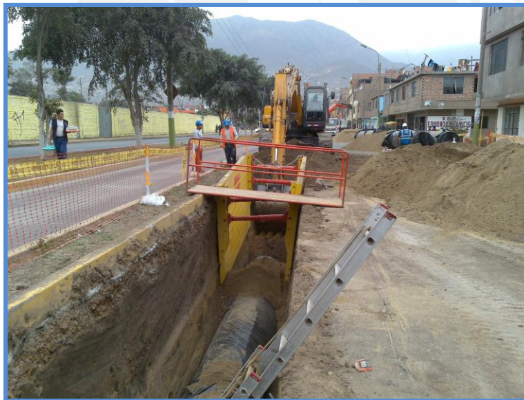
Figura 40: Excavación en terreno normal para tubería DN 1000
