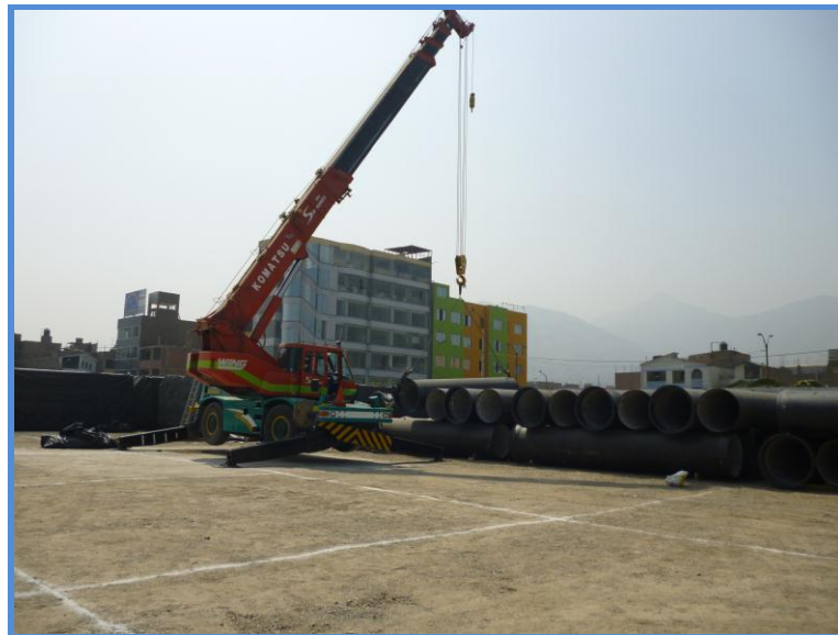
Figura 7: Apilado de tuberías de hierro fundido dúctil
