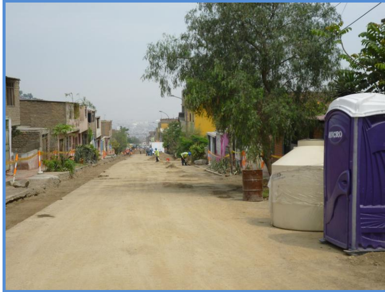
Figura 5: servicios higiénicos para personal a pie de obra
