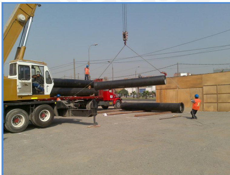
Figura 6: Manipulación para el almacenamiento de tubería
