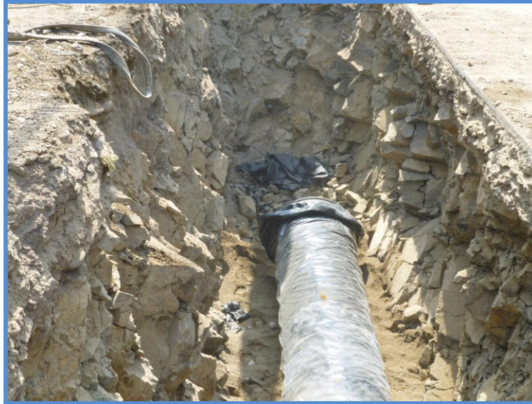
Figura 37: Excavación en terreno rocoso para tubería de DN 800
