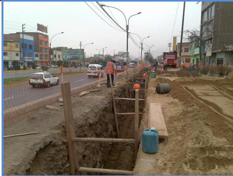
Figura 19: tablestacado de madera para tubería de DN 500
