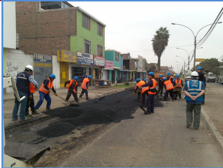
Figura 31: Colocación de capa asfáltica en caliente
