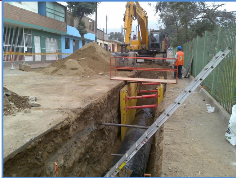
Figura 45: Excavación de tubería DN 1000
