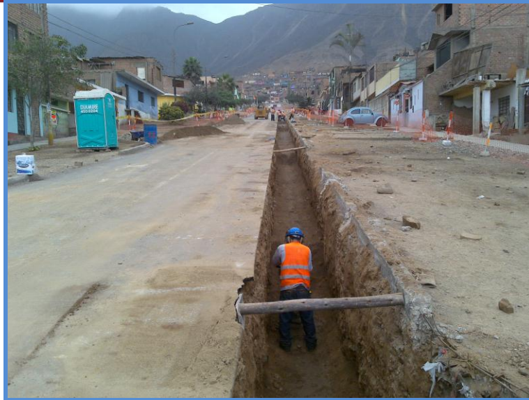
Figura 39: Excavación en terreno normal para tubería de DN 300
