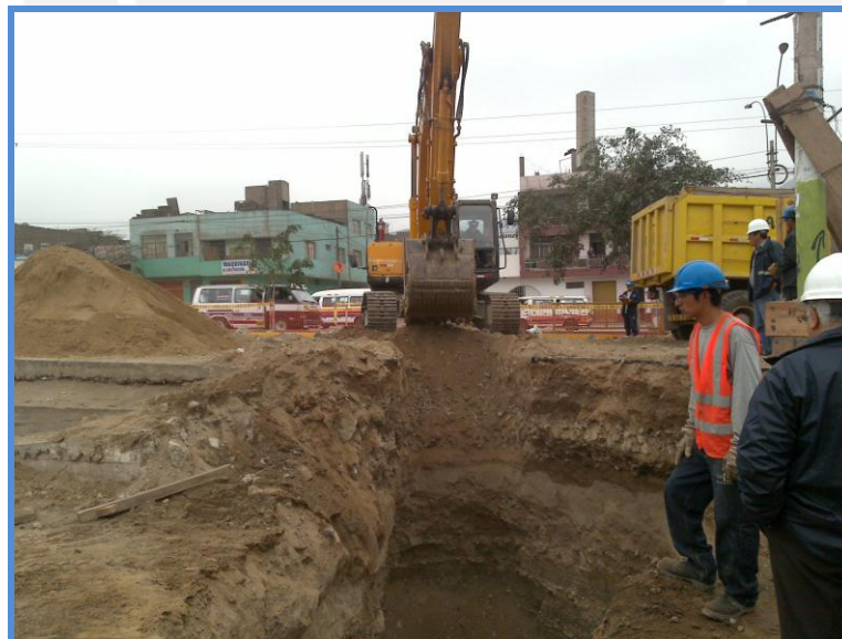
Figura 48: Excavación para anclajes DN 1000
