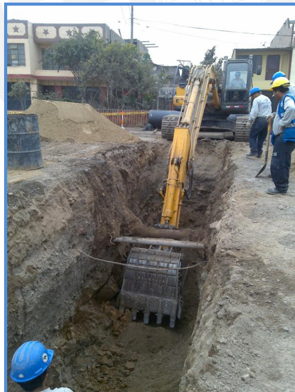
Figura 52: Excavación tubería de 1000
