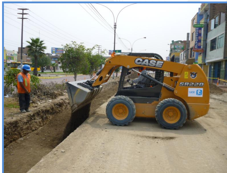
Figura 27: Relleno para compactación (DN 800)
