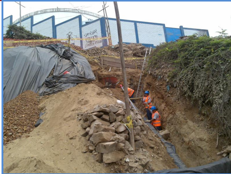
Figura 67: Instalación de tubería de HFD en subida a reservorio
