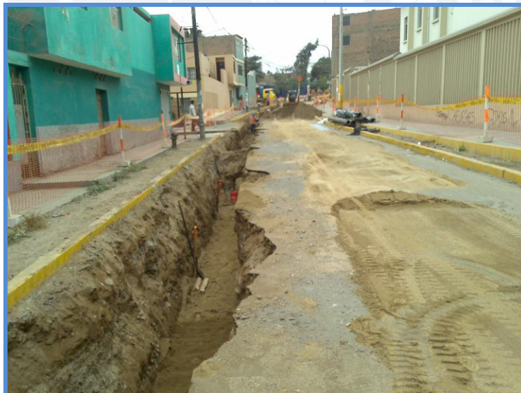
Figura 42: Excavación en terreno semirocoso para tubería DN 200
