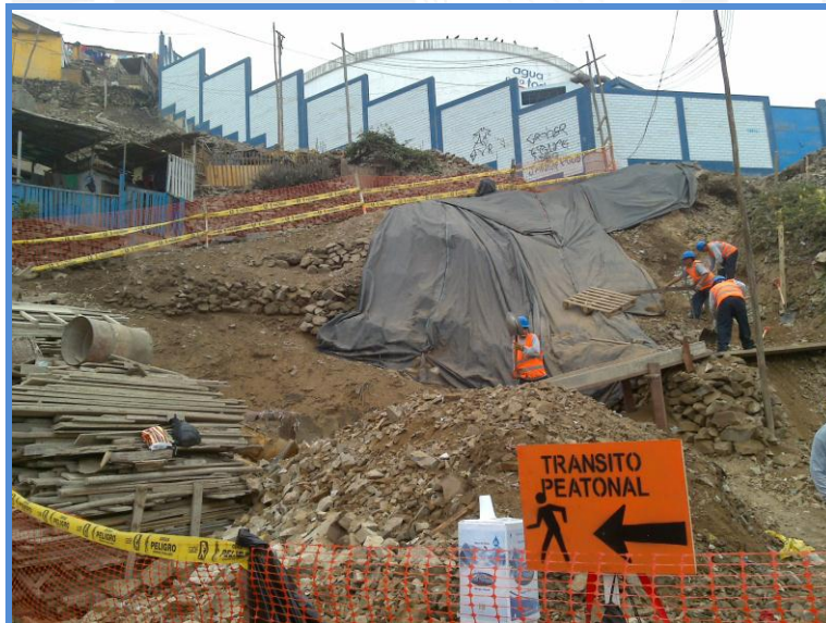
Figura 54: Excavación manual a subida de reservorio
