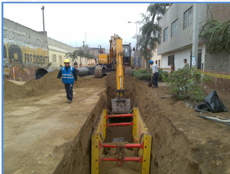
Figura 50: Excavación para instalación de tubería DN 1000
