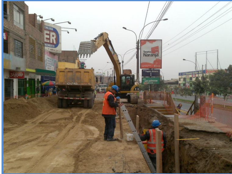
Figura 22: Disposición de material excavado DN 500
