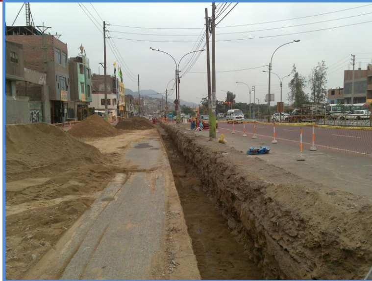
Figura 62: Excavación en terreno normal
