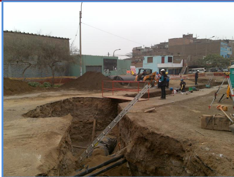
Figura 55: Excavación para colocación de Anclaje DN 1000
