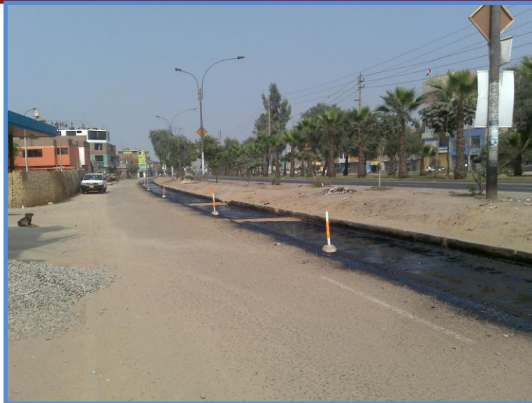
Figura 29: Imprimación de Base afirmada
