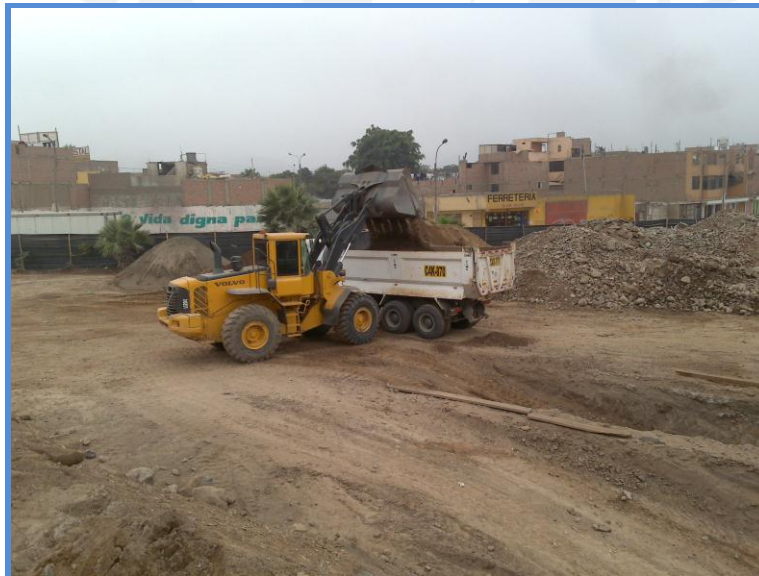
Figura 25: Material zarandeado para utilización de relleno
