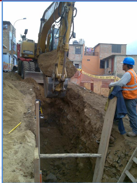
Figura 51: Excavación en terreno rocoso para tubería de DN 150
