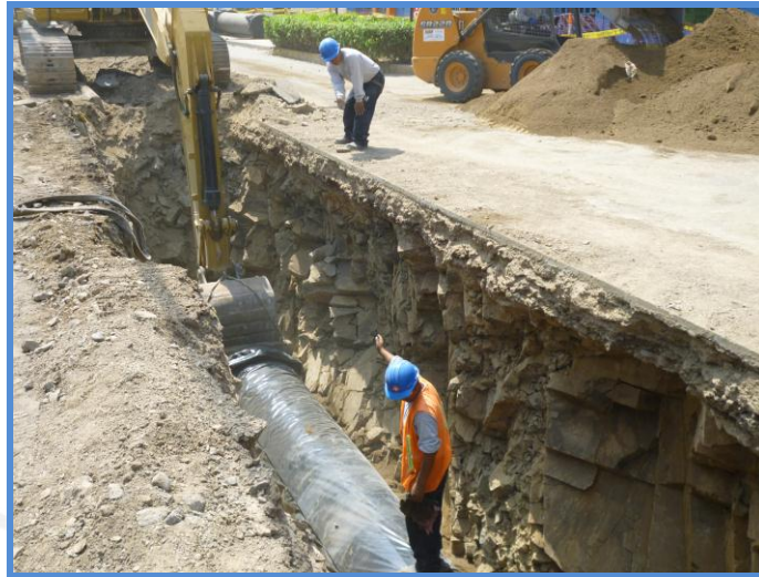
Figura 17: excavación en terreno rocoso para instalación tubería DN 800
