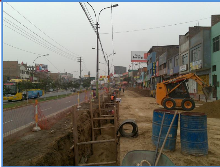
Figura 63: Tablestacado de madera tradicional
