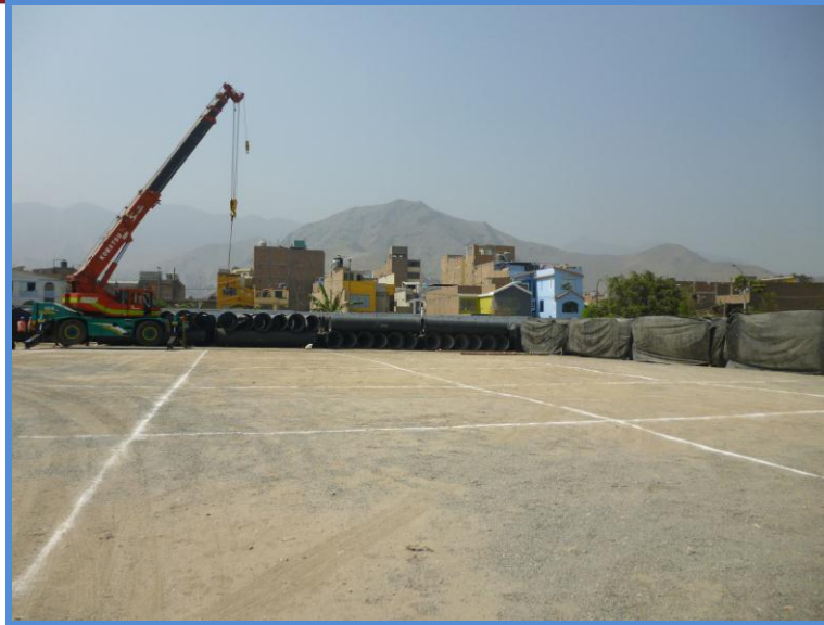
Figura 9: Vista general del almacén de apilados de tuberías
