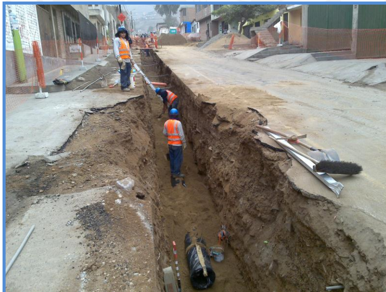
Figura 44: Excavación de tubería DN 300 con cuchara grande
