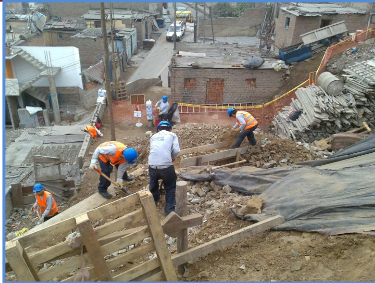
Figura 53: Excavación manual a subida de reservorio
