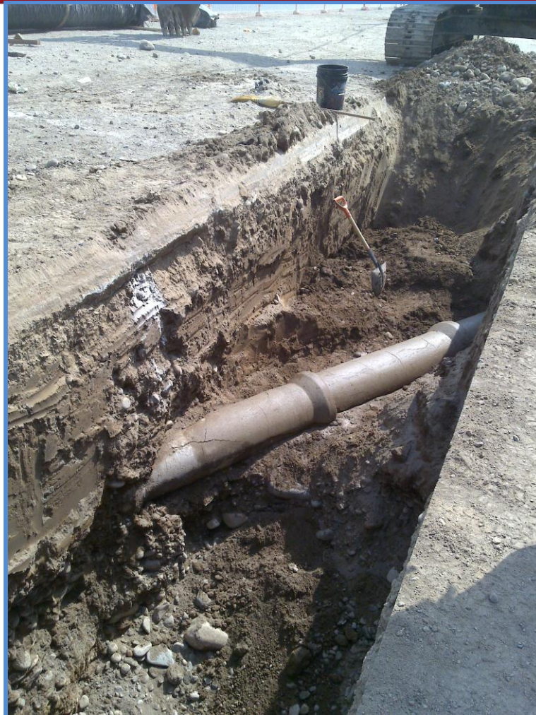
Figura 60: Tubería existente de asbesto cemento
