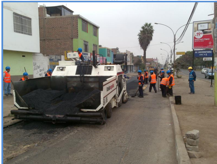
Figura 30: Colocación de capa asfáltica en caliente
