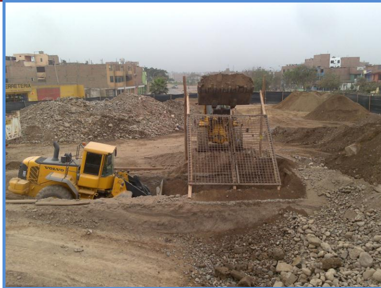
Figura 24: Material de excavación zarandeado en acopio
