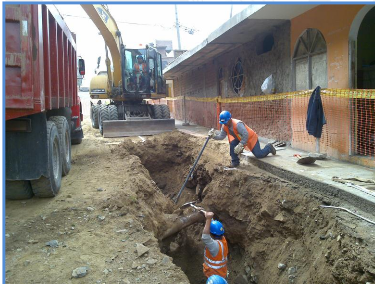
Figura 56: Tuberías existentes en el área de excavación
