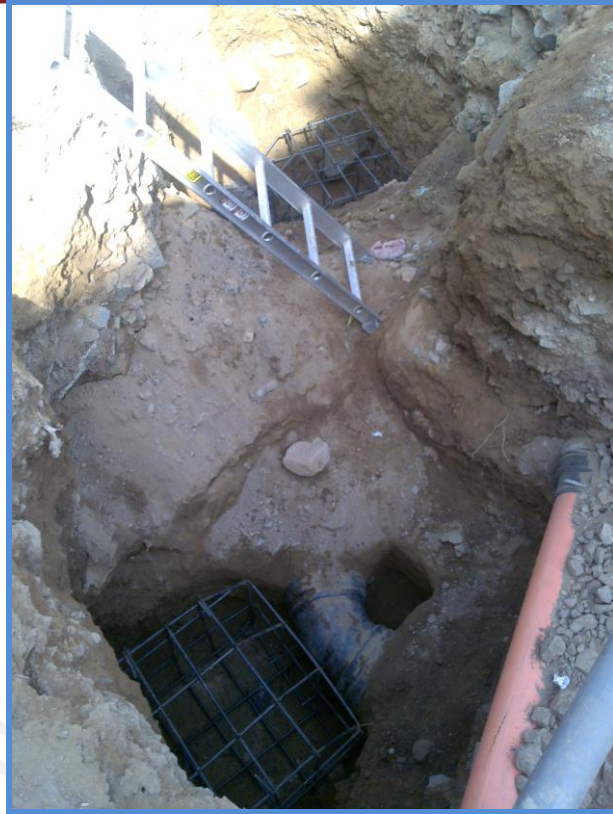
Figura 58: Excavación de anclaje con obstáculos
