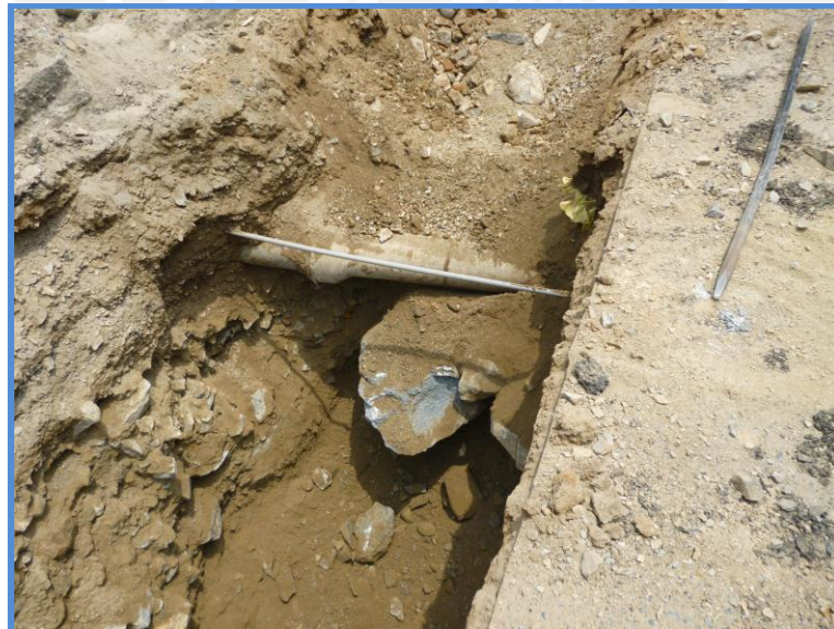
Figura 57: Aparición de tuberías existente dentro del área de excavación
