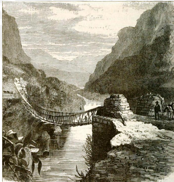
Fig. 46 Puente colgante sobre el río Pampas
