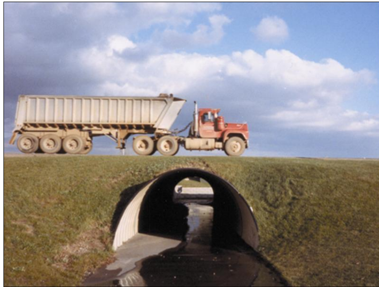
Figura 5.11.- Vista de un puente enterrado típico. (Tomado de: < www.conteches.com/products/pipe/corrugated-metal-cmp/hel-cor-pipe.aspx >).
