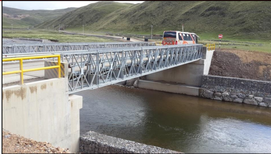
Figura 4.1.- Puente Bailey actual (Fuente: propia).
