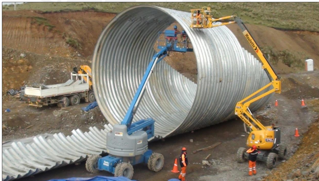
Figura 6.7.- Elevadoras articuladas usadas en la instalación de una sección circular. Ya que la sección elegida es semicircular, se permite utilizar una elevadora de tijeras, que incide en menores costos de instalación del arco. (Fuente: propia)
