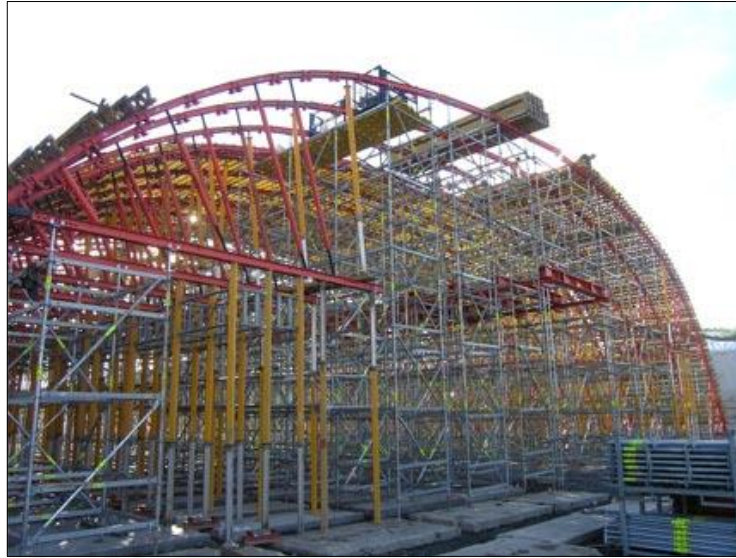
Figura 5.2.- Armadura para encofrado de arco en concreto armado. (Tomado de: http://www.peri.fr/produits.cfm/fuseaction/diashow/product_ID/320/app_id/5/imgpath/rosettscheibe_03.jpg.cfm ).
