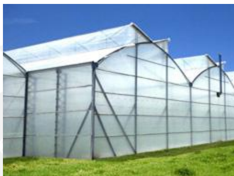
Figura 1.4 Invernadero tipo capilla
