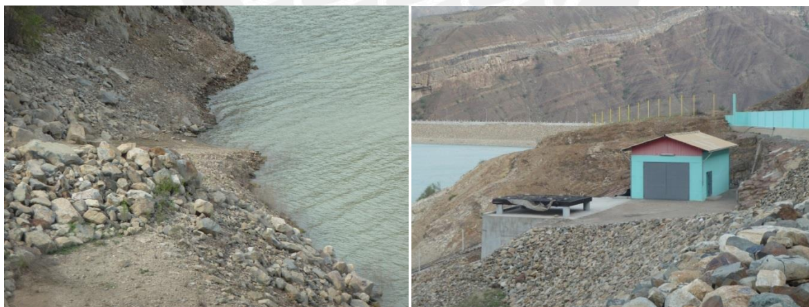
Figura 12. Estación E5 Garita 7. Vista del punto de muestreo (izquierda). Caseta del cuarto de máquinas en la garita 7 (derecha). Febrero 2012. Fotografías del Proyecto DGI 2010.0110
