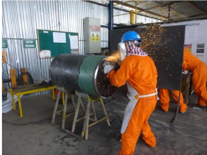
Fig. 2.6 Limpieza y preparación de bordes del tramo de tubería API 5L X70 PSL1
