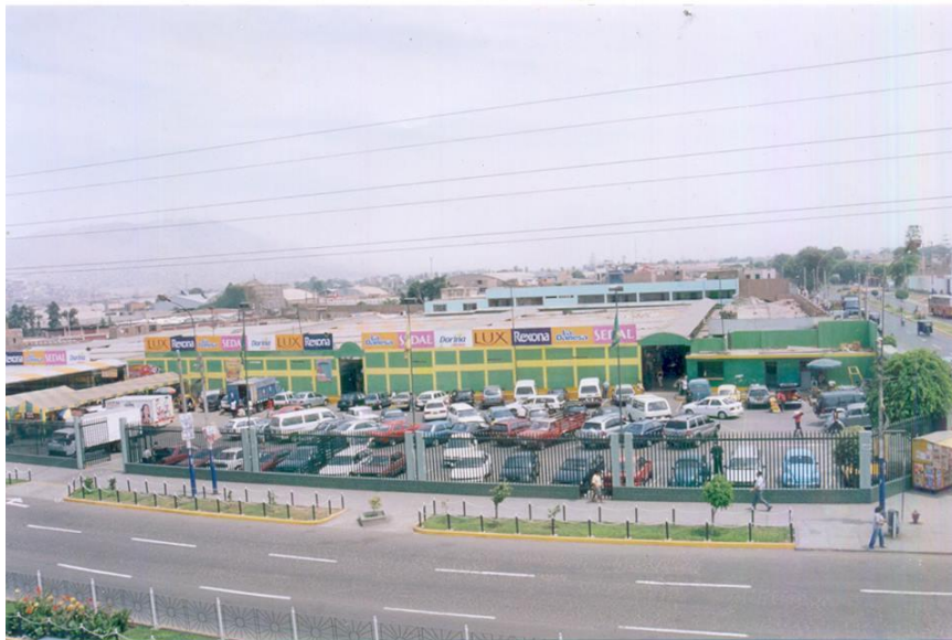
Vista panorámica del mercado Santa Rosa. Fuente:GOOGLE MAPS
