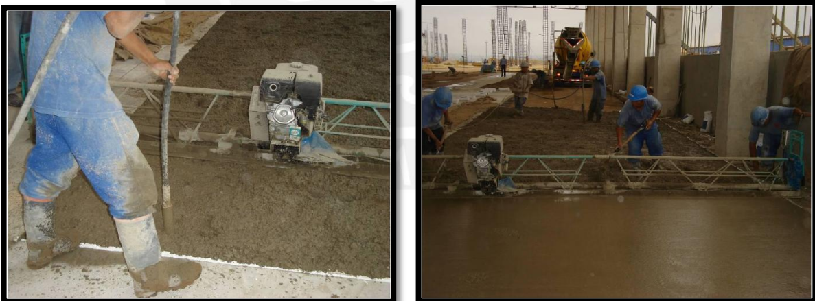
Imagen 5 Labores de vaciado, vibrado y nivelación en varios tramos del pavimento.
