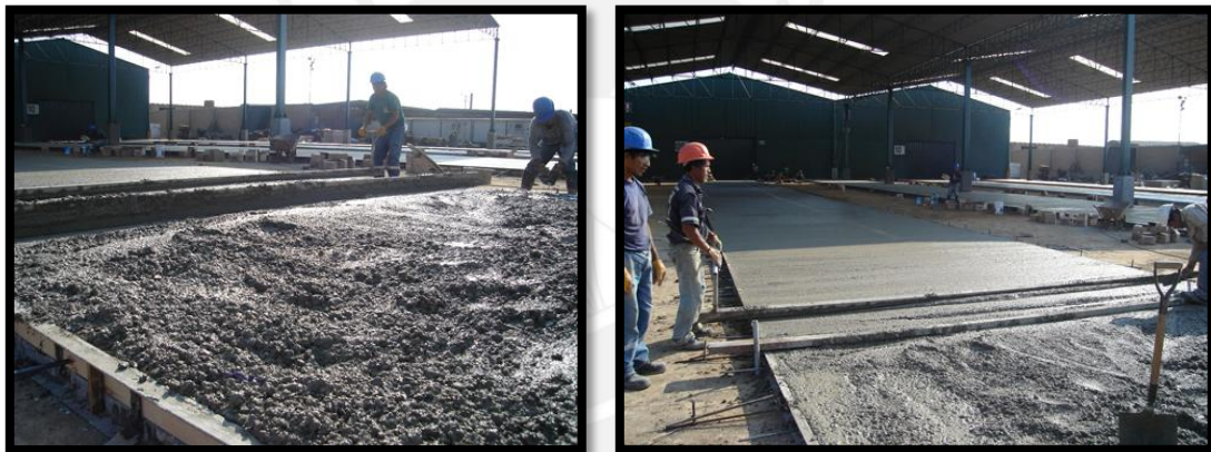
Imagen 1 Losa de Almacén: Ransa Lima Perú
