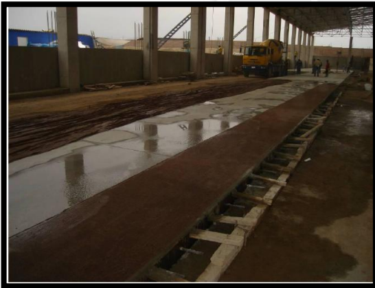
Imagen 7 Fraguado del concreto utilizando geotextiles (opcional) y detalle de la losa ya fraguada
