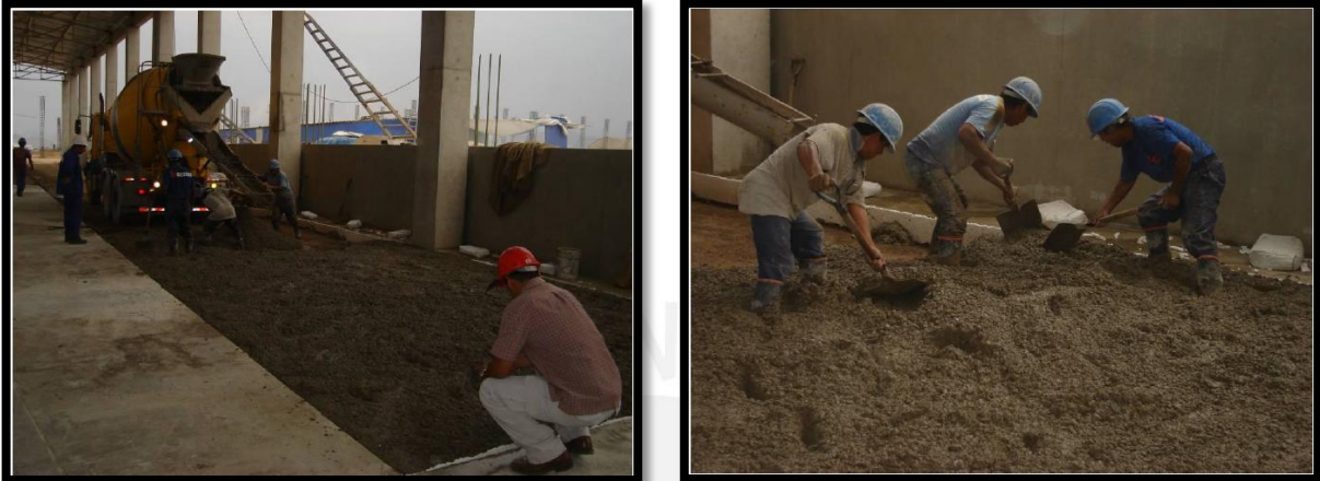
Imagen 4 Vaciado de la mezcla del mixer directamente hasta el lugar donde se requiera sobre base preparada, nótese que no hay interferencia alguna con el personal que se encuentra esparciendo el concreto
