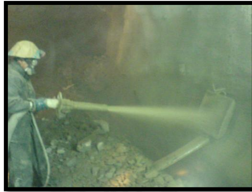
Imagen 2 Aplicación de Concreto Proyectado - Morococha Perú
