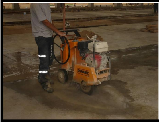
Imagen 6 Detalle de las juntas, una sierra y acabado final impecable.
