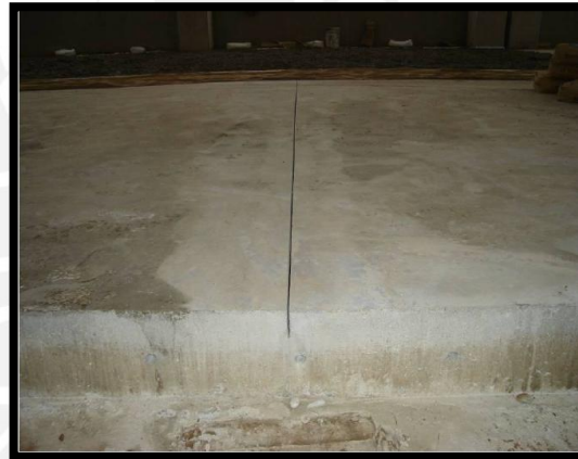
Imagen 7 Fraguado del concreto utilizando geotextiles (opcional) y detalle de la losa ya fraguada
