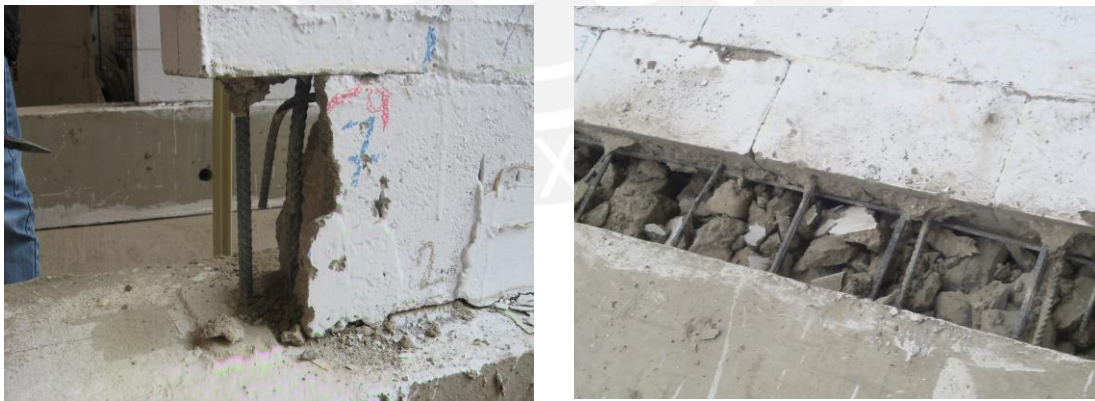
Fig.6.27. Estado del refuerzo vertical de M1 luego de los ensayos
