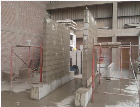
Fig.5.8. Curado de los dos muros.
