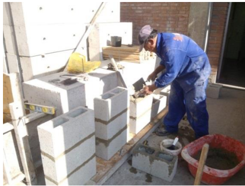
Fig.4.2 Pilas de Albañilería.
