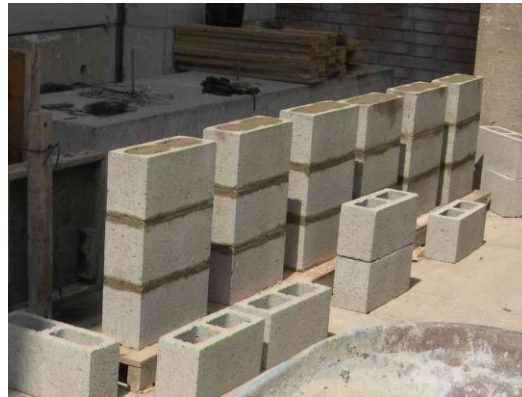
Fig. 4.3 Seis pilas rellenas con grout
