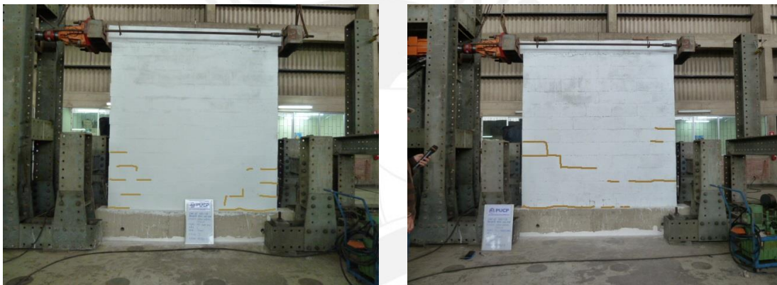
Fig.6.7. Fisuras en la fase 2, M1 (izquierda) y M2 (derecha)
