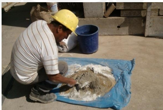
Fig.3.8. Preparación del mortero
