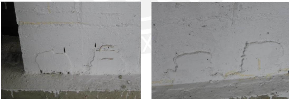
Fig.6.6. Primeras fisuras en M2, cuando se empuja (izquierda) y jala (derecha)
