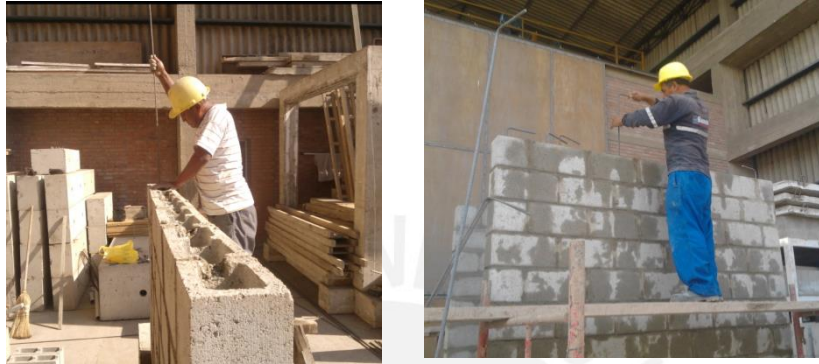
Fig.5.6. Inserción de las barras verticales.
