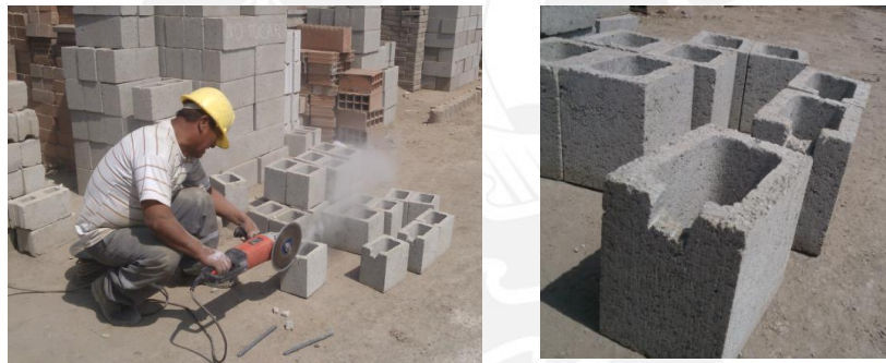
Fig.5.4. Ranuración de bloques con amoladora.
