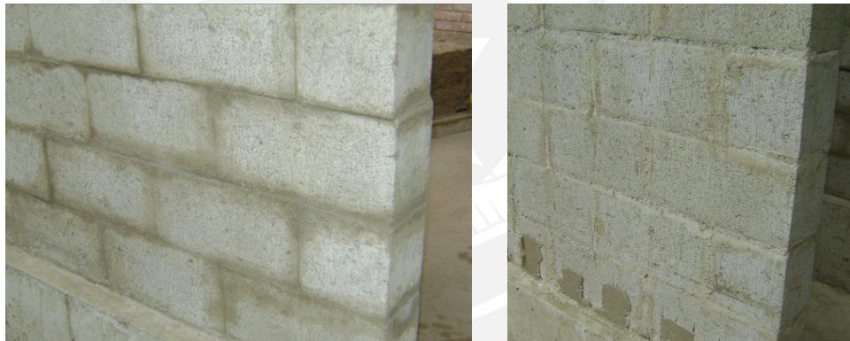
Fig.4.1. Albañilería de junta seca (izquierda) y de junta tradicional (derecha)
