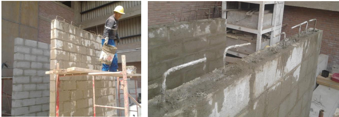
Fig.5.7. Vaciado del grout y hendidura de 3cm en la última hilada.
