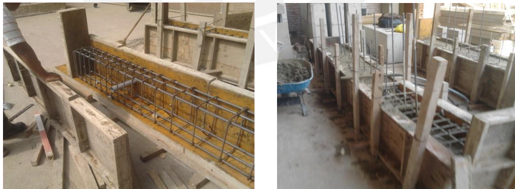
Fig.5.2. Viga de cimentación, encofrado, refuerzo, tubos y espigas.
