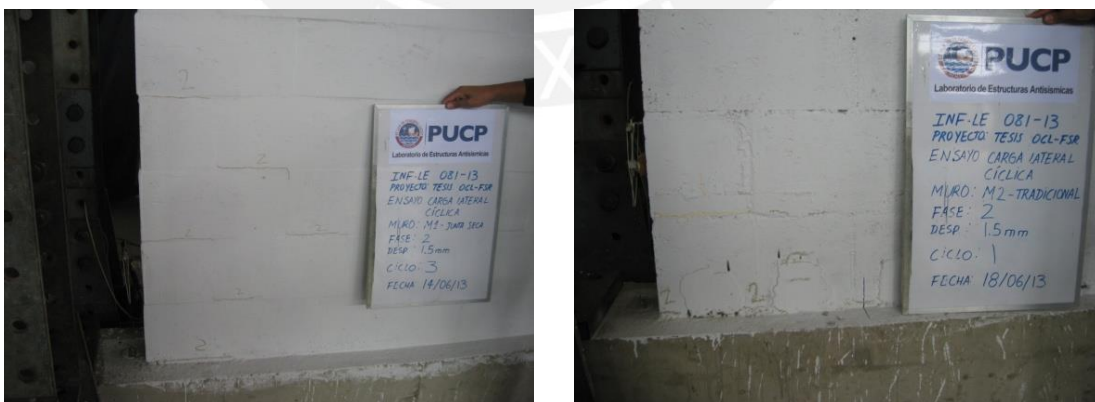
Fig.6.8. Fase 2. Fisuras en los muros M1 (izquierda) y Tradicional M2 (derecha)
