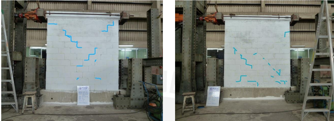
Fig.6.15. Fisuras en la fase 6, M1 (izquierda) y M2 (derecha)
