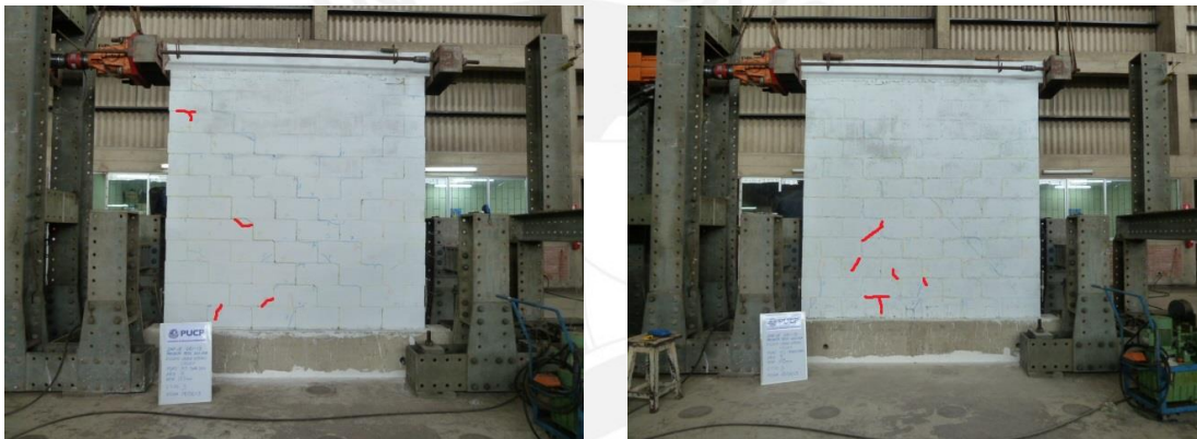
Fig.6.21. Fisuras en la fase 9, M1 (izquierda) y M2 (derecha)
