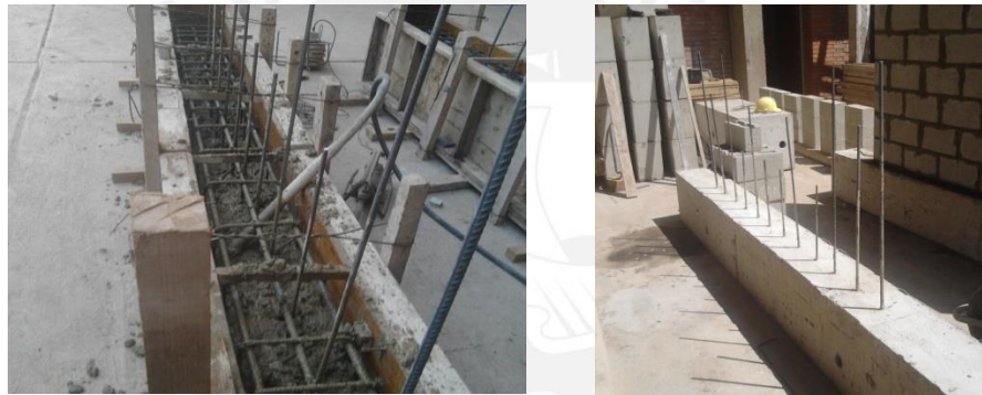
Fig.5.3. Compactación del concreto y espigas en la viga de cimentación.
