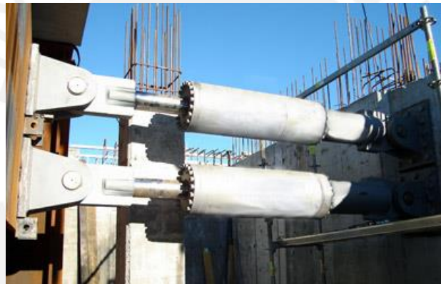
Figura 2. Disipadores de fluido viscoso. (Maurer Sohne)
