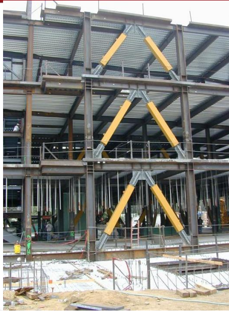
Figura 1. Disipadores por fluencia de metales. Arriostre de pandeo restringido (University of New York at Buffalo)
