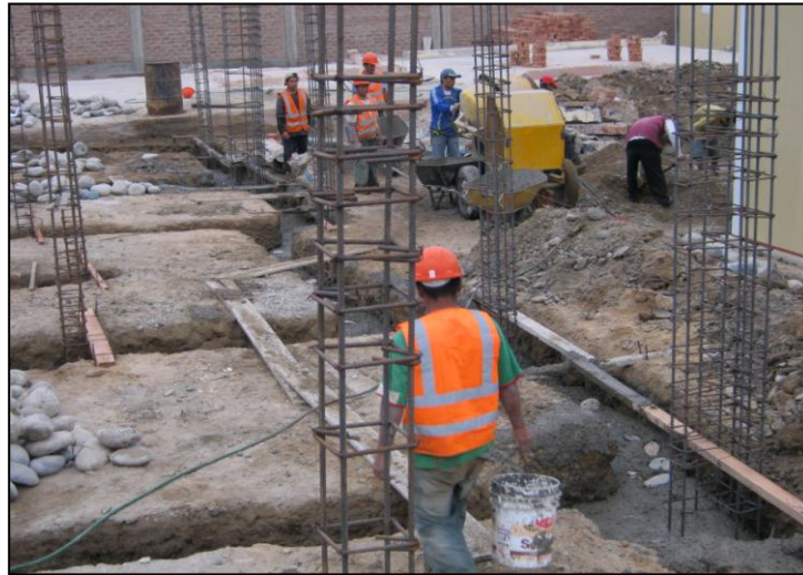
Vaciado de cimentación corrida. (Fuente propia)
