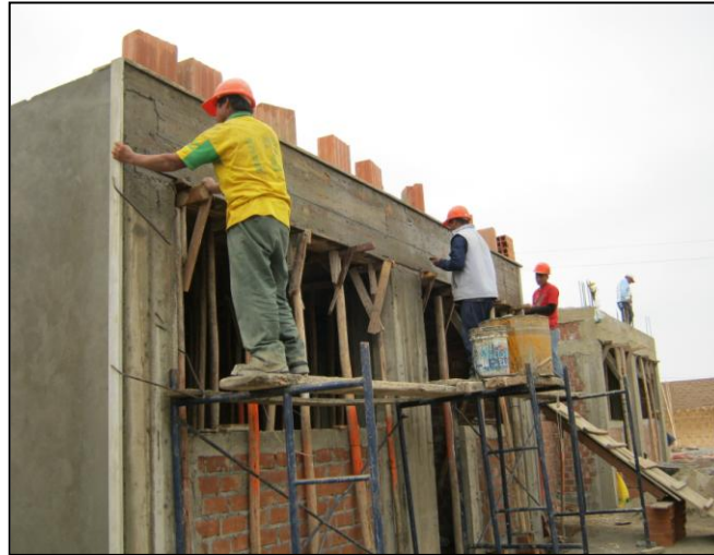
Tarrajeo de vigas y columnas. (Fuente propia)
