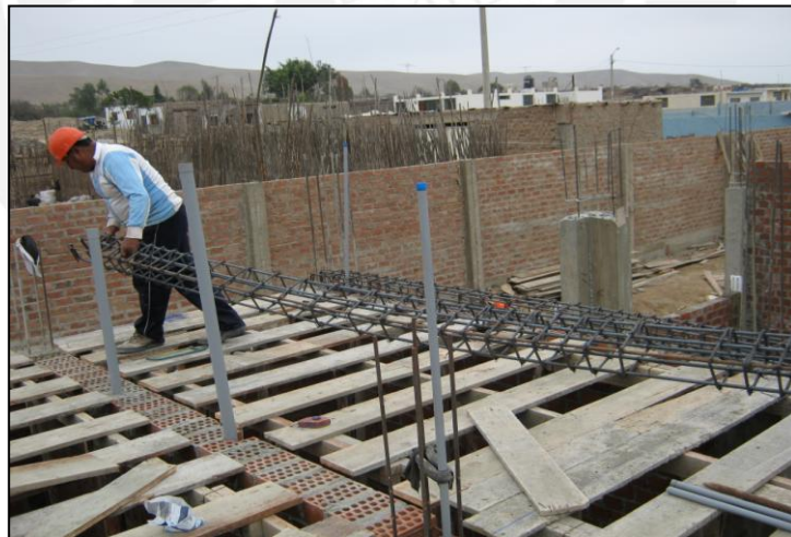
Colocación de fierro en vigas. (Fuente propia)
