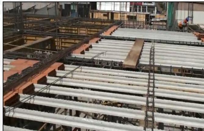
**Imagen 2.26** Colocación de viguetas prefabricadas Firth. (Fuente propia)
