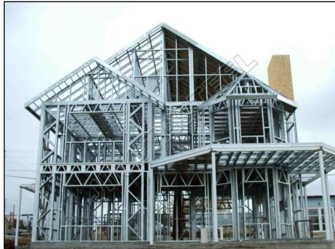
**Imagen 2.7** Estructura ligera de acero galvanizado “Steel Framing”
