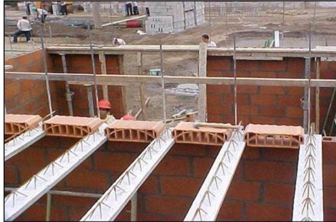
**Imagen 2.24** Colocación de viguetas prefabricadas ALITEC
