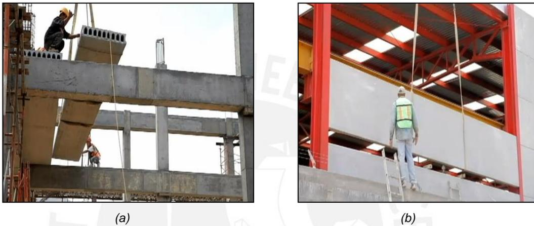
**Imagen 2.28** (a) Colocación de placas alveolares para losas. (b) Colocación de placas alveolares como muros (Fuente: <http://www.hormipresa.com/prefabricados-de-hormigon/placas-alveolares/>)
