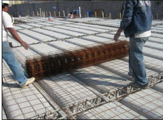
**Imagen 2.18** Colocación de mallas electrosoldadas en obra
