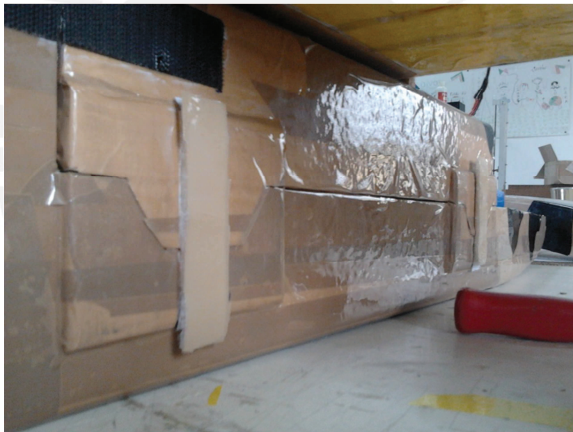
Figura 3. 15 Detalle de unión con las cintas de velcro. [Autoría propia, 2012].
