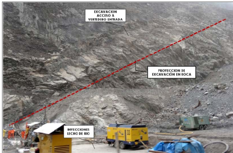
Excavación proyectada del plinto margen izquierdo
