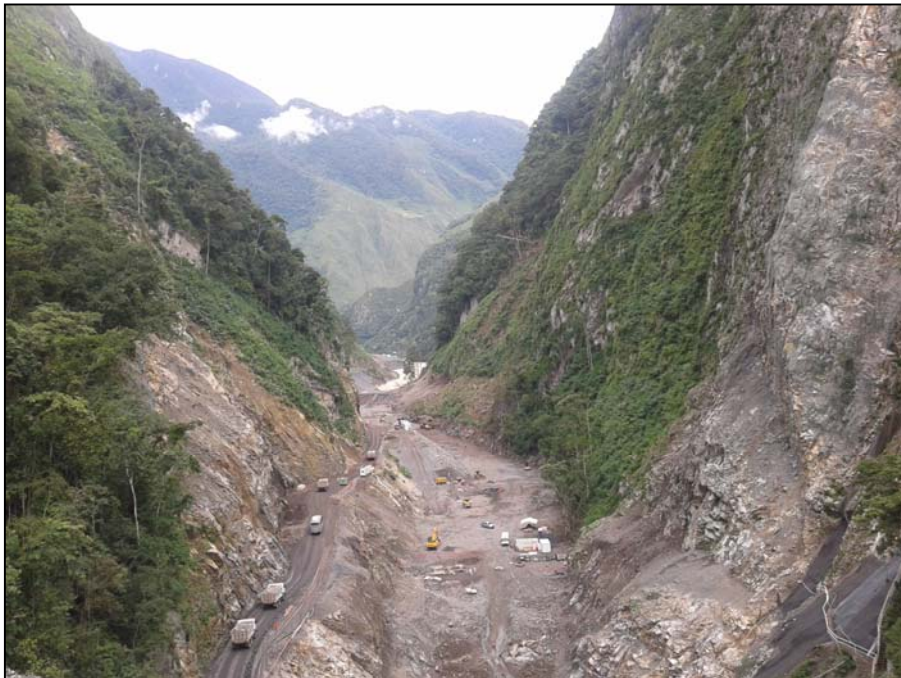
Relleno de presa 14 de enero del 2013, se observa el flujo de volquetes provenientes de canteras aguas arriba de la presa. Foto tomada desde la ataguía aguas arriba.
