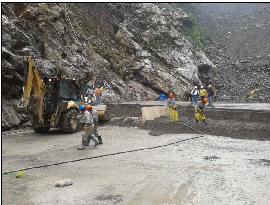
Concretado muro del plinto 20 de febrero del 2013
