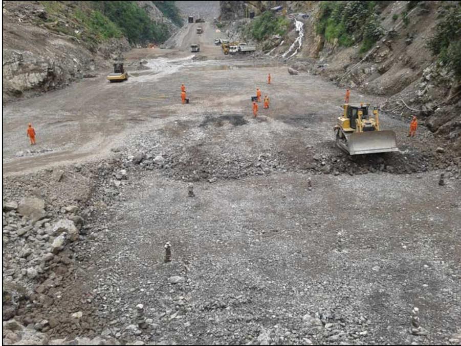
Relleno de la presa 09 de enero del 2013, se observa hacia el fondo de la imagen el relleno inicial descrito en el planeamiento de setiembre de 2012
