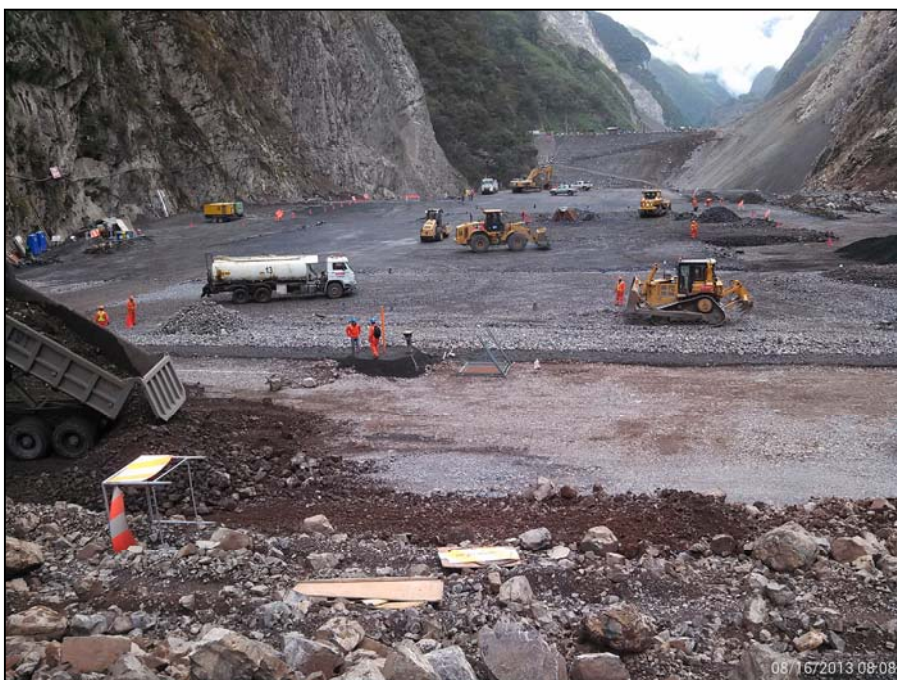
Relleno de presa, del eje hacia aguas arriba, 16 de agosto del 2013, se puede apreciar el material F en la zona central de la imagen.
