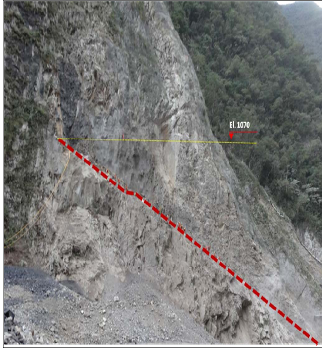
Excavación proyectada del plinto margen derecho
