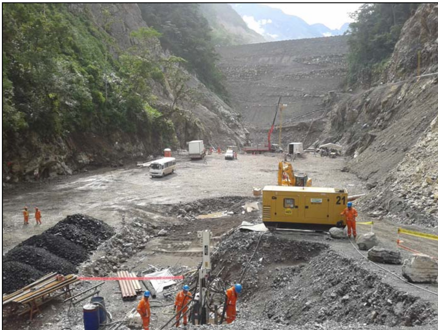
Relleno de la presa 10 de enero del 2013, se observa la instalaiación de un inclinómetro y hacia el fondo concreto inicial del solado del muro del plinto. La estrucutra de enrocado que se ve hacia el fondo es la ataguía aguas arriba.
