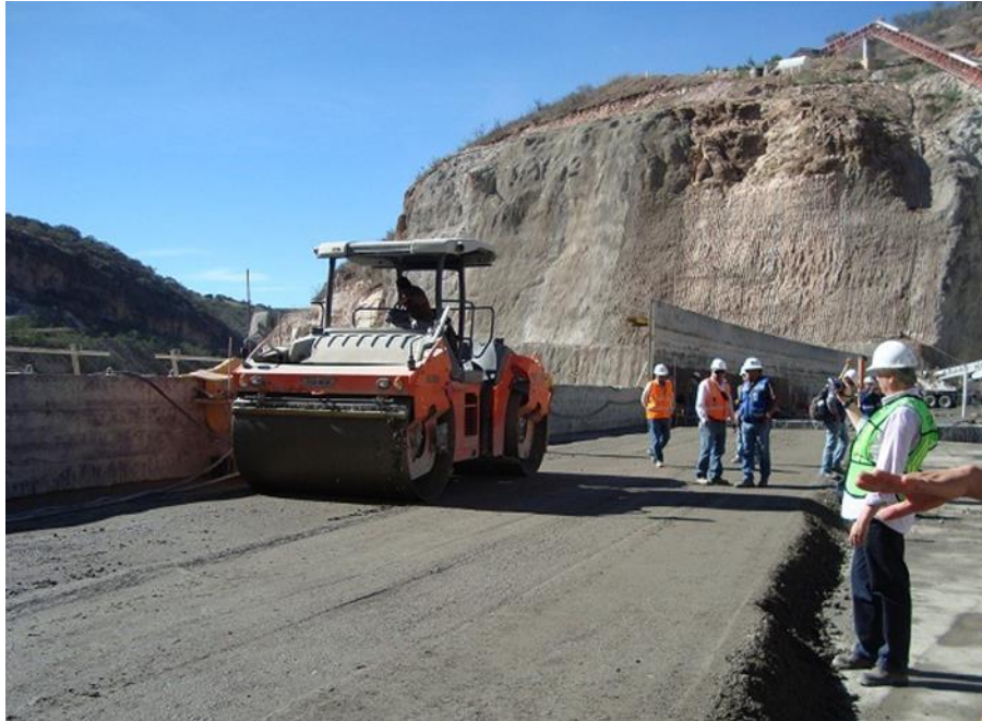
Fig 3. 14. CCR aplicada en la presa Zapotillo. Jalisco, México (Londoño 2013)
