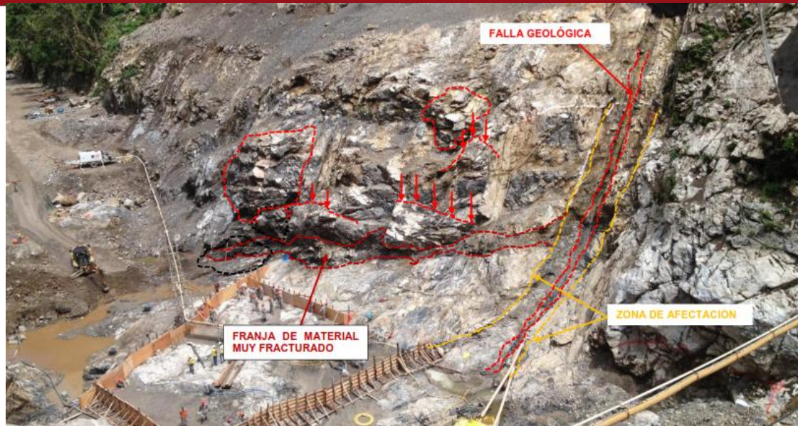
Fig 3.11. Zona del plinto – Vista de la margen derecha (Marquez 2013)
