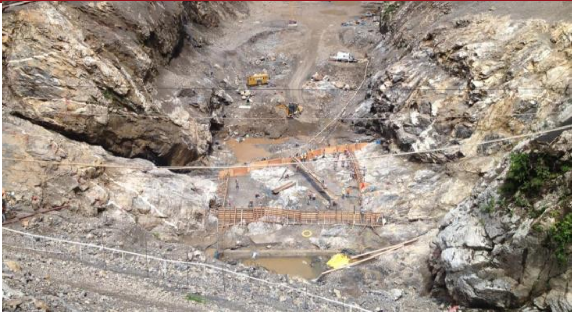
Fig 3.9. Condiciones del lecho del río en la zona proyectada del plinto (Marquez 2013)
