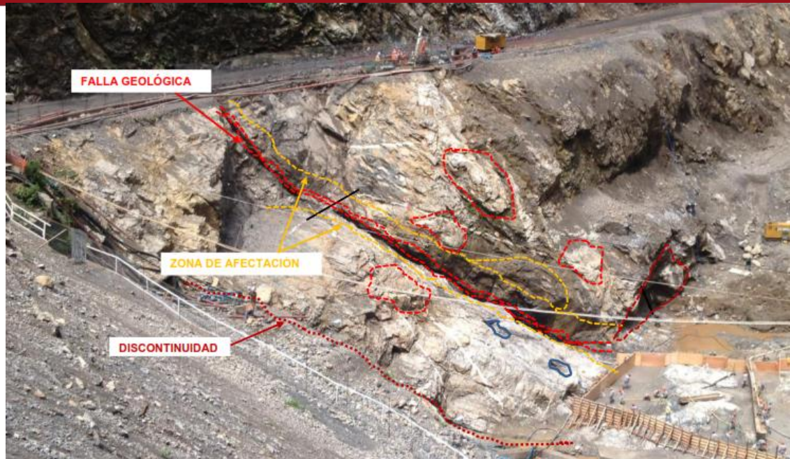
Fig 3.10. Zona del plinto – Vista de la margen izquierda (Marquez 2013)
