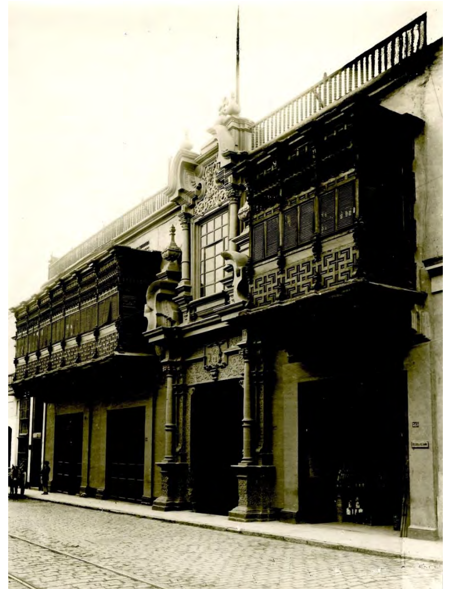
Fig. 19: Casa Torre Tagle . Lima, 1924
