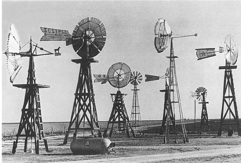
Figura 1-9. Clásicas turbinas eólica americanas usadas para bombeo de agua [15]
