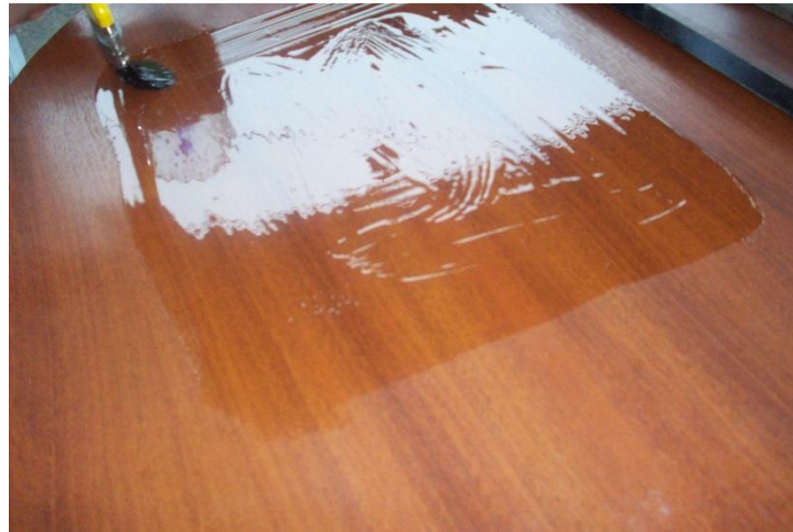
Figura A9: Esparcimiento de la resina en la superficie de trabajo
