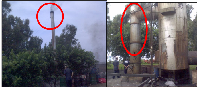
Figura Nº 2 Incinerador de residuos de la empresa DESCON S.A.C.
