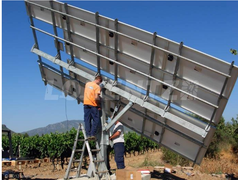
Figura 1.18 Instalación de Seguidor Solar 25
