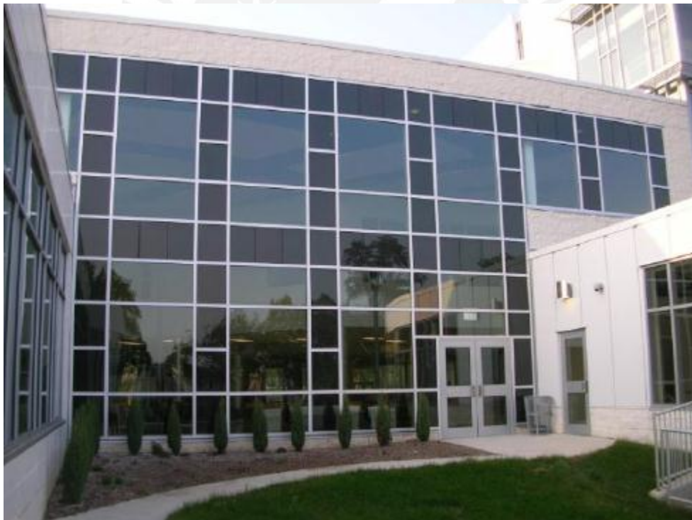
Figura 1.20 Paneles fotovoltaicos como ventanas en edificio de Philadelphia. 27
