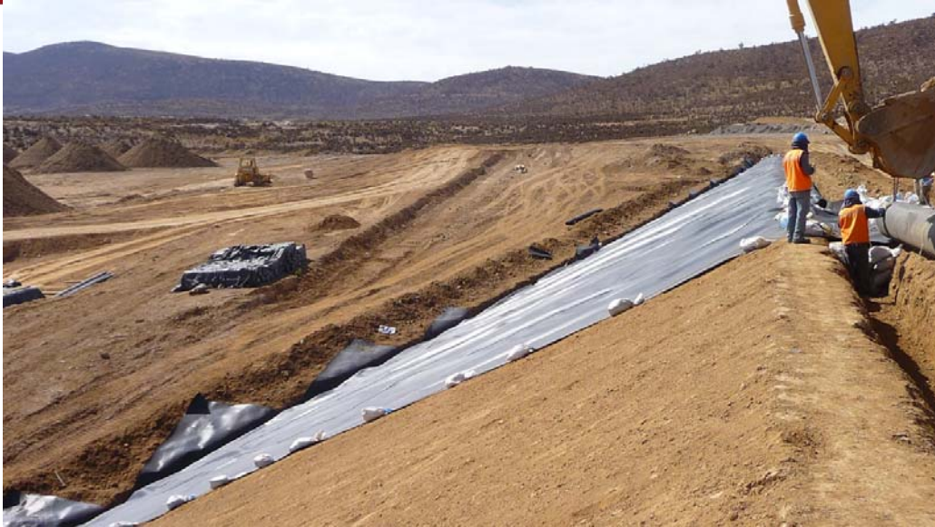
Figura 2.36 Colocación de Geomembranas Fuente: Gerencia Regional de Infraestructura (2010)
