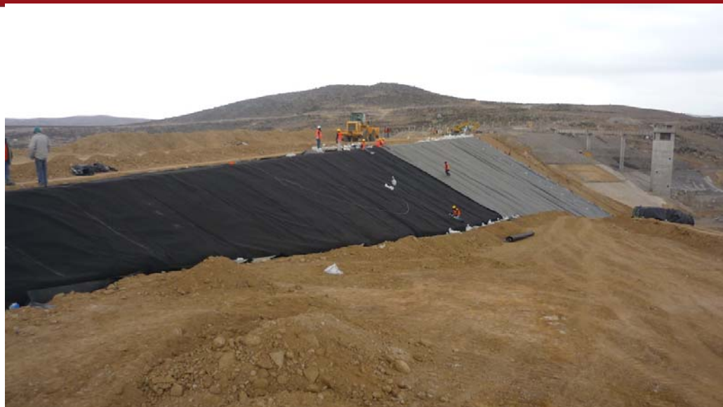
Figura 2.40 Colocación de Geomembranas Fuente: Gerencia Regional de Infraestructura (2010)
