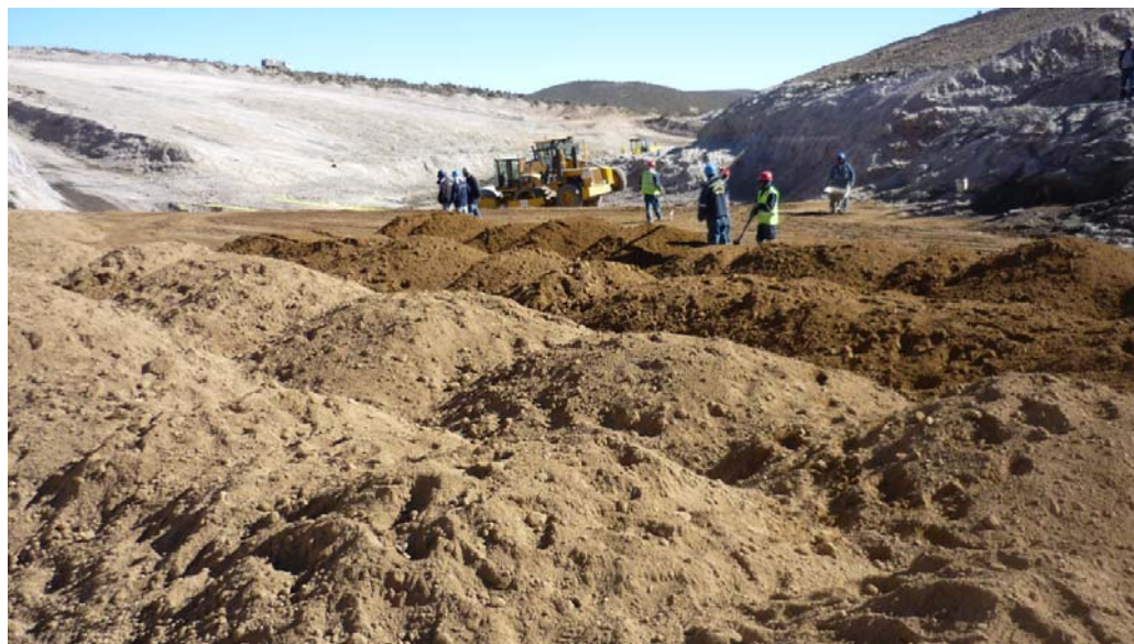
Figura 2.7 Relleno cuerpo de presa Fuente: Gerencia Regional de Infraestructura (2010)
