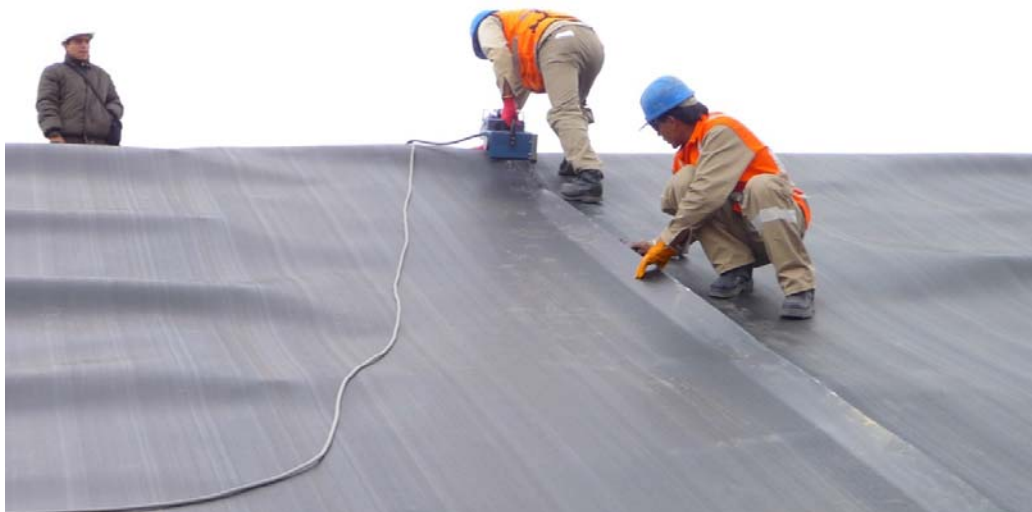
Figura 2.35 Colocación de Geomembranas Fuente: Gerencia Regional de Infraestructura (2010)
