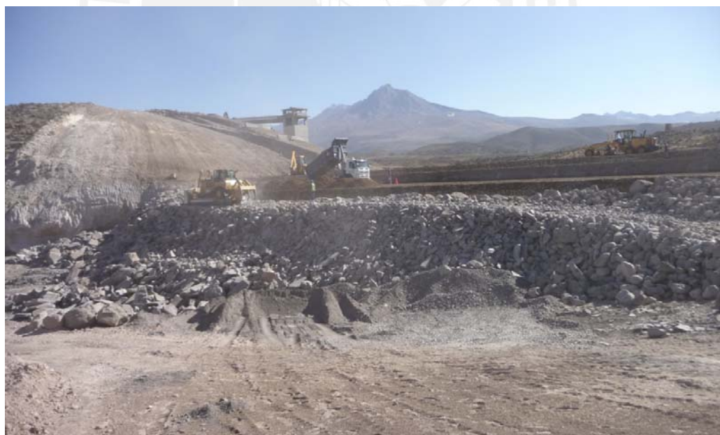
Figura 2.31 Relleno de Prisma Enrocado Fuente: Gerencia Regional de Infraestructura (2010)
