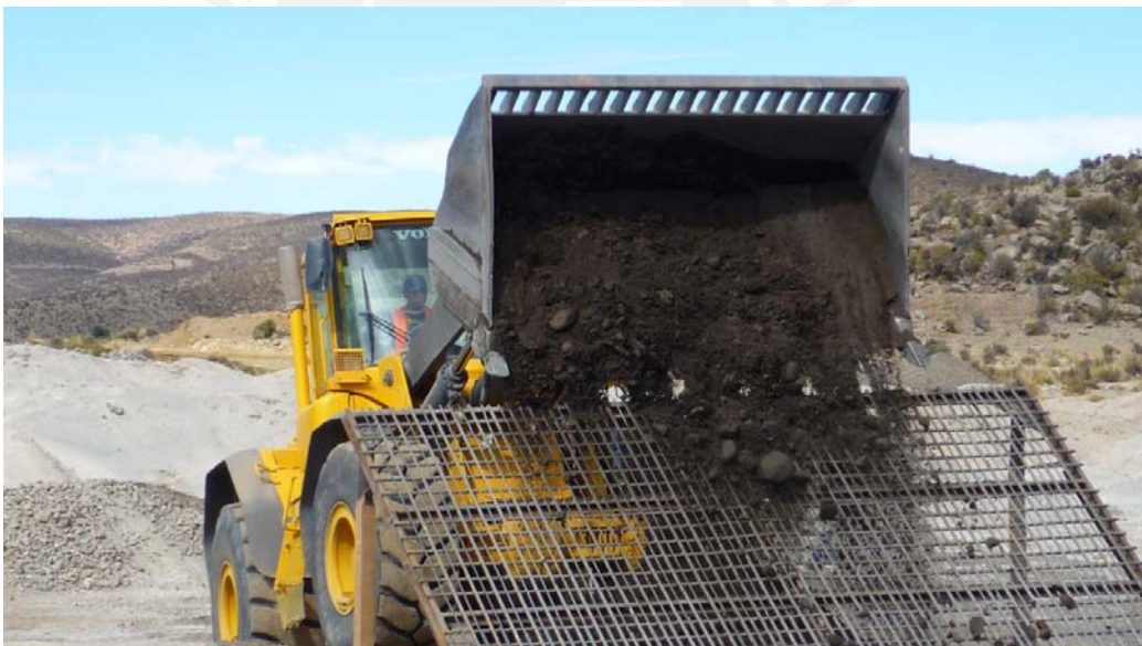
Figura 1.7 Operaciones en las canteras Fuente: Propia
