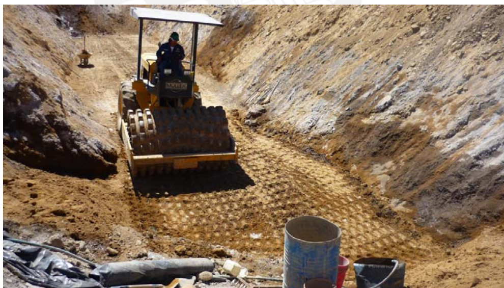
Figura 2.13 Relleno de uña de delantal Fuente: Gerencia Regional de Infraestructura (2010)
