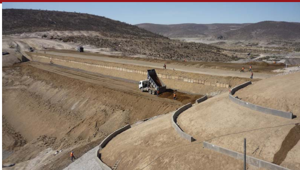
Figura 2.26 Relleno cuerpo de presa Fuente: Gerencia Regional de Infraestructura (2010)
