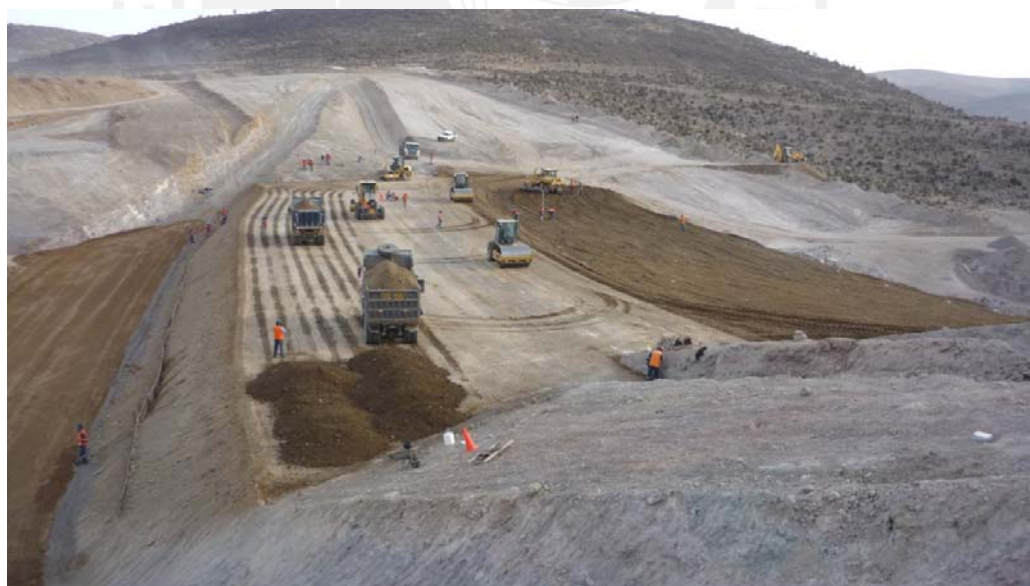
Figura 2.23 Relleno cuerpo de presa Fuente: Gerencia Regional de Infraestructura (2010)
