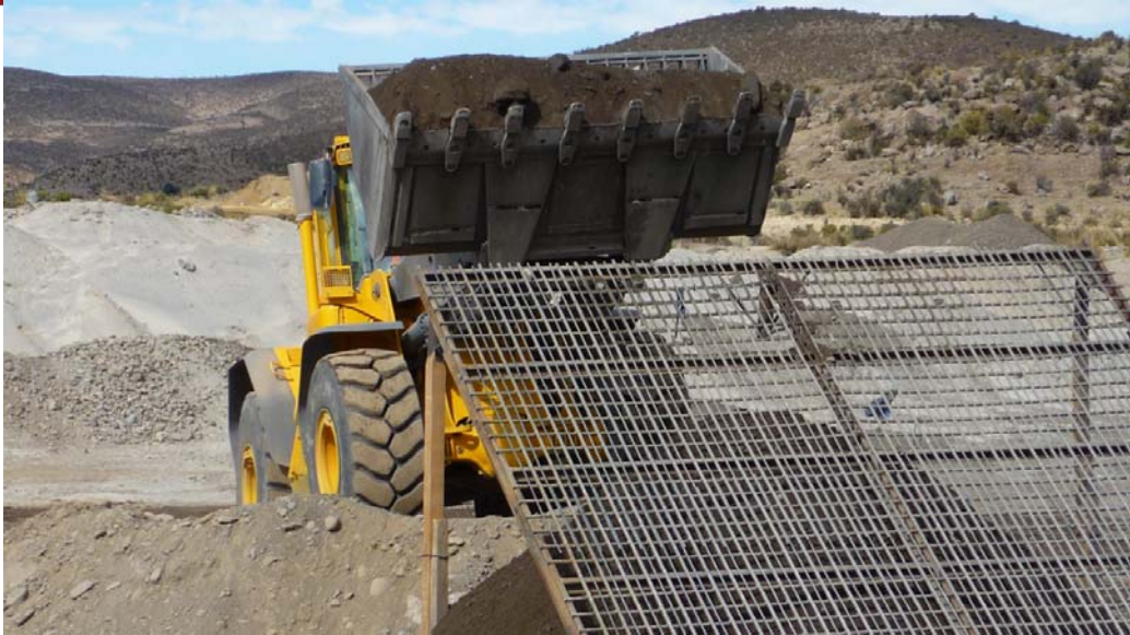
Figura 1.6 Operaciones en las canteras Fuente: Propia
