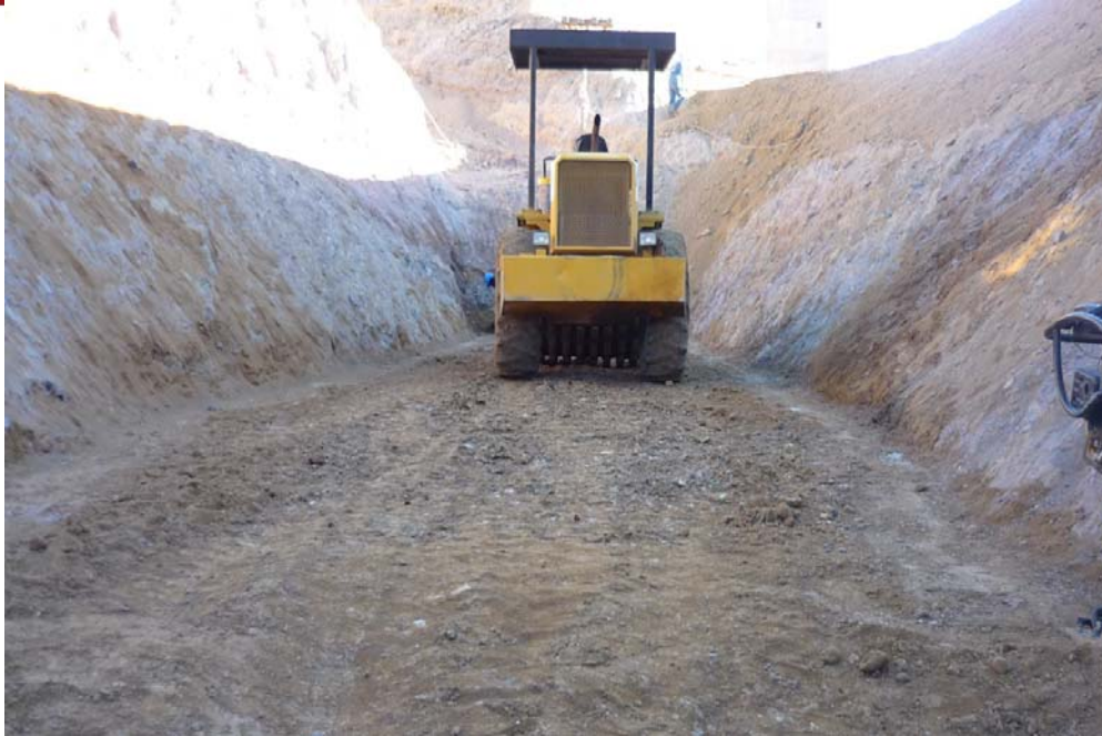
Figura 2.14 Relleno de uña de delantal Fuente: Gerencia Regional de Infraestructura (2010)
