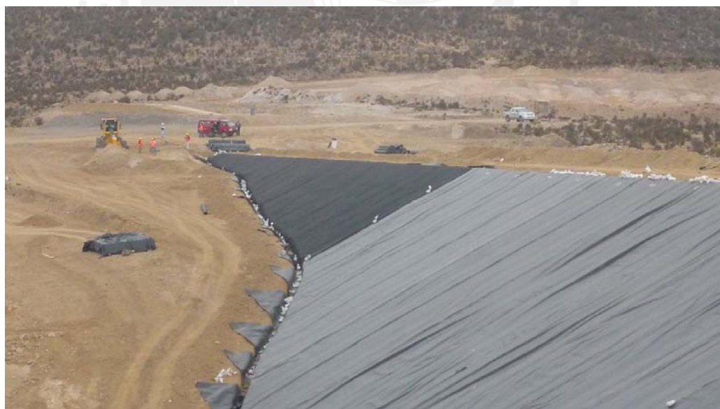
Figura 2.41 Colocación de Geomembranas Fuente: Gerencia Regional de Infraestructura (2010)
