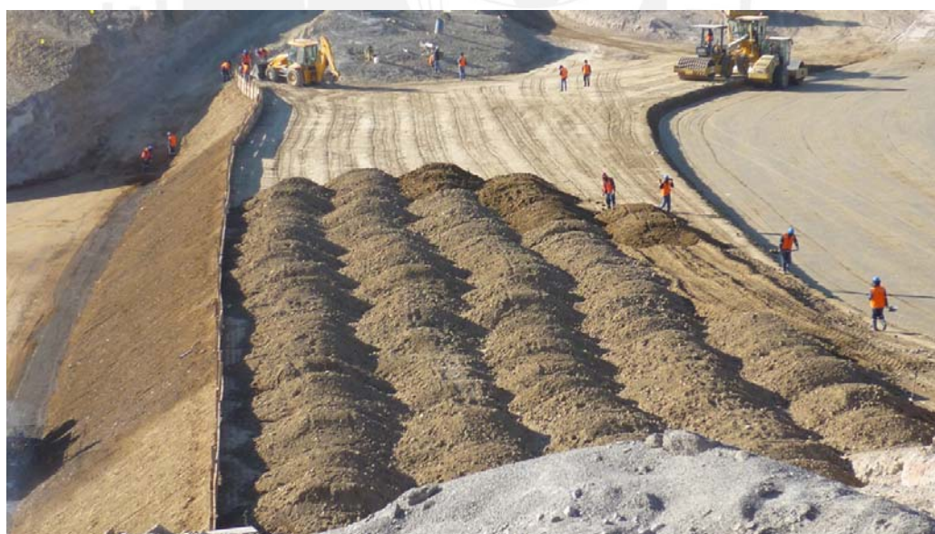
Figura 2.25 Relleno cuerpo de presa Fuente: Gerencia Regional de Infraestructura (2010)
