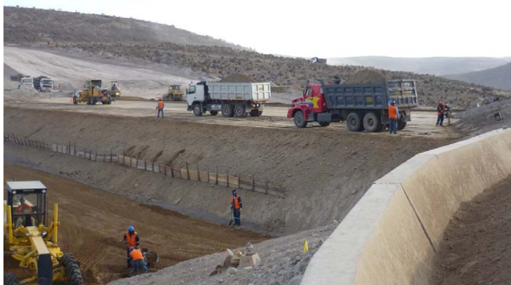
Figura 2.22 Relleno cuerpo de presa Fuente: Gerencia Regional de Infraestructura (2010)
