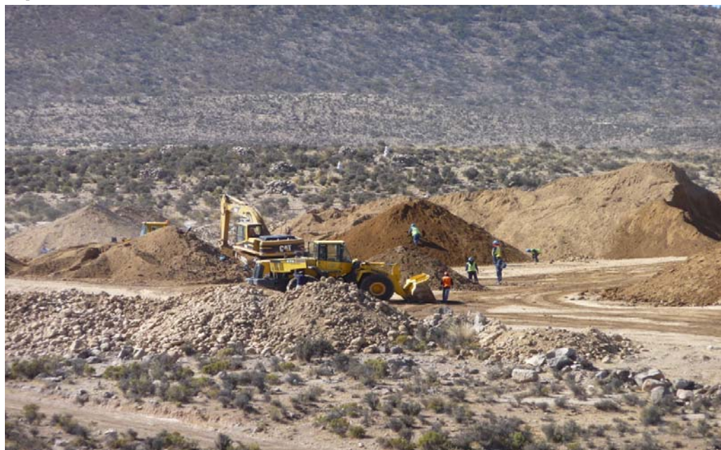
Figura 1.1 Operaciones en las canteras Fuente: Propia
