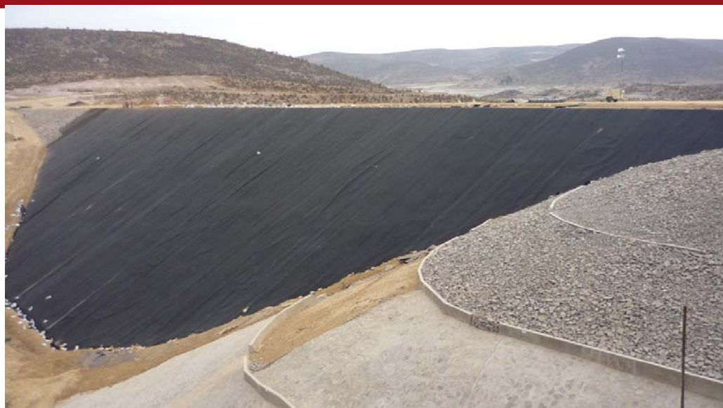
Figura 2.42 Colocación de Geomembranas Fuente: Gerencia Regional de Infraestructura (2010)
