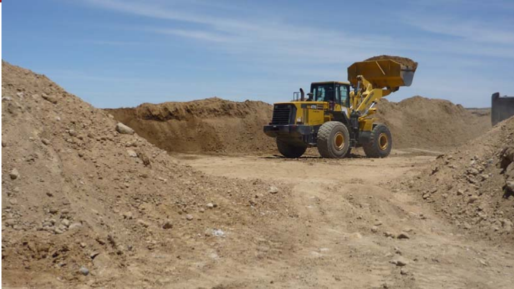
Figura 1.4 Operaciones en las canteras Fuente: Propia
