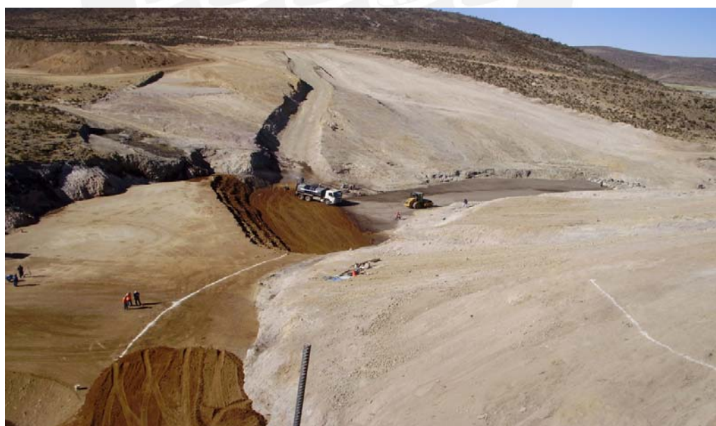
Figura 2.17 Relleno cuerpo de presa Fuente: Gerencia Regional de Infraestructura (2010)
