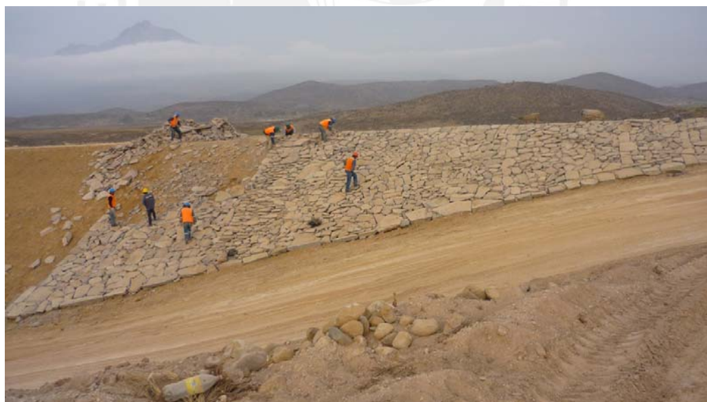
Figura 2.43 Protección de Enrocado Aguas Abajo Fuente: Gerencia Regional de Infraestructura (2010)
