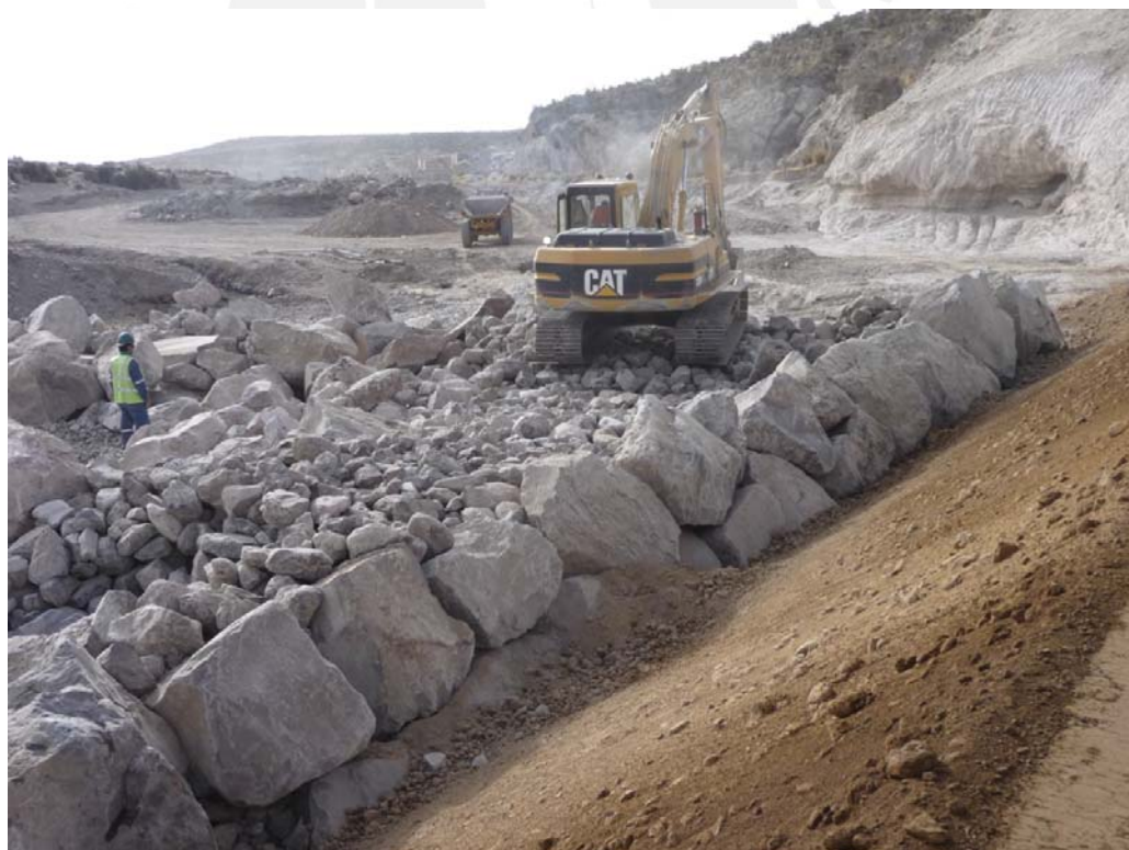
Figura 2.33 Relleno de Prisma Enrocado Fuente: Gerencia Regional de Infraestructura (2010)
