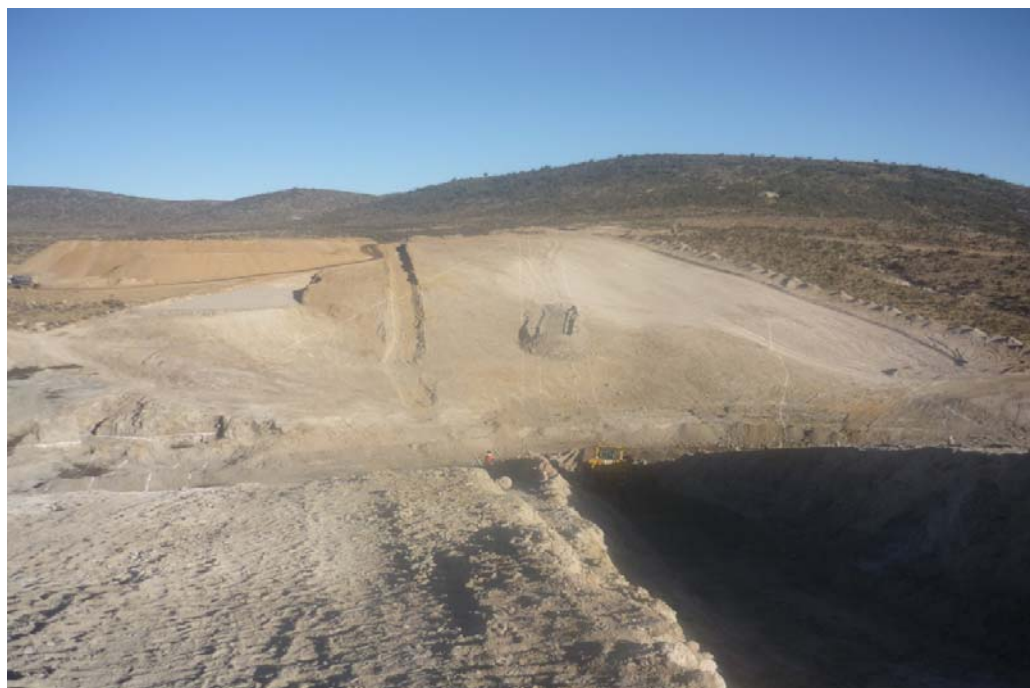
Figura 2.3 Avance delantales en ambos márgenes Fuente: Gerencia Regional de Infraestructura (2010)
