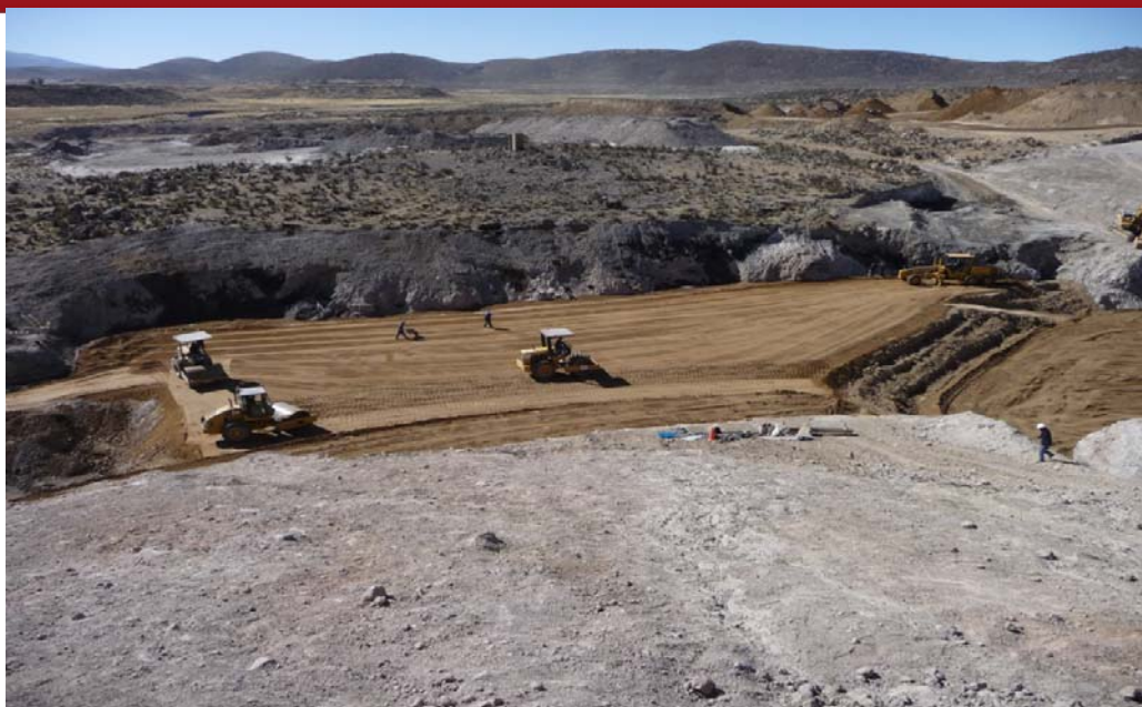
Figura 2.18 Relleno cuerpo de presa Fuente: Gerencia Regional de Infraestructura (2010)
