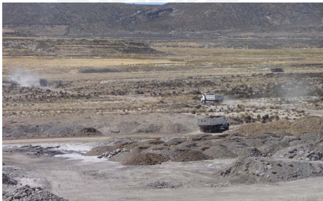
Figura 1.2 Operaciones en las canteras
