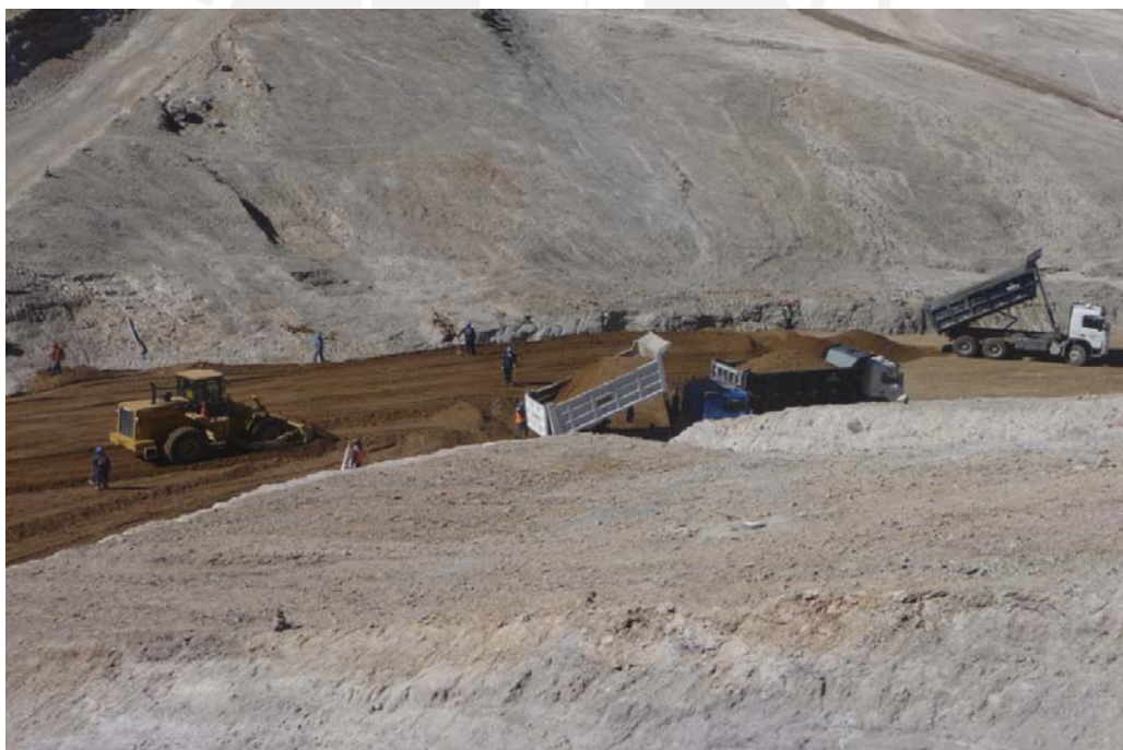
Figura 2.19 Relleno cuerpo de presa Fuente: Gerencia Regional de Infraestructura (2010)
