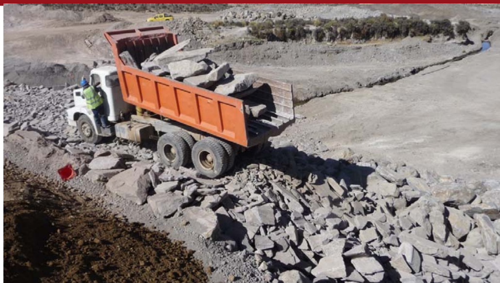
Figura 2.32 Relleno de Prisma Enrocado Fuente: Gerencia Regional de Infraestructura (2010)
