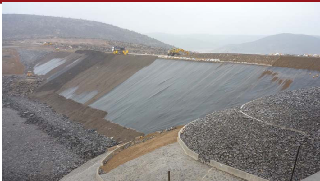
Figura 2.46 Protección de Enrocado Aguas Arriba Fuente: Gerencia Regional de Infraestructura (2010)
