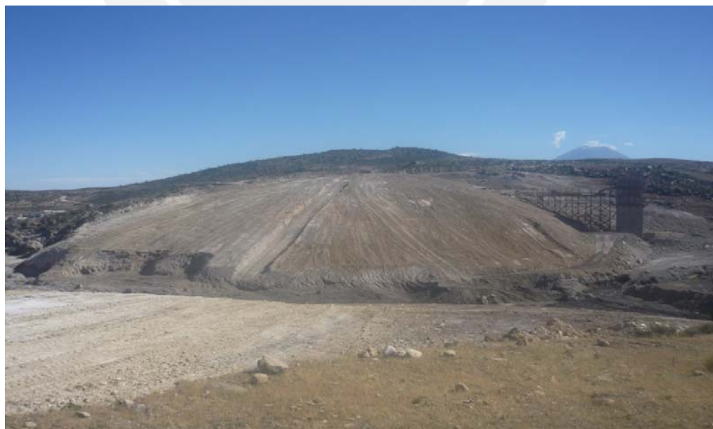
Figura 2.2 Avance del delantal y limpieza del perfil Fuente: Gerencia Regional de Infraestructura (2010)
