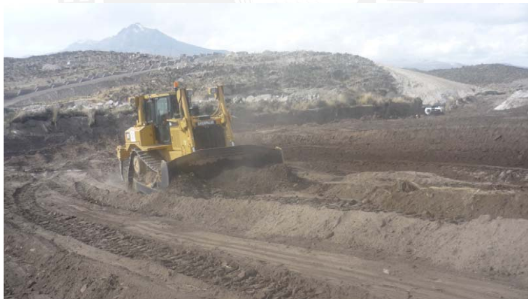
Figura 2.6 Relleno cuerpo de presa Fuente: Gerencia Regional de Infraestructura (2010)
