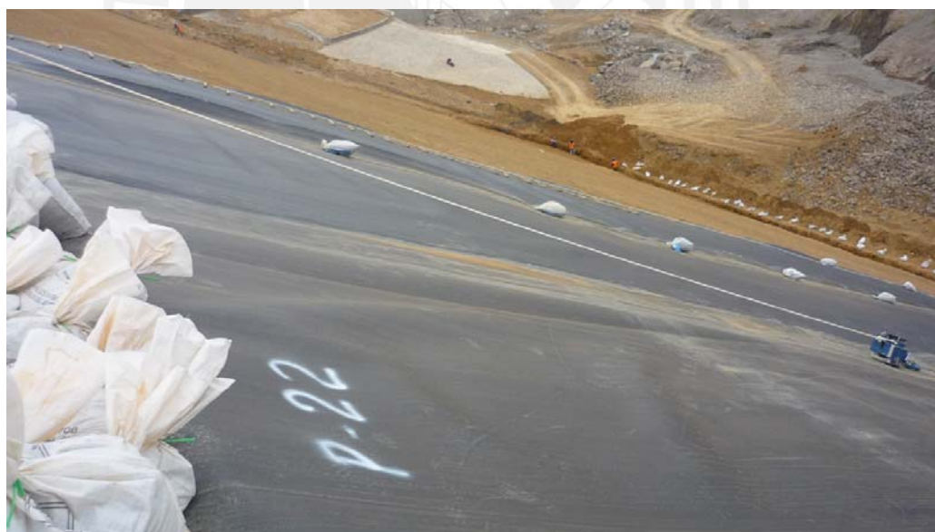
Figura 2.39 Colocación de Geomembranas Fuente: Gerencia Regional de Infraestructura (2010)
