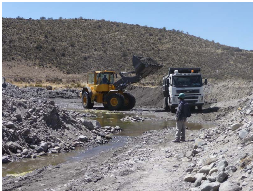
Figura 1.3 Operaciones en las canteras Fuente: Propia
