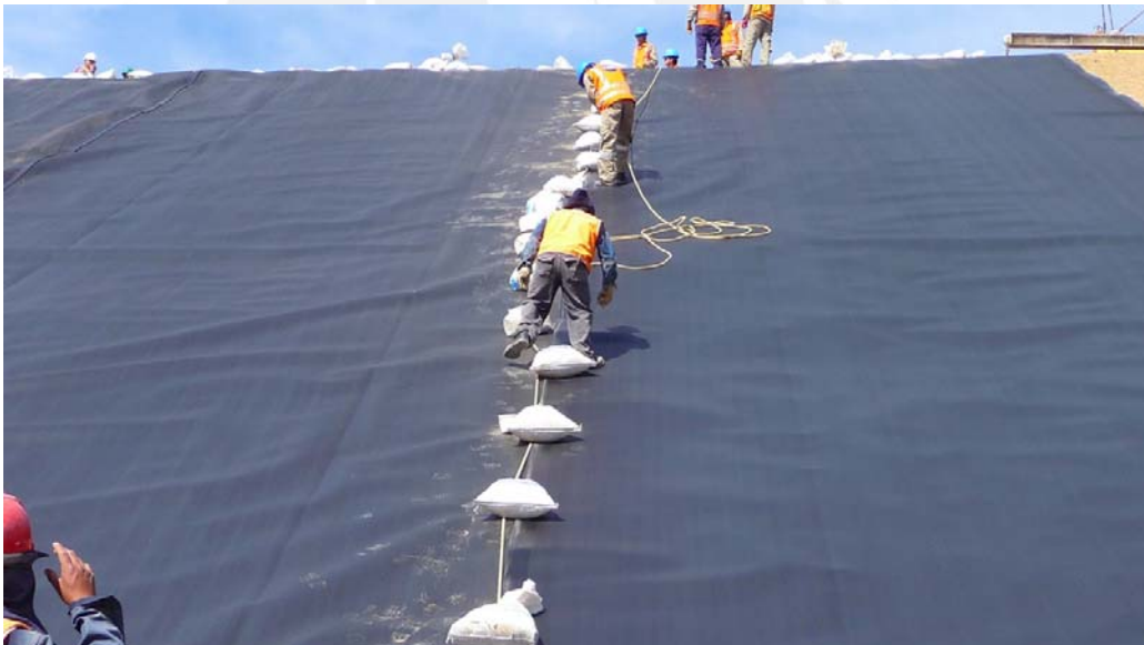
Figura 2.37 Colocación de Geomembranas Fuente: Gerencia Regional de Infraestructura (2010)
