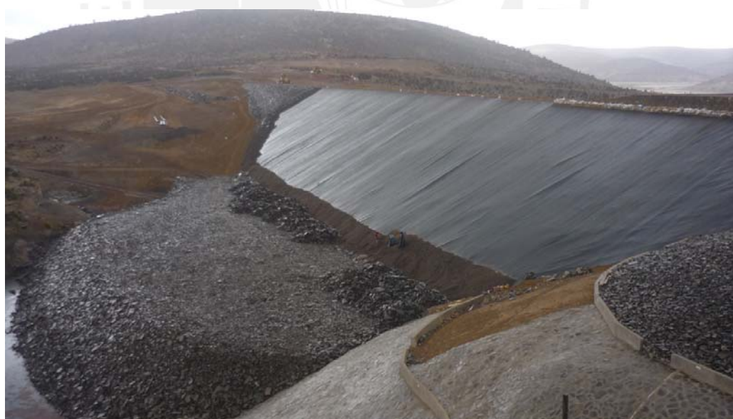
Figura 2.45 Protección de Enrocado Aguas Arriba Fuente: Gerencia Regional de Infraestructura (2010)
