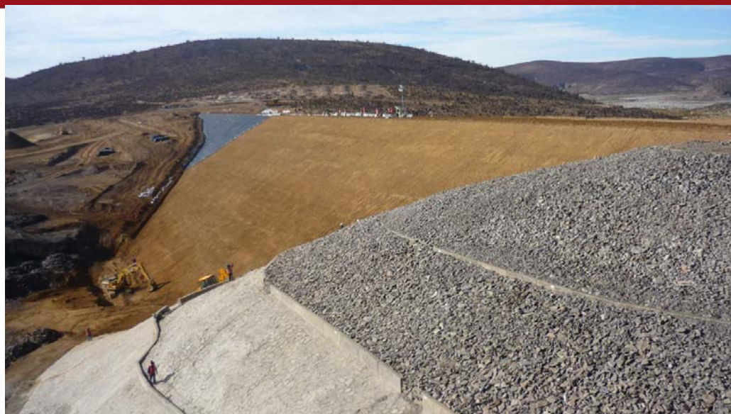
Figura 2.38 Colocación de Geomembranas Fuente: Gerencia Regional de Infraestructura (2010)
