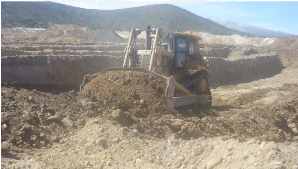
Figura 1.5 Operaciones en las canteras Fuente: Propia
