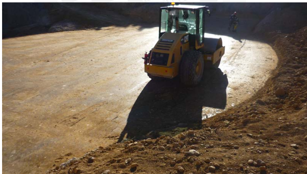
Figura 2.9 Relleno cuerpo de presa Fuente: Gerencia Regional de Infraestructura (2010)
