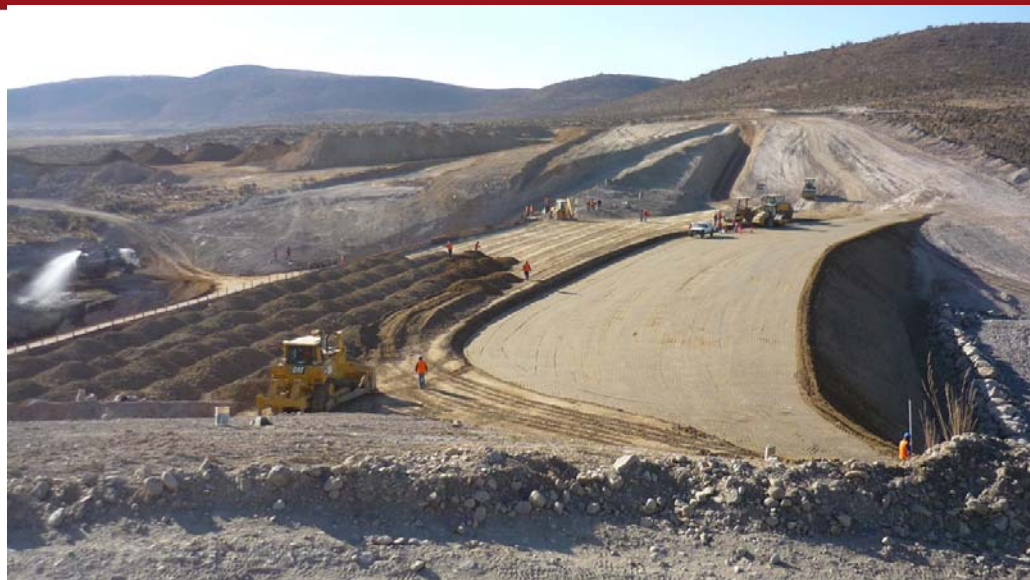
Figura 2.24 Relleno cuerpo de presa Fuente: Gerencia Regional de Infraestructura (2010)
