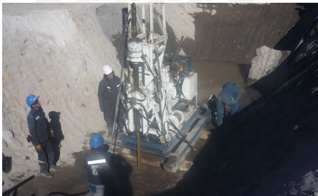
Figura 2.4 Perforaciones Fuente: Gerencia Regional de Infraestructura (2010)
