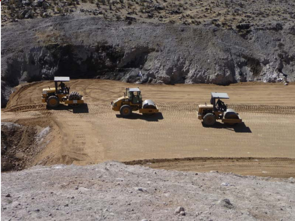
Figura 2.20 Relleno cuerpo de presa Fuente: Gerencia Regional de Infraestructura (2010)
