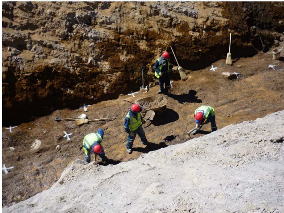
Figura 2.15 Relleno de uña de delantal Fuente: Gerencia Regional de Infraestructura (2010)
