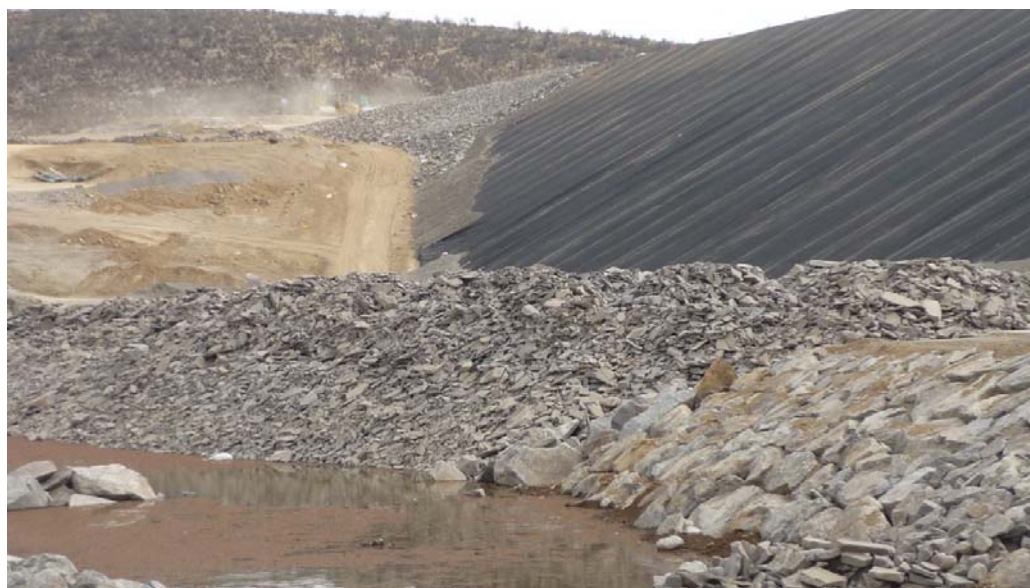
Figura 2.44 Protección de Enrocado Aguas Arriba Fuente: Gerencia Regional de Infraestructura (2010)
