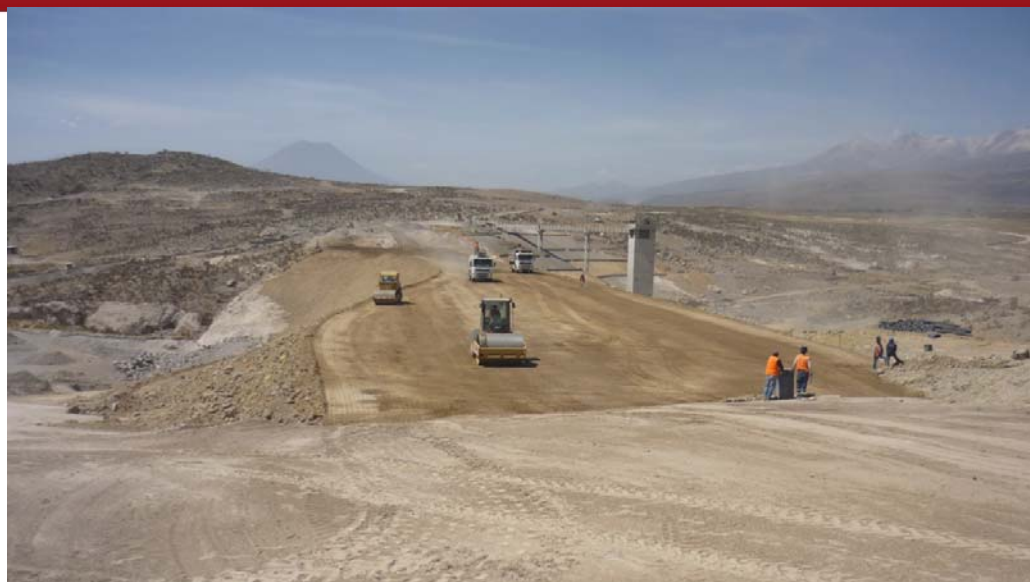
Figura 2.28 Relleno cuerpo de presa Fuente: Gerencia Regional de Infraestructura (2010)
