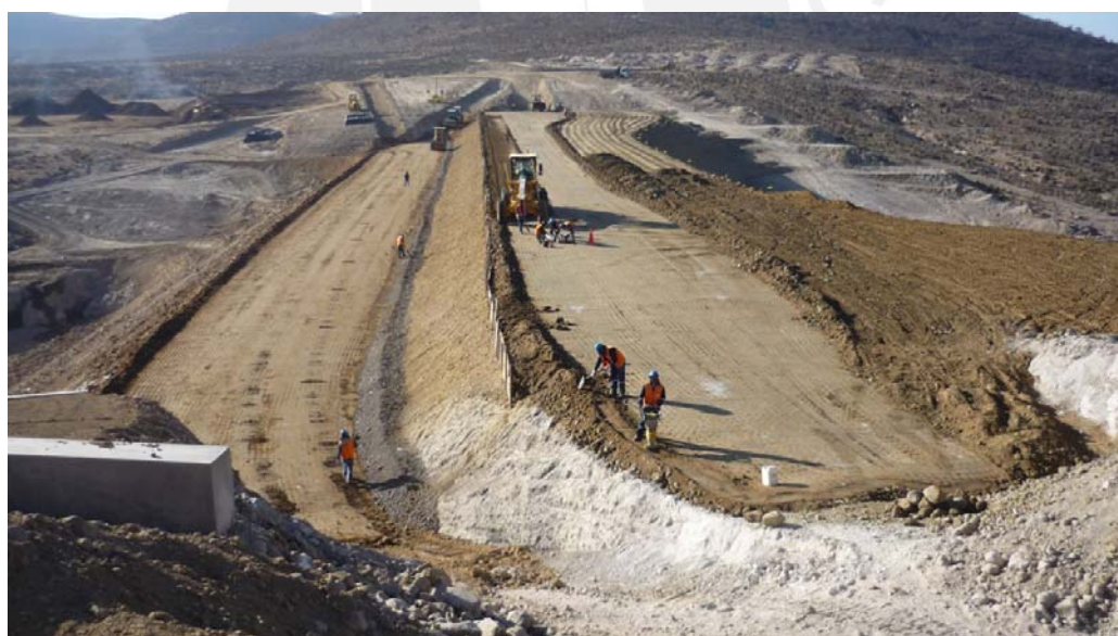
Figura 2.27 Relleno cuerpo de presa Fuente: Gerencia Regional de Infraestructura (2010)
