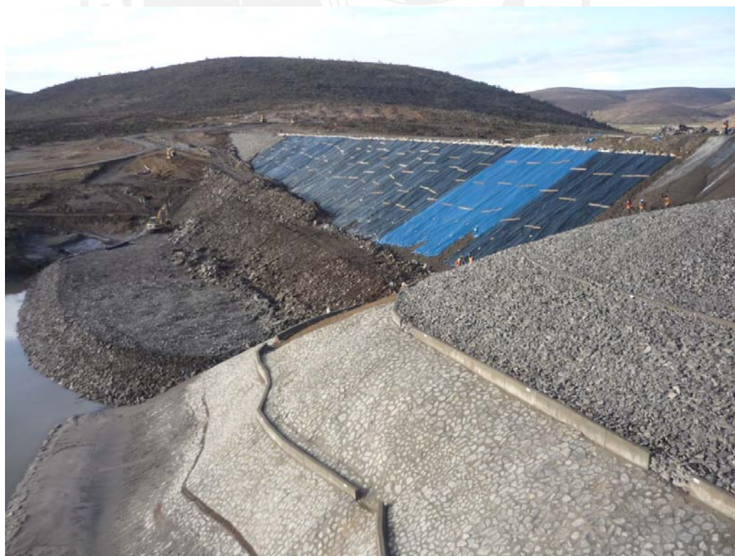
Figura 2.47 Protección de Enrocado Aguas Arriba Fuente: Gerencia Regional de Infraestructura (2010)
