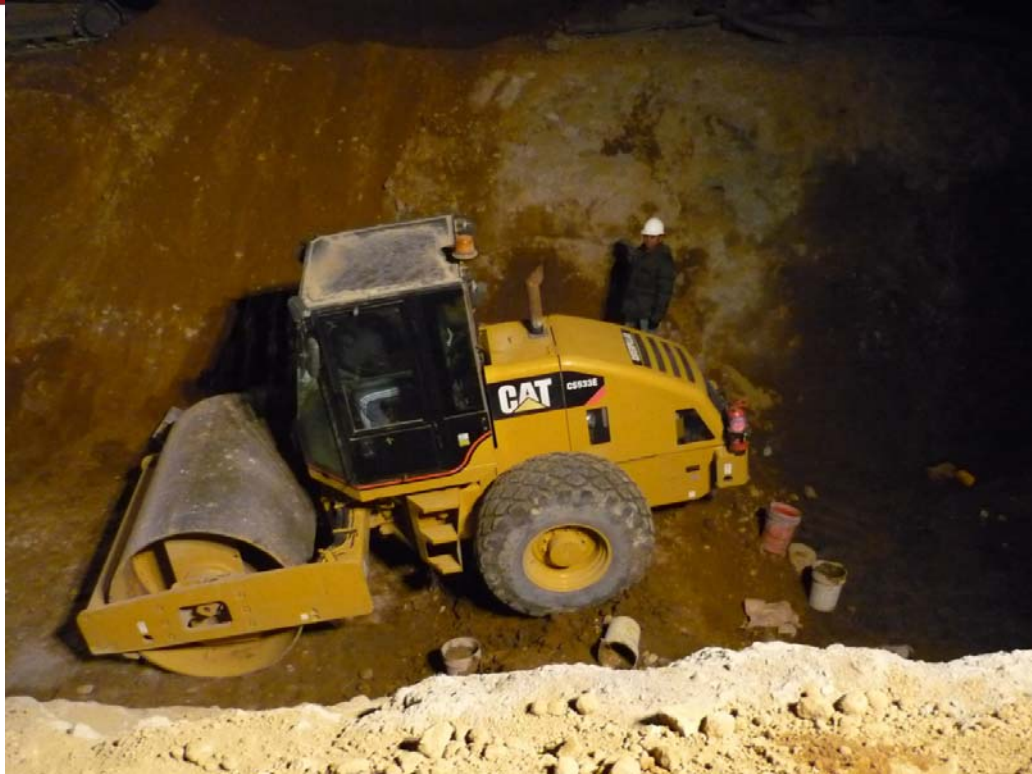
Figura 2.10 Relleno de uña de delantal Fuente: Gerencia Regional de Infraestructura (2010)
