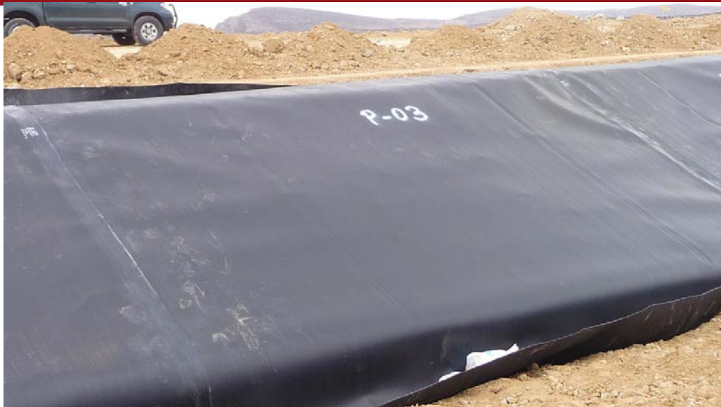
Figura 2.34 Colocación de Geomembranas Fuente: Gerencia Regional de Infraestructura (2010)
