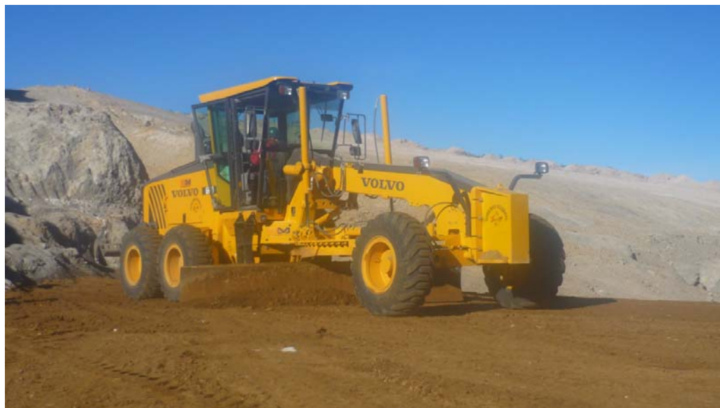
Figura 2.5 Relleno cuerpo de presa Fuente: Gerencia Regional de Infraestructura (2010)
