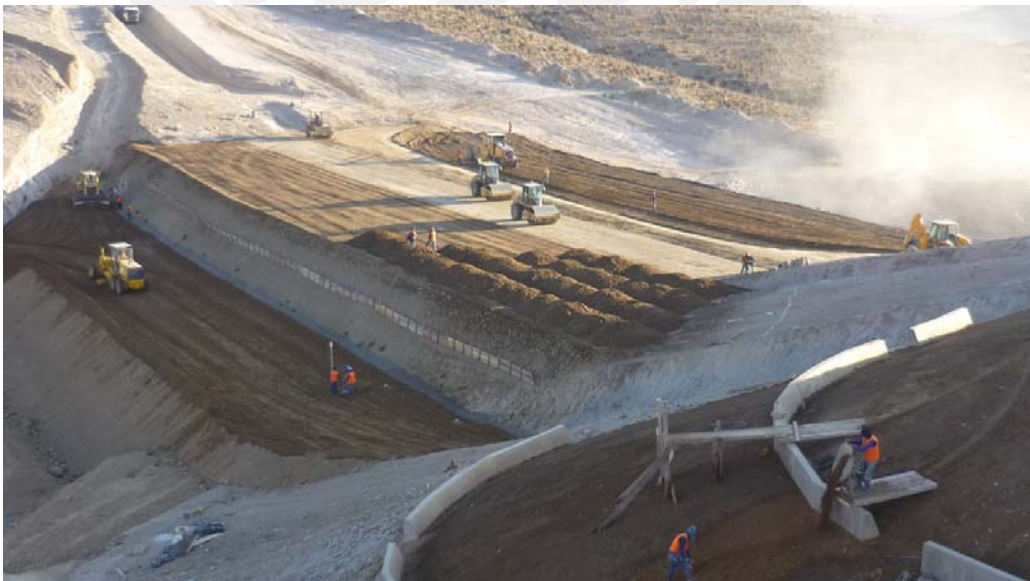
Figura 2.21 Relleno cuerpo de presa Fuente: Gerencia Regional de Infraestructura (2010)
