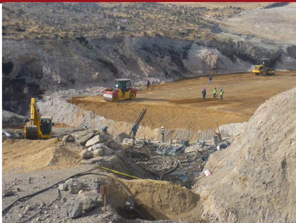
Figura 2.8 Relleno cuerpo de presa Fuente: Gerencia Regional de Infraestructura (2010)
