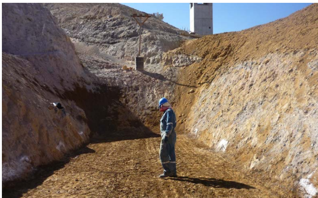
Figura 2.12 Relleno de uña de delantal Fuente: Gerencia Regional de Infraestructura (2010)
