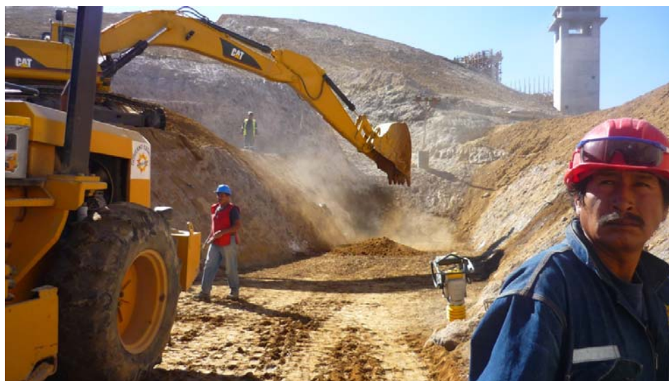
Figura 2.16 Relleno de uña de delantal Fuente: Gerencia Regional de Infraestructura (2010)
