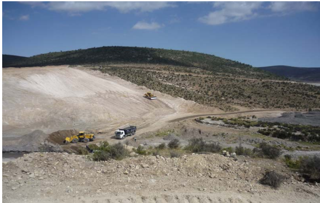
Figura 2.1 Inicio de los trabajos Fuente: Gerencia Regional de Infraestructura (2010)
