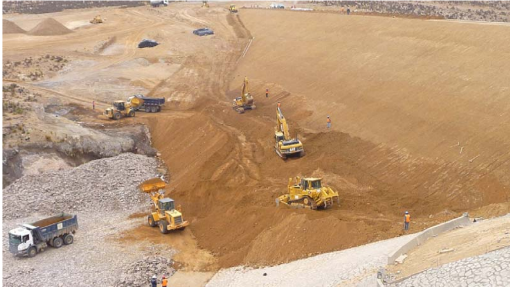
Figura 2.29 Perfilado del Talud Fuente: Gerencia Regional de Infraestructura (2010)
