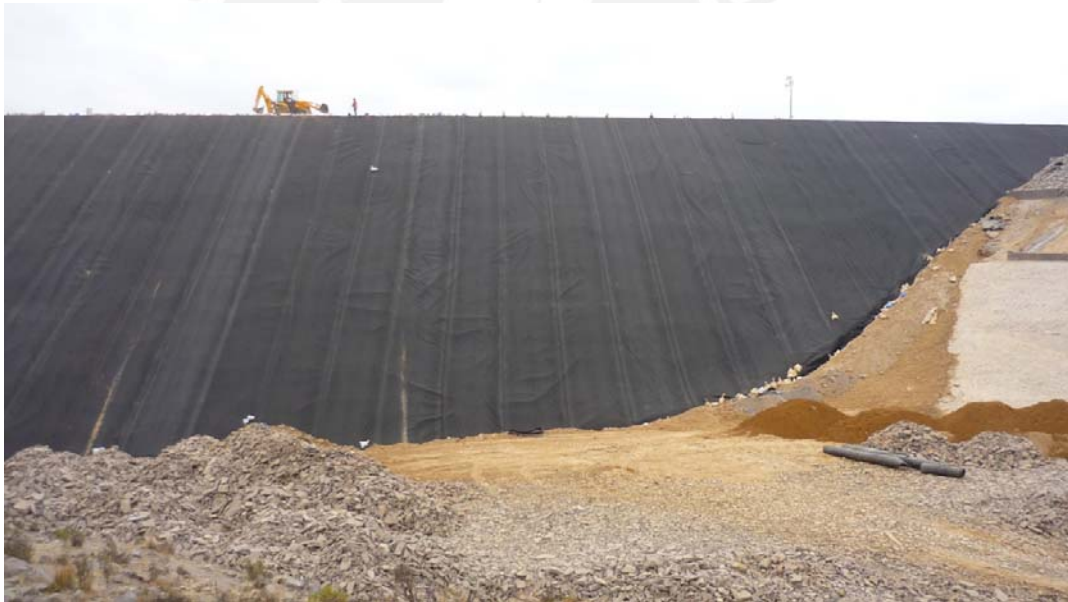
Figura 13: Geomembrana y protección totalmente extendidas aguas arriba
