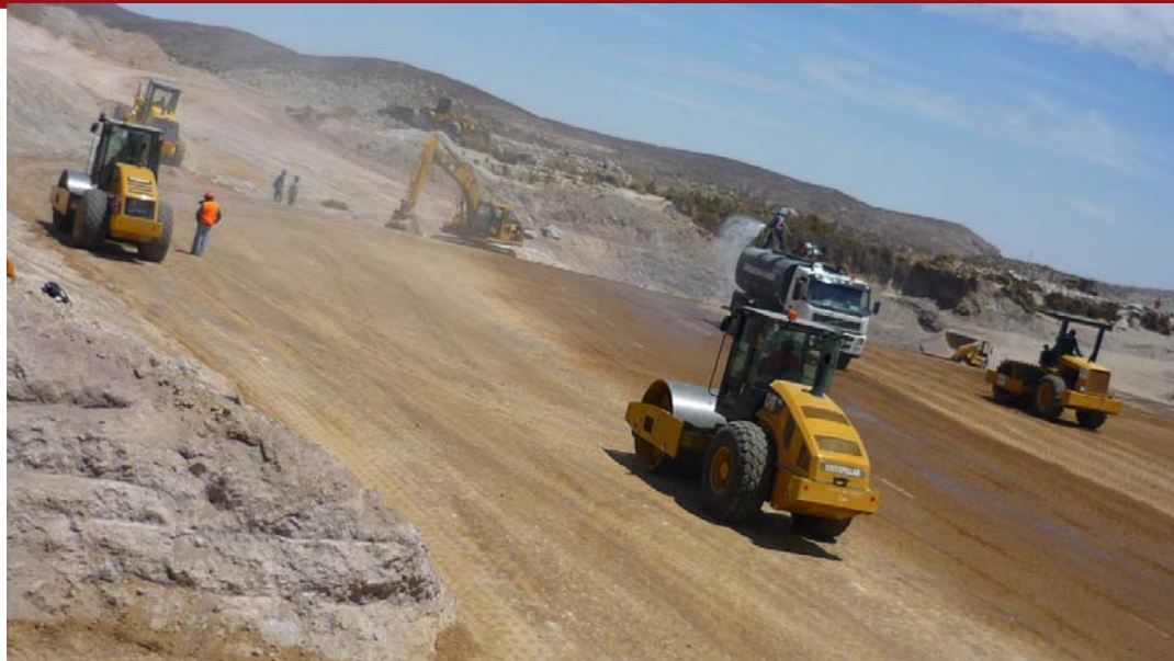
Figura 9: Proceso de compactado de capas en la presa
