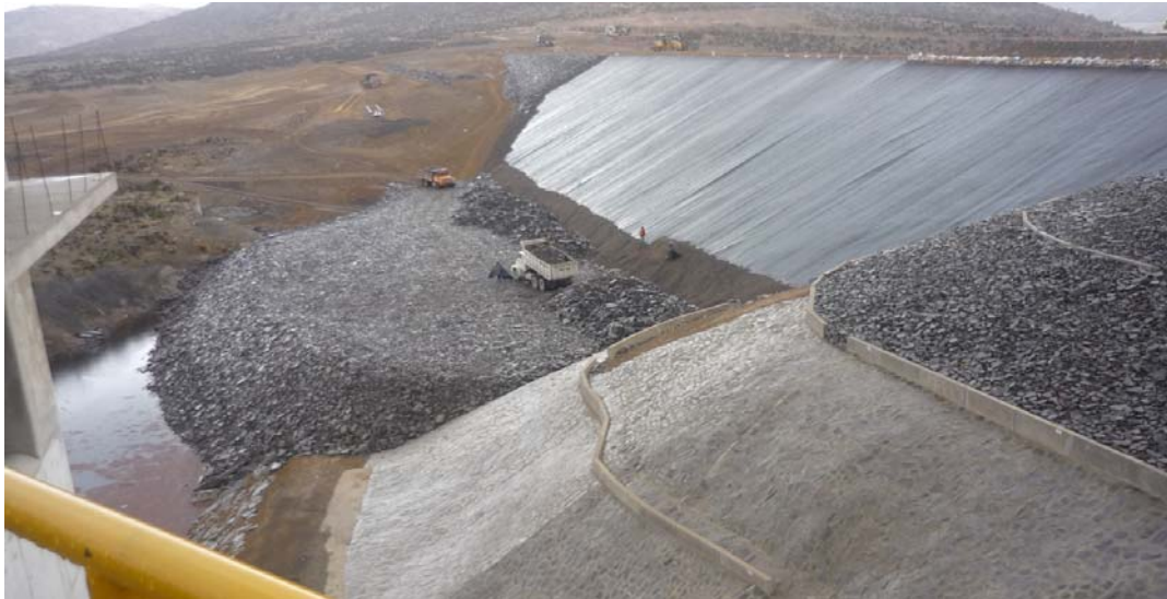
Figura 14: Colocación del enrocado aguas arriba
