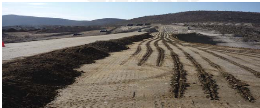
Figura 10: Ranuras para prevenir la falla por corte.
