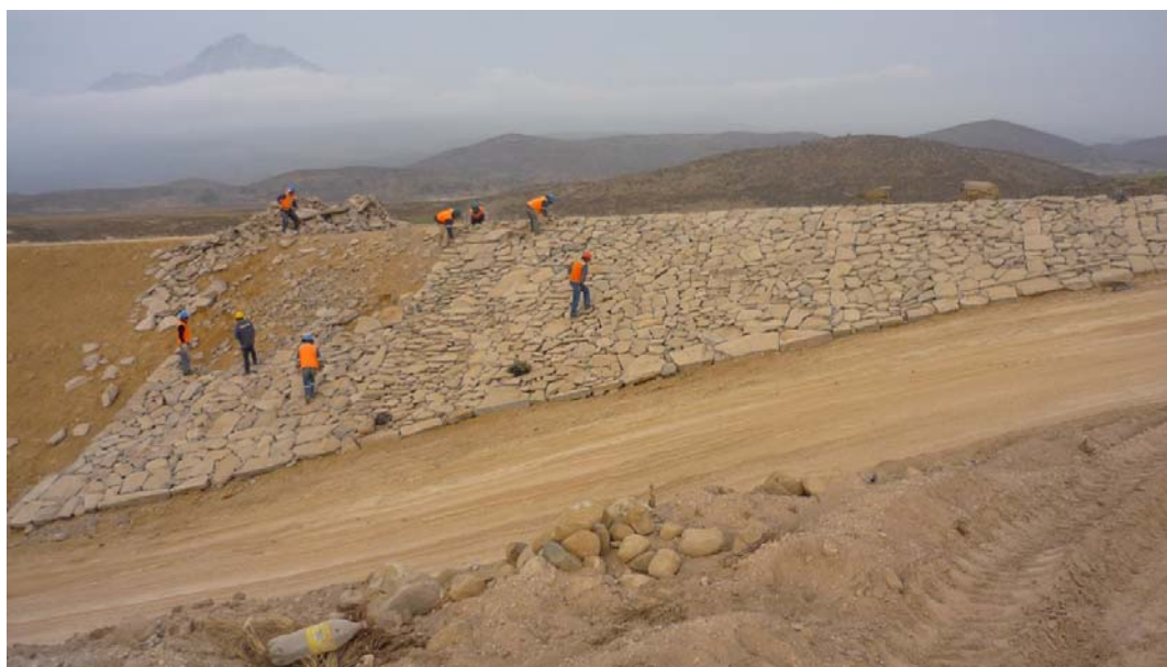
Figura 15: Colocación del enrocado de protección aguas abajo
