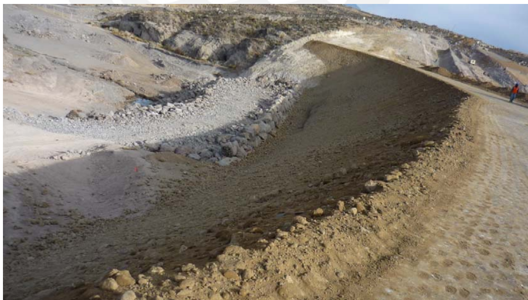
Figura 8: Vista del prisma de enrocado y el acceso lateral para el tractor
