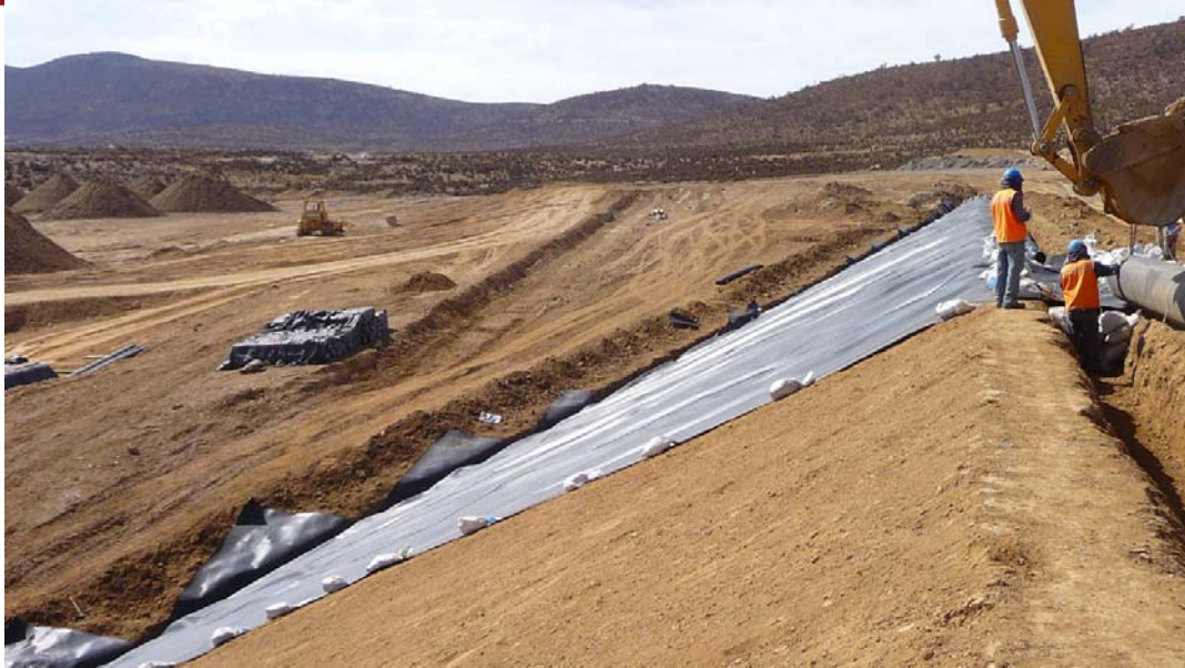
Figura 12: Colocación de la geomembrana con la ayuda de la excavadora, aguas arriba
