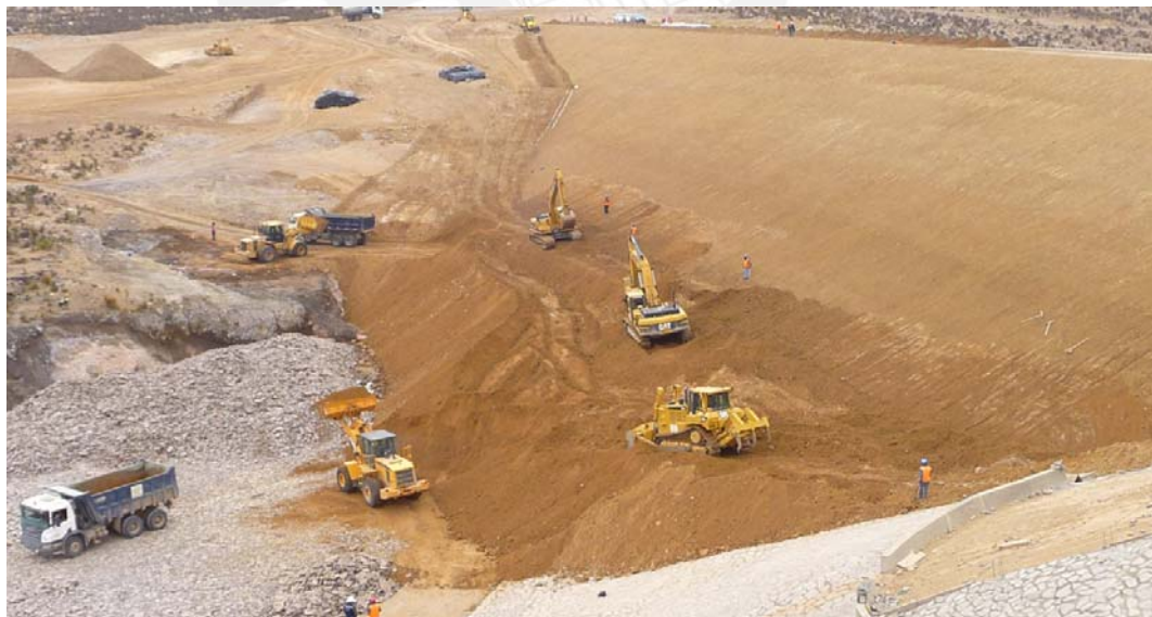
Figura 11: Extendido, emparejado y compactado del material filtro aguas arriba
