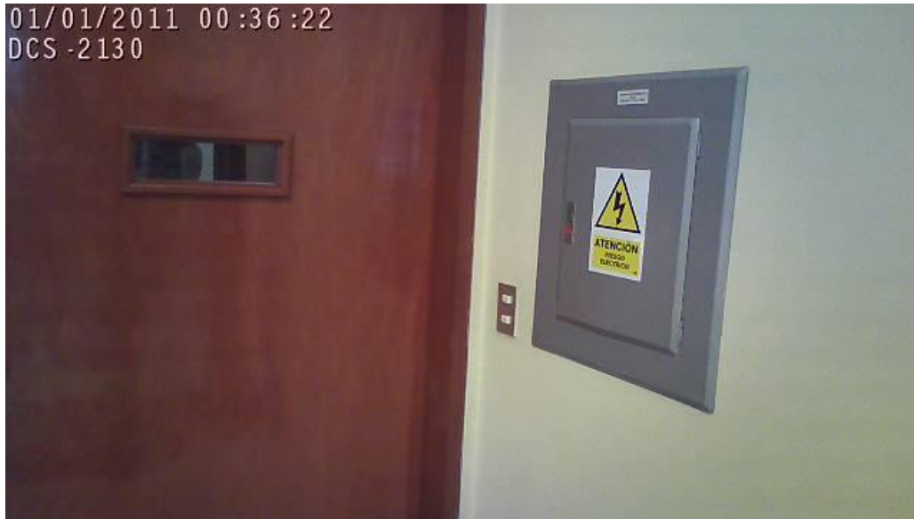
Figura 4.27 Captura de una cámara D-Link DCS-2130 a 640x480 Elaboración propia
