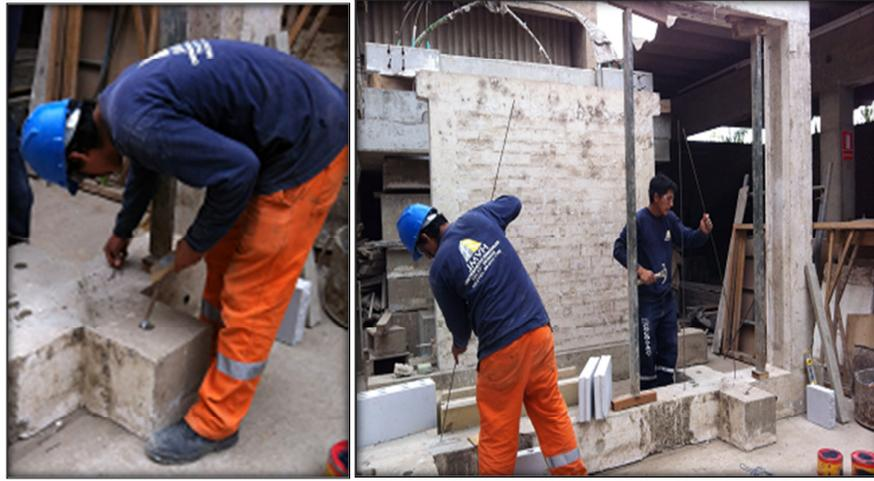
Fig.4.5. Relleno con epóxico de la perforación e inserción de la barra vertical.
