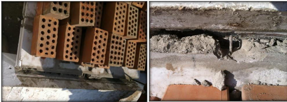
Fig.7.6. Zona de anclaje con Sikadur 31 después del colapso
