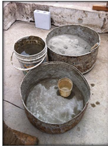
Fig.4.7. Preparación del mortero y del grout
