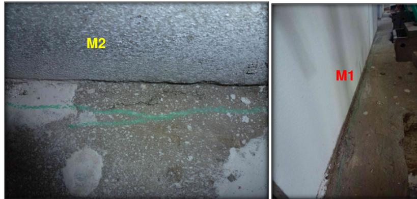
Fig. 5.4: Fisuras en la base de los tabiques después de la Fase 2.
