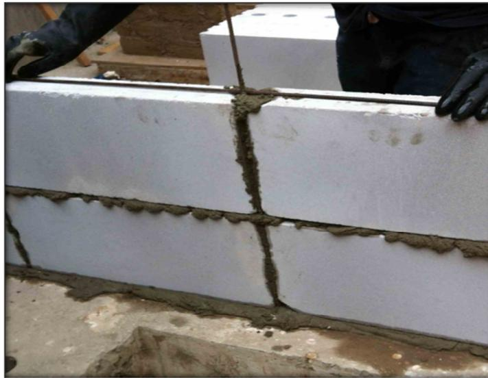
Fig.3.2. Varillas de Ø 6 mm en el espécimen M2.
