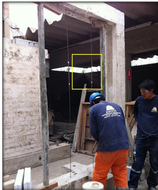
Fig.4.6. Traslapo del refuerzo vertical inferior y superior.
