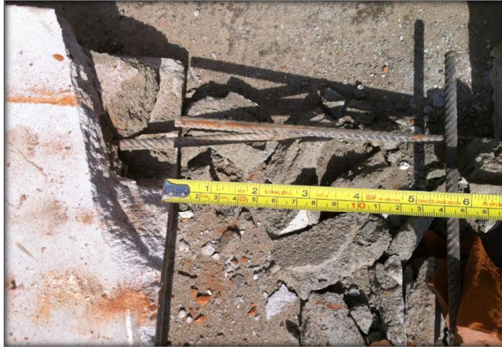
Fig.7.8 Traslape de barras verticales después del colapso
