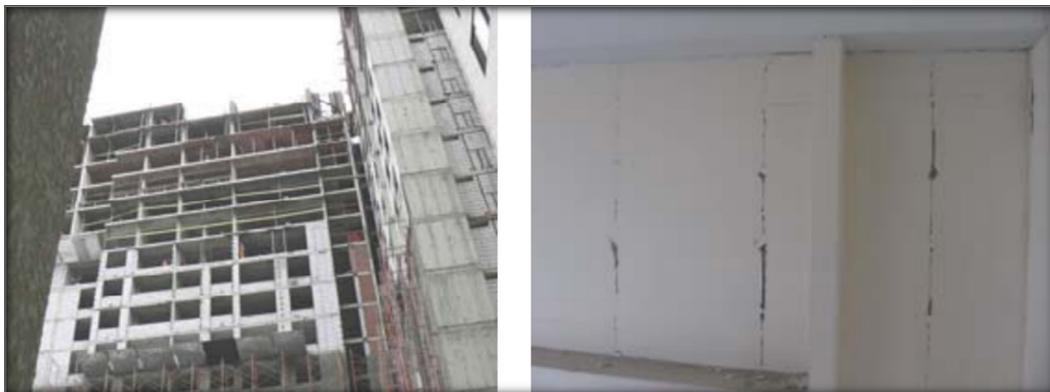
Fig.1.4. Sismo de Pisco del 2007 (Ref.1.4), grietas verticales en pilares de placa P-7.
