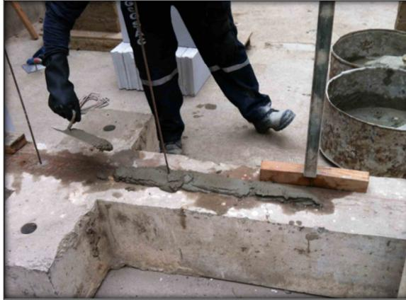
Fig.4.8. Capa de mortero para el asentado de la primera hilada.
