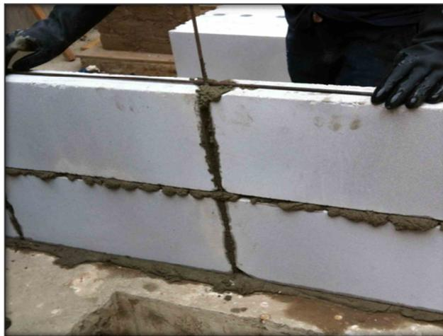
Fig.4.9. Instalación del refuerzo horizontal.
