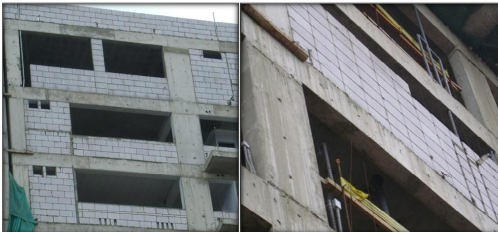
Fig.1.1 Tabique P-7 asentado en forma de pilares (izq.) y en forma traslapada (der.).
