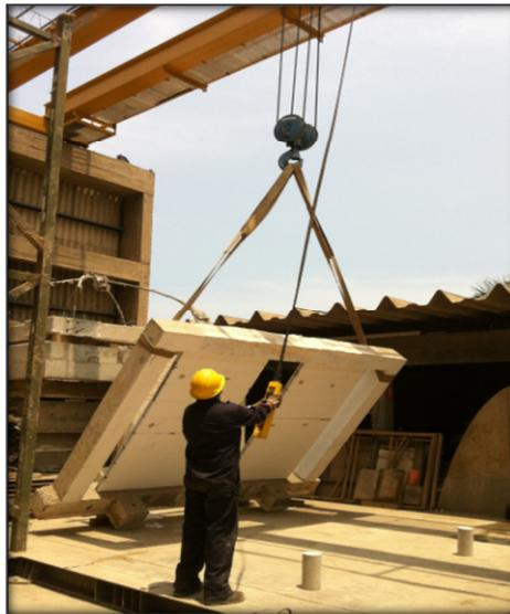
Fig.7.1. Rotación de Pórtico en  $90^\circ$
