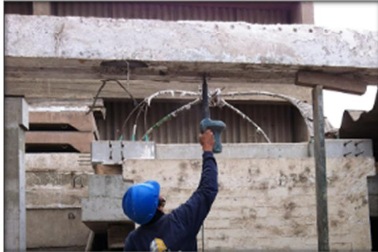
Fig.4.3. Limpieza de puntos perforados
