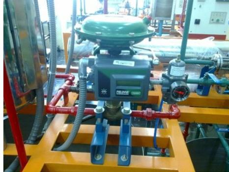
Fig. 3.6: Válvula neumática-proporcional instalada en la planta
