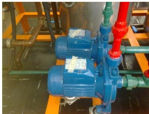
Fig. 3.7: Bombas centrífugas instaladas en la planta
