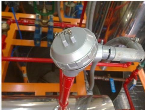
Fig. 3.5: Transmisor de temperatura Pt-100 ubicado en la planta
