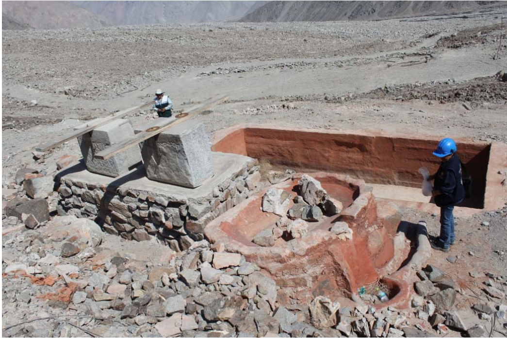
Descripción: Quimbales y pozas en estado de abandono en el Distrito de Yanaquihua, provincia de Condesuyos, Arequipa.
